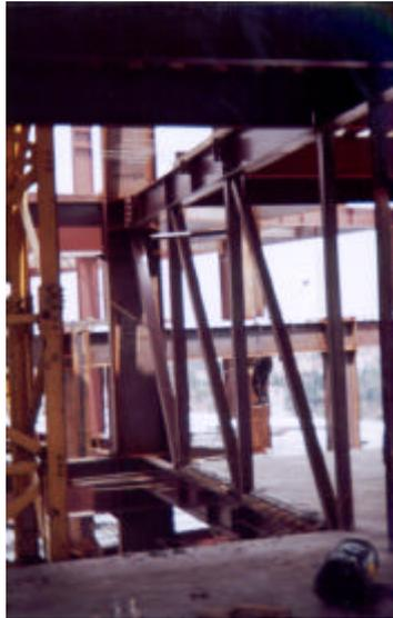
Figura 3.21b. Arreglo Típico De Armadura Alternada.
