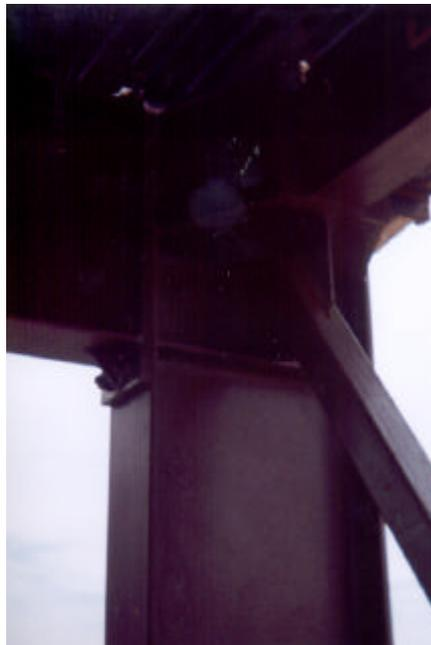
Figura 3.21a. Detalle de conexión de Cuerda Superior de Armadura Alternada a columna.
