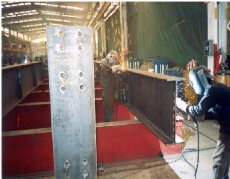
Procedimiento de Limpieza a Elemento Estructural (Esmerilado).
