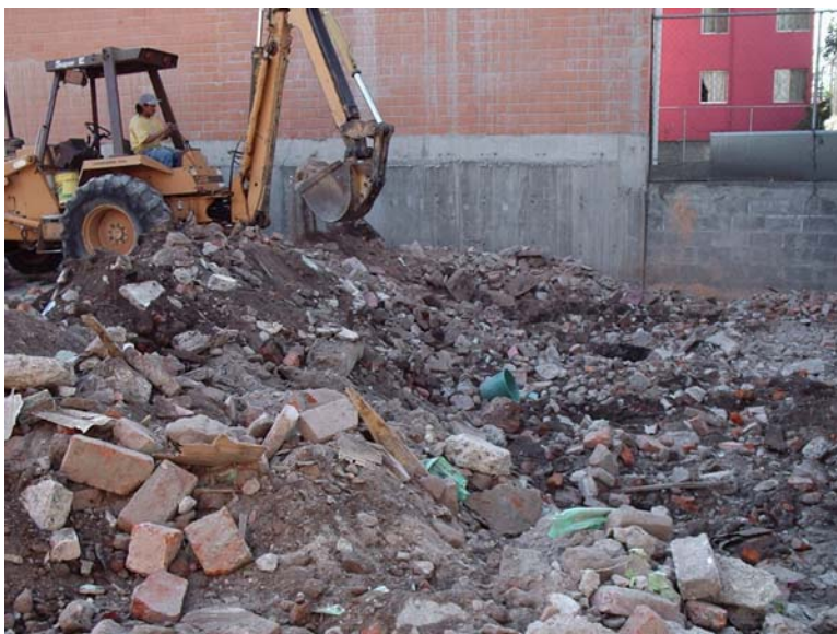
Excavación de suelo contaminado (relleno) a una profundidad de 80 cms.
