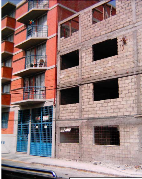
Proceso de la obra en Corregidora No. 5 col. Santa Anita.
