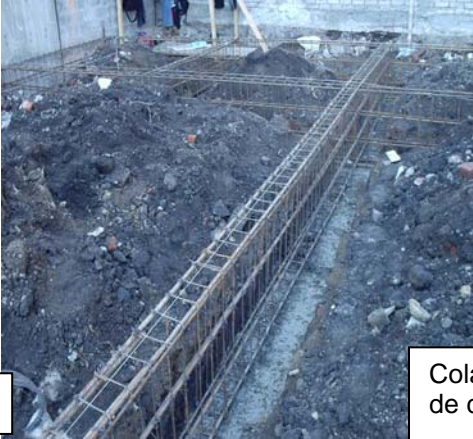
Armado de contratraves de cimentación.
