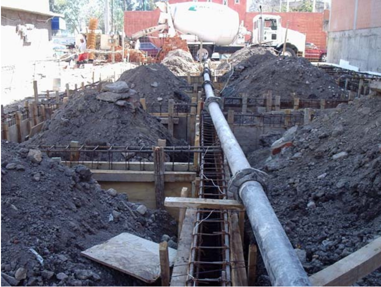
Cimbra y colado de contratraves de cimentación.
