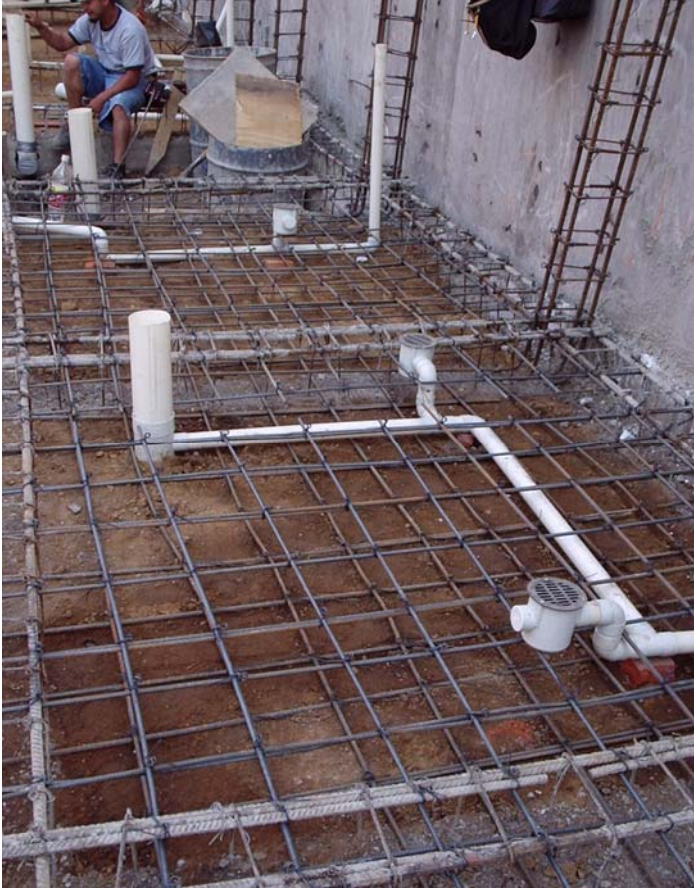
Preparación para instalación sanitaria.
