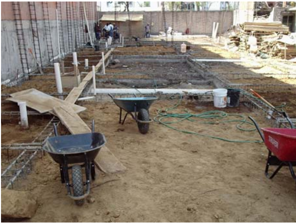
Armado de contratraves de cimentación.
