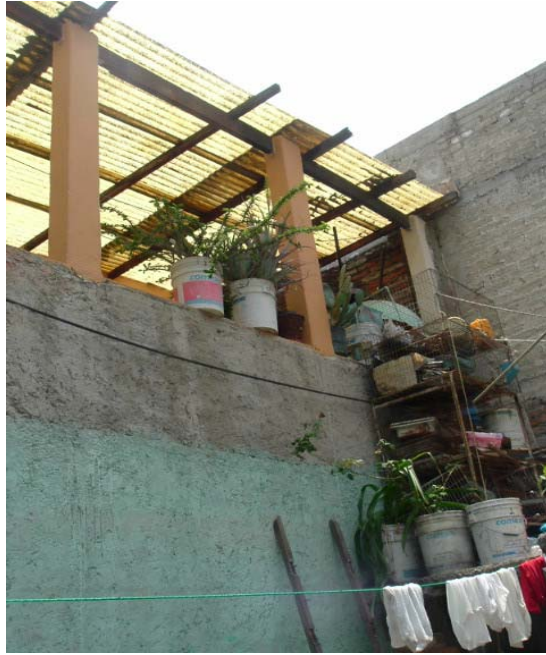
Vivienda nueva en tercer nivel antes de la intervención.
