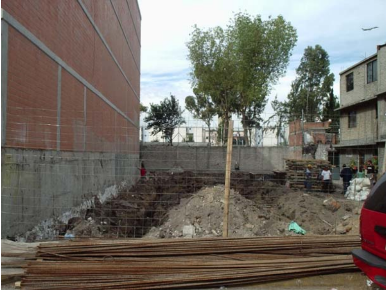
Excavación de cepas a cielo abierto para contrarribes de cimentación.
