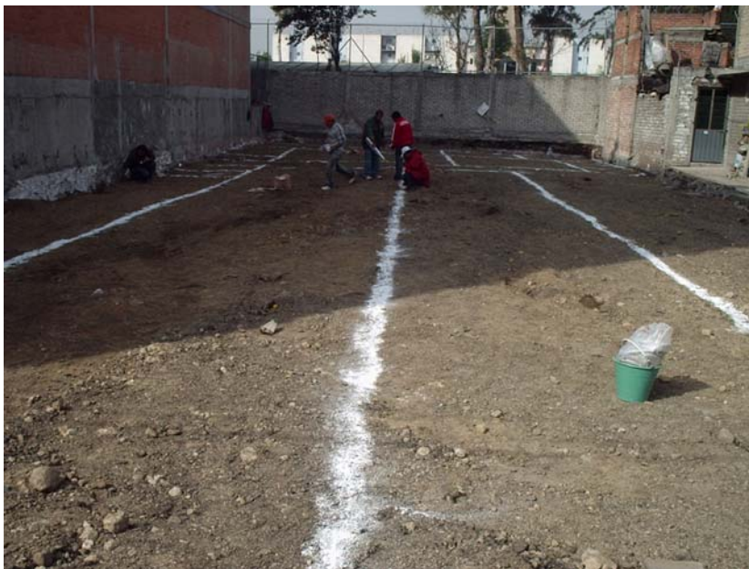
Relleno compactado de tepetate en capas de 20 cms. y compactada al 95% con bailarina.
