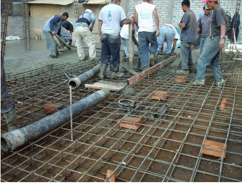
Colado de losa de cimentación.
