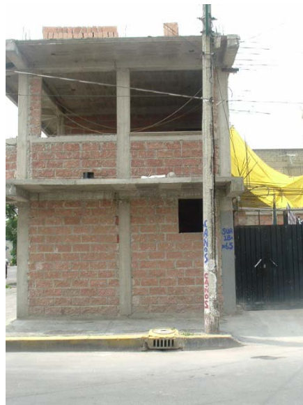
Vivienda nueva en dos niveles, área de desplante 42 m2.
