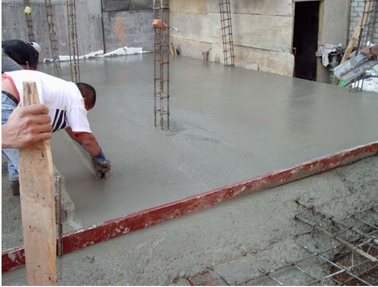
Colado de losa de cimentación.
