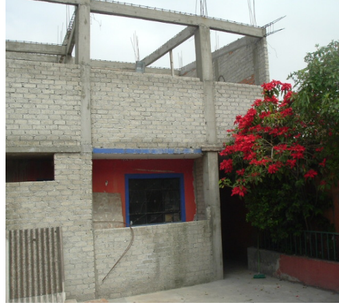
Ampliación de vivienda después de la intervención en obra negra.
