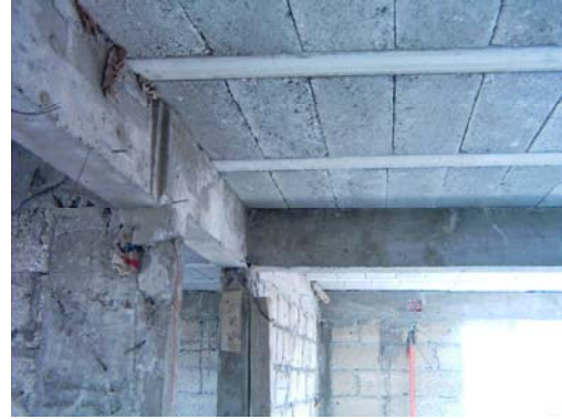
Proceso de la obra en Corregidora No. 5 col. Santa Anita.
