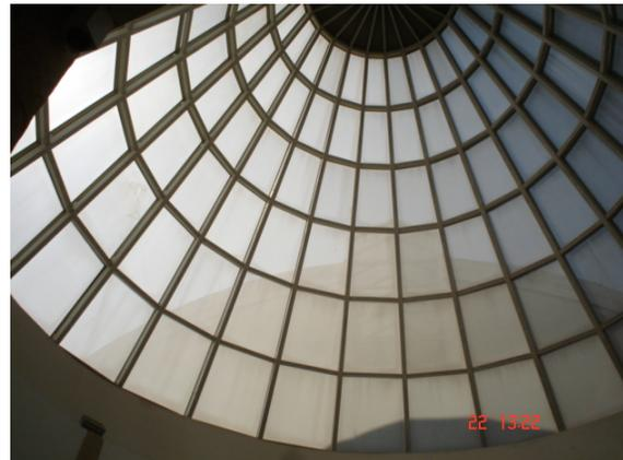
**F-19 domo con estructura de monten y cristales polarizados**
