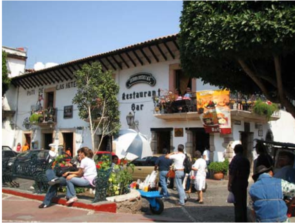
Estado actual (vista desde Plaza Borda)
