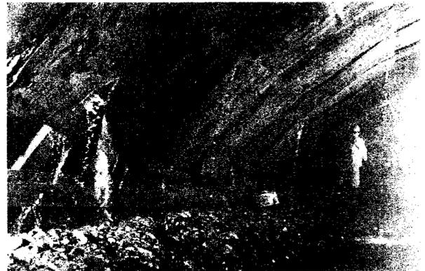
Figura 5.29 Infiltraciones en el frente del túnel
