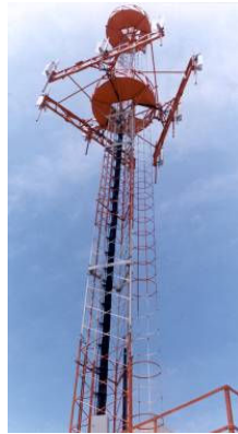
Torre Triangular Autosoportante
