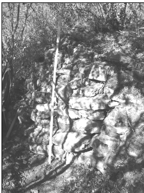
Figura 5.9. Muro de contención de la terraza en la que se excavó el pozo 5 y que forma parte del conjunto bajo el brazo oriental.
