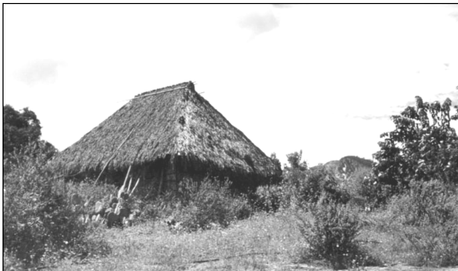
Figura 36. Unidad doméstica en los alrededores de Herve el Agua. Erigida sobre una plataforma nivelada con piedra y tierra apisonada, utilizando materiales como la hoja de palma ( Brahea dulcis ) para el techo, postes y soportes de ocote ( Pinnus sp.), además de carrizos ( Croton sp.) y lodo para el bajareque de las paredes.
