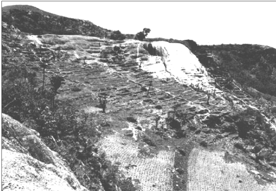
Figura 3.1. Área central del sitio. En primer plano al centro, sistema de terrazas y canales; en la parte superior, plataforma del anfiteatro y zona de manantiales y a la derecha, escurrimientos y canales del brazo oriental ( Neely et al. 1990: 133, fig. 4.7).
