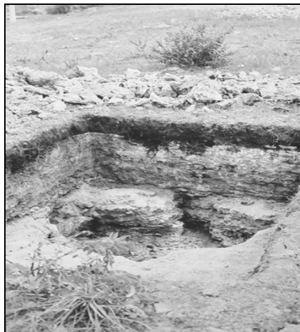
Figura 22. Cimientos del parador turístico en la parte alta del sitio. Bajo la capa de tierra se observa el depósito de travertino formado por manantiales extintos similares a los que se encuentran en el anfiteatro (sin fecha, Fundación Bustamante Vasconcelos).
