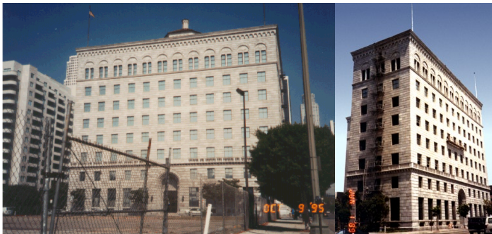
Fig 5.13. Vistas del edificio Los Angeles-9 (Naeim, 1997)
