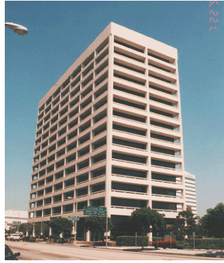
Fig 5.1. Edificio Sherman Oaks-13 (Naeim, 1997)
