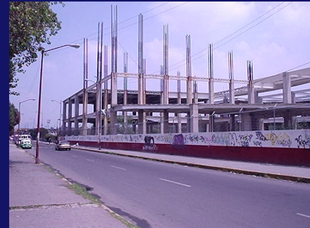
DESDE ACCESO OESTE
