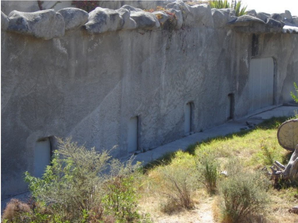
Figura 5. Entrada-salida de la casa de noche.
