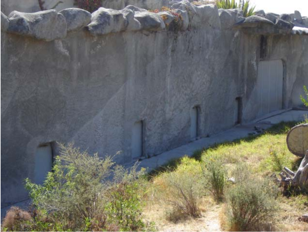
Figura 5. Entrada-salida de la casa de noche.
