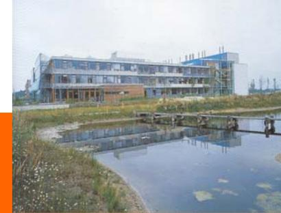
Los ajardinamientos de las cubiertas y la recuperación de las aguas pluviales proveen de agua a los estanques; las cisternas de inodoros regulan el ciclo húmedo.
