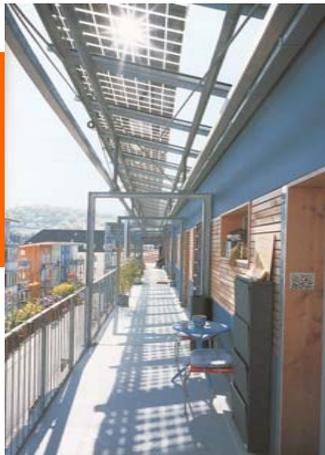
Imagen K.3: Instalación de paneles solares a modo de panelucos en el edificio *Habitat y trabajo* de Friburgo de Brisgovia, Alemania. Proyecto de Common & Gies.
