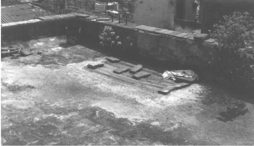
*Daño por humedad en Azotea*
