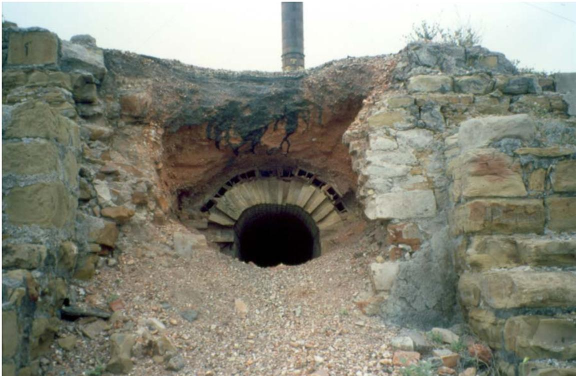
*LÁMINA 23. Detalle de sección transversal de los hornos de coque en Agujita. Adviértanse los materiales pétreos y areniscos empleados en la edificación de los hornos, el ancho de la parte superior es de casi 10 metros. Fotografía tomada por el autor en julio de 2004.*
