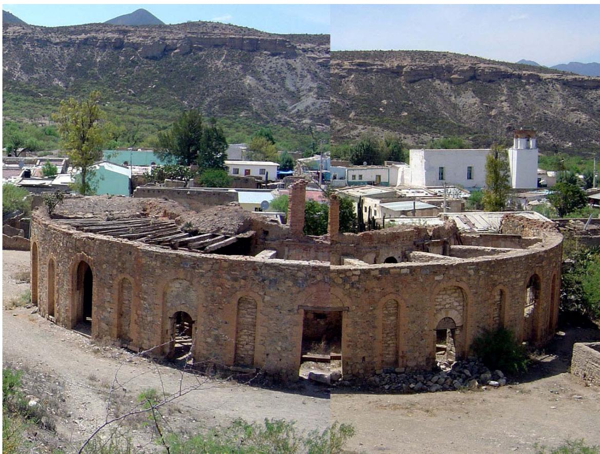
*LÁMINA 5. Vista superior de la fundición de San Gregorio de Bonanza. La toma está hecha desde una elevación que era aprovechada para unir la superficie del suelo con la plataforma de la fundición, a fin de no tener que elevar los minerales. Al fondo se aprecian la capilla de la hacienda y el caserío. Fotografía tomada por el autor en febrero de 2005.*
