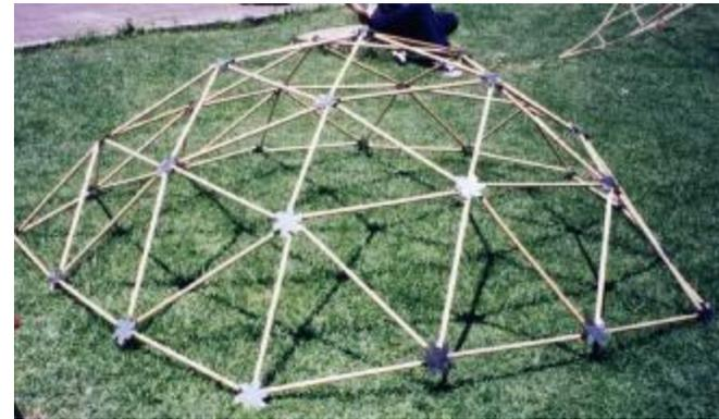
**Imagen 142** Cúpula de frecuencia 3 con madera y nodos de lámina de acero.<sup>151</sup>
