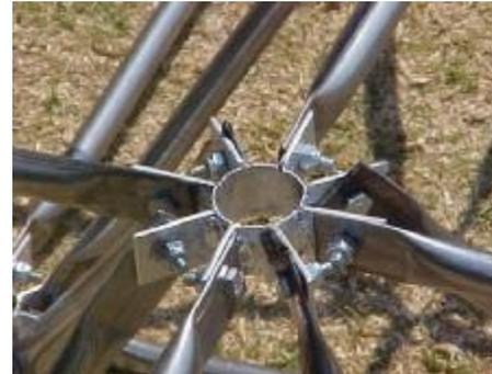
**Imagen 39** Nodo intermedio con soleras de 1 1/2” x 1” x 1/8”, soldadas a sección tubular redonda de 2” de diámetro y tubos de 3/4” atornillados.<sup>48</sup>
