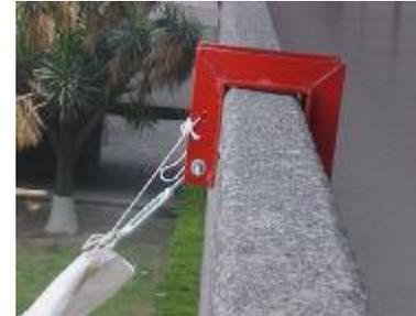
**Imagen 112** anclaje sobre barandal de concreto armado.<sup>121</sup>
