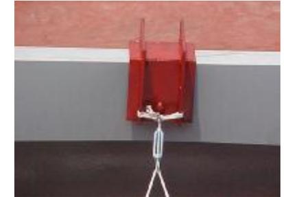
**Imagen 113** anclaje sobre viga prefabricada.<sup>122</sup>
