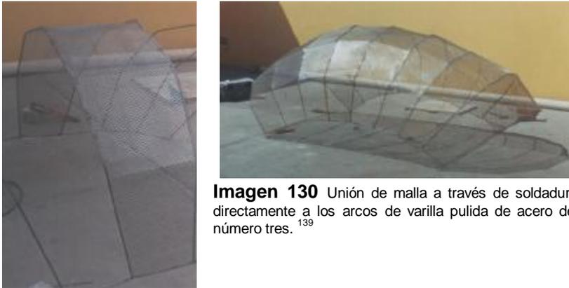
**Imagen 130** Unión de malla a través de soldadura directamente a los arcos de varilla pulida de acero del número tres.<sup>139</sup>
