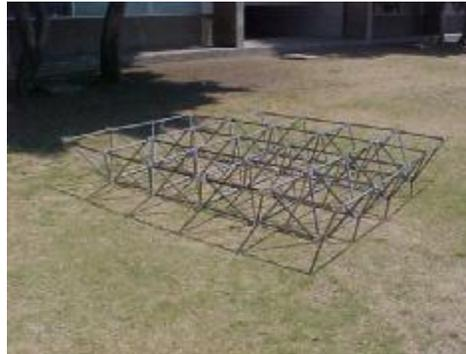
**Imagen 37** Estructura Espacial de base cuadrada con perfiles de acero.<sup>46</sup>
