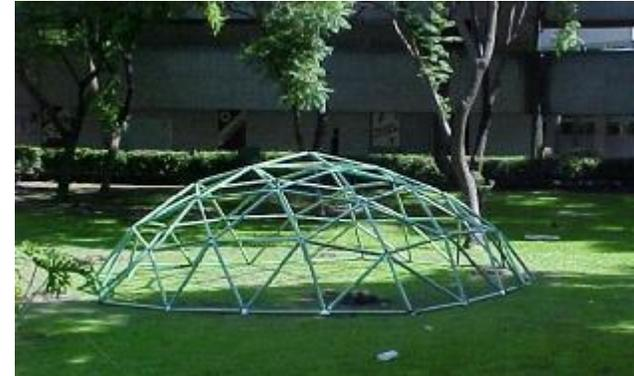
**Imagen 143** Maqueta fabricada con tubos de PVC y nodos de lámina de acero. <sup>152</sup>
