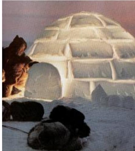
**Imagen 3** Vivienda esquimal hecha con bloques de hielo de 1 mx0.20 mx0.50 m.<sup>12</sup>
