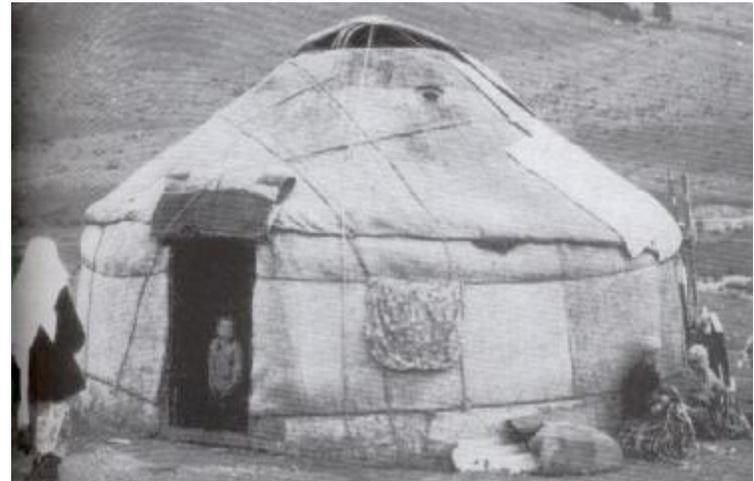
**Imagen 9** Yurta. Se encuentran en Rusia, Mongolia y Afganista. Son de planta circular con estructura retráctil de madera para poder transportarse.<sup>18</sup>
