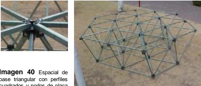
**Imagen 40** Espacial de base triangular con perfiles cuadrados y nodos de placa de acero.<sup>49</sup>
