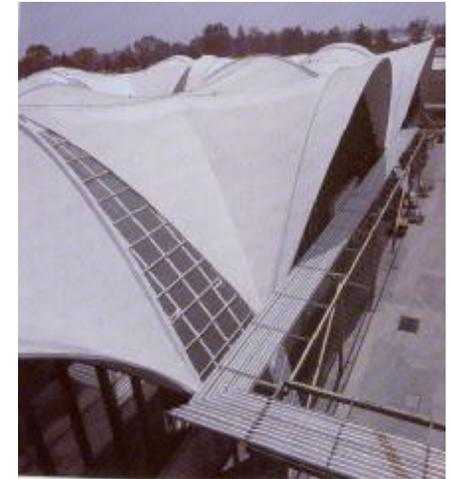
**Imagen 19** Embotelladora de Bacardí. Se observa intersecciones de bóvedas de arista de planta cuadrada.<sup>28</sup>
