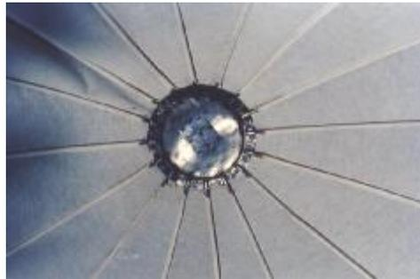
**Imagen 53** Detalle de anillo de compresión metálico. <sup>62</sup>
