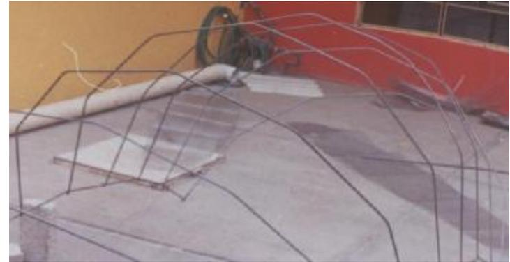
Se imprimieron las plantillas que se obtuvieron por computadora y se cortó la malla, al ser un material reforzado no fue posible cortar con tijeras, así que con ayuda de amoladora angular y disco para metal se cortaron los gajos.
