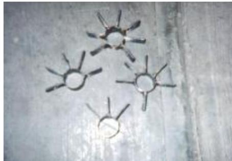
**Imagen 38** Diferentes tipos de nodos que se utilizaron dependiendo la posición y la cantidad de barras.<sup>47</sup>
