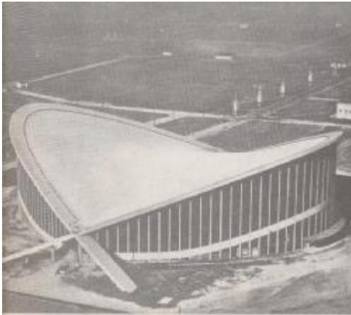
**Imagen 17** Arena de Raleigh 1953. Dos arcos parabólicos inclinados intersectados que reciben un sistema de red de cables para la cubierta.<sup>26</sup>
