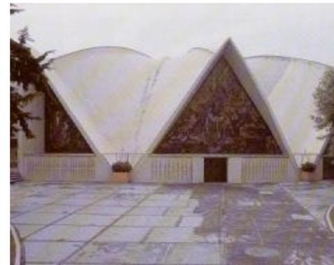
**Imagen 20** Iglesia de Santa Mónica. Una sección de paraboloides hiperbólicos repetidos 10 veces forma la cubierta de la Iglesia.<sup>29</sup>
