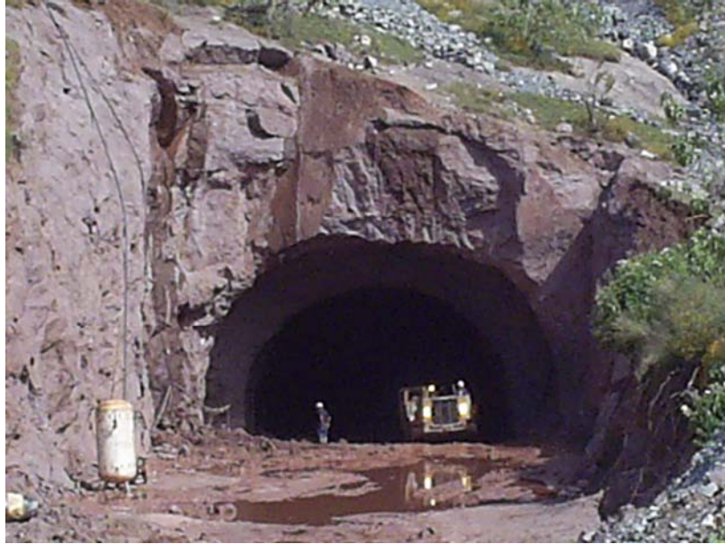
Figura 5.5 Túnel sin elementos de soporte, con un diámetro de 8.0 m, excavado en conglomerados.
