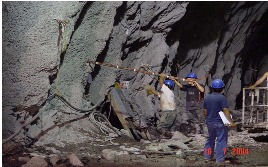
Figura 9.1 Colocación de anclas en las paredes de un túnel.
