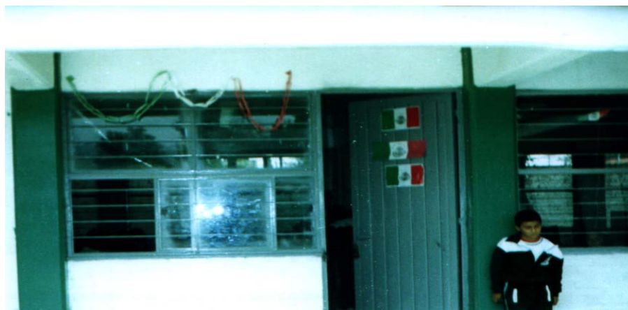
Fotografía 8. Estos salones fueron entregados en el año de 1993. En sus inicios iban alumnos de primero, segundo y tercer grado; hoy son salones para los segundos grados, tienen instalaciones eléctricas y están aplanados, no se filtra el agua y tienen ventanas que permiten la ventilación e iluminación.
