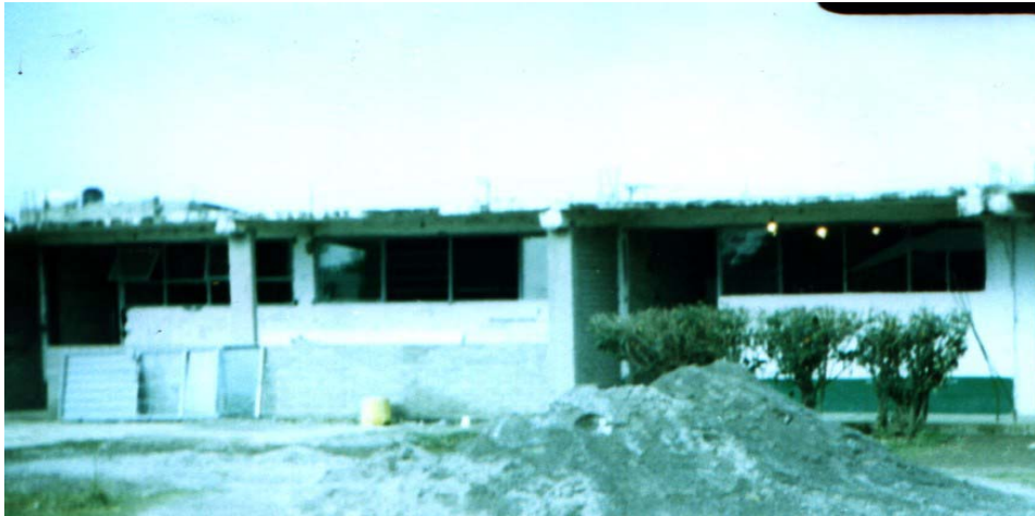
Fotografía 15. Orientación de tercer grado, antes era la antigua dirección pero al paso de los años se convierte en orientación de tercer grado.
