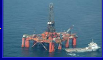
Perforación exploratoria (4 - 8 meses)
