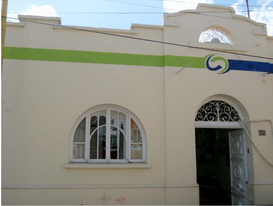
3. Jurisdicción Sanitaria No.4 en Acámbaro Guanajuato.
