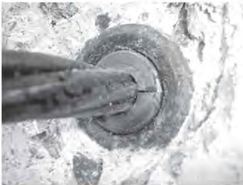
Fig.3.8.12 Cable tensado
