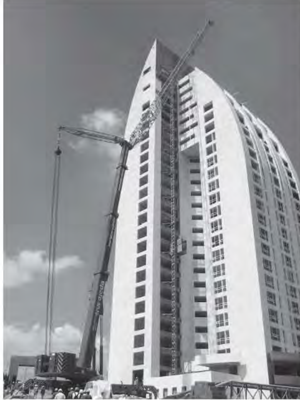
5.5.2 Desmontaje de grúa torre
