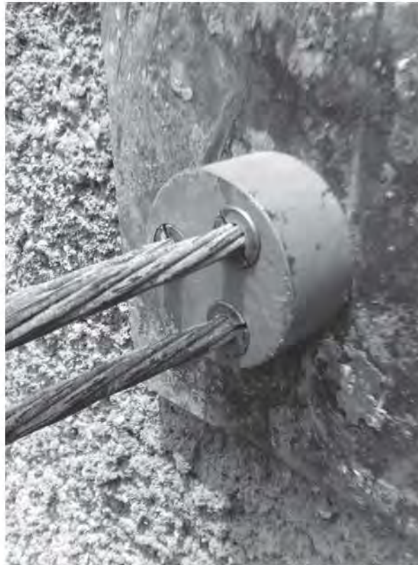
Fig. 5.1.32 Cuñas incrustadas en el apoyo después de aplicar tensión
