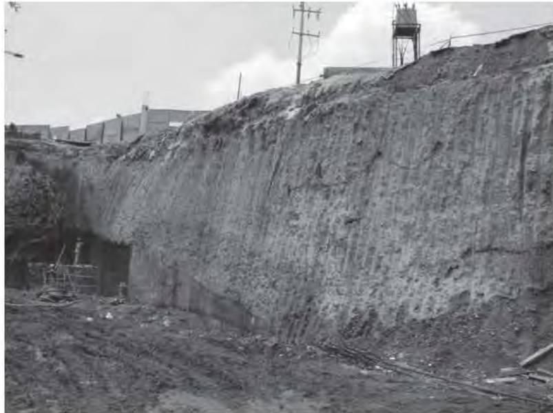
Fig. 5.1.12 Concreto lanzado en primera etapa para estabilizar talud del lado en el que se suministraban los agregados para la planta de concreto
