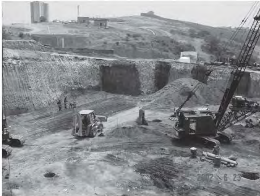
Fig. 5.1.2 Taludes que se estabilizaron con concreto lanzado
