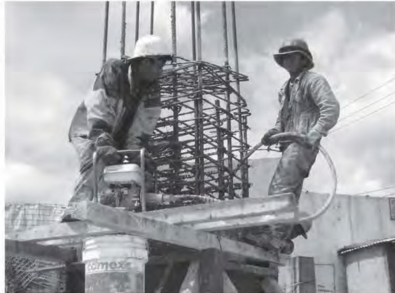
Fig. 3.4.3 Acomodo del concreto empleando vibrador con motor a gasolina
