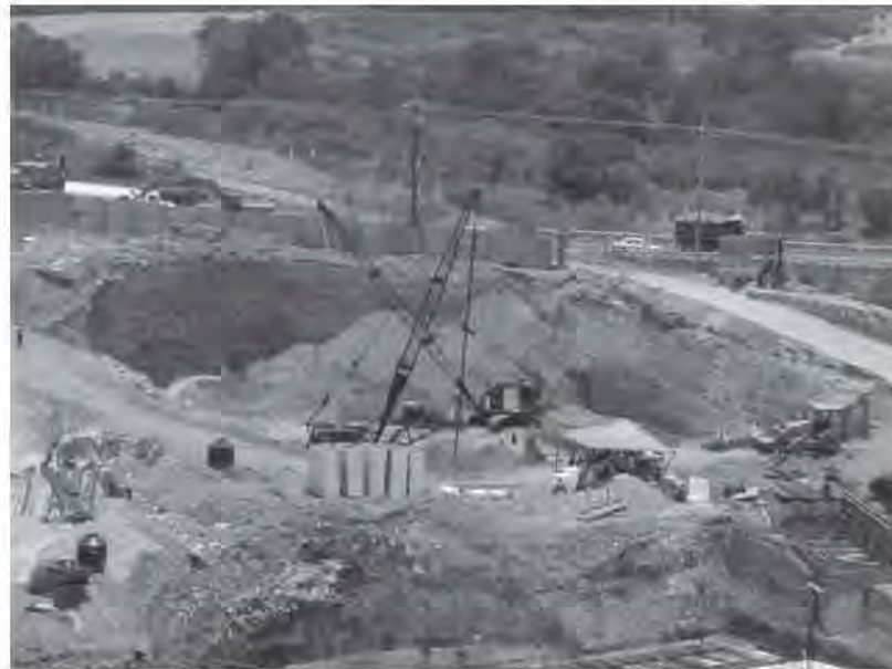
Fig. 5.2.1 Perforación de pilas al centro de la excavación
