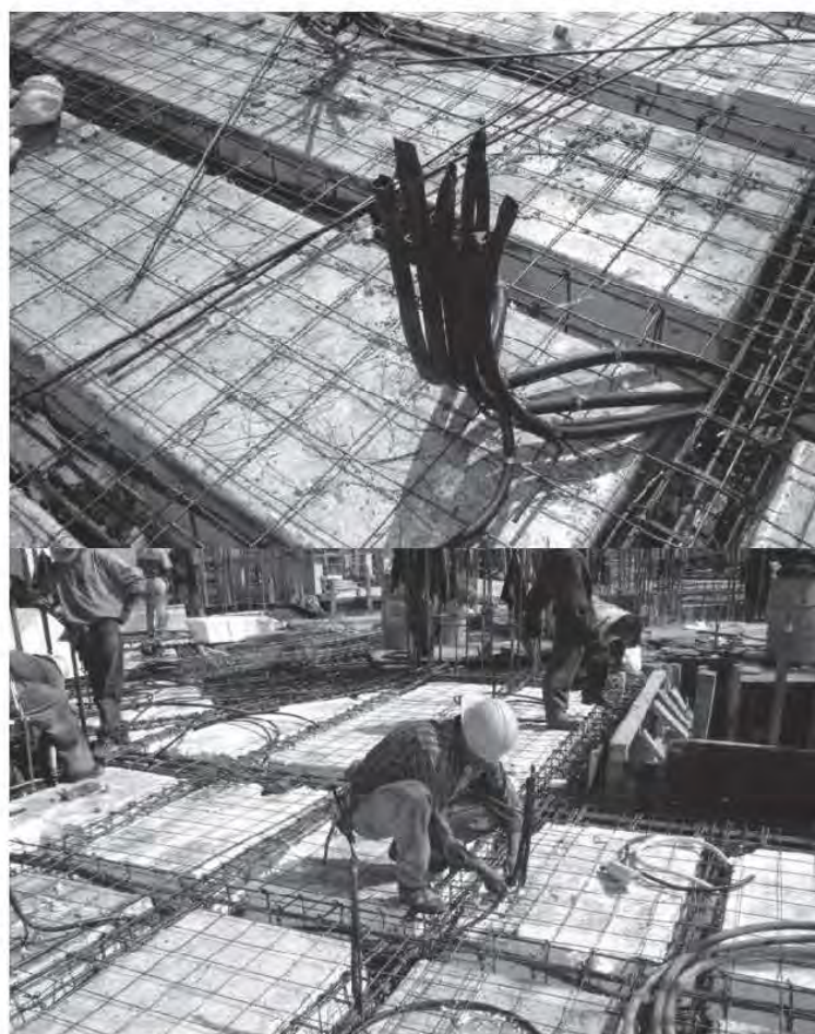
Fig. 3.6.13 Colocación de instalaciones eléctricas
