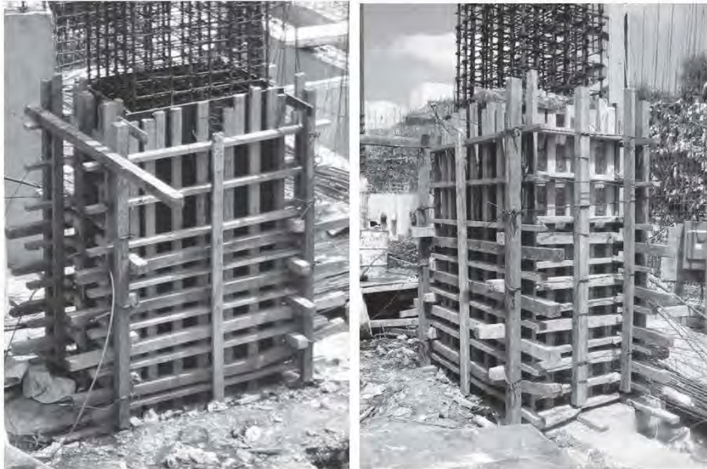
Figs. 3.3.4 y 3.3.5 Columnas de estacionamientos cimbradas con triplay, barrote y polines
