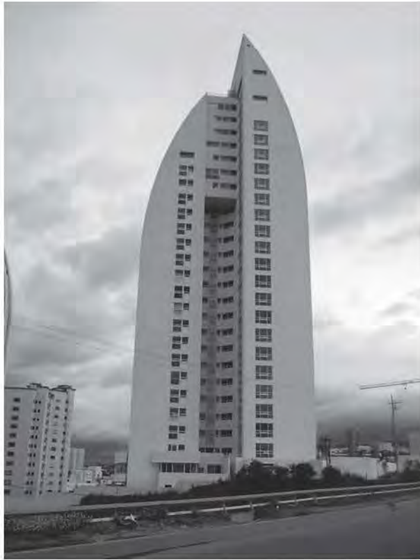
Fig. 5.5.11 Vista terminada de la fachada norte
