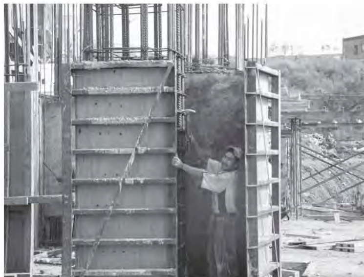
Fig. 3.3.14 Colocación de tapas en columna
