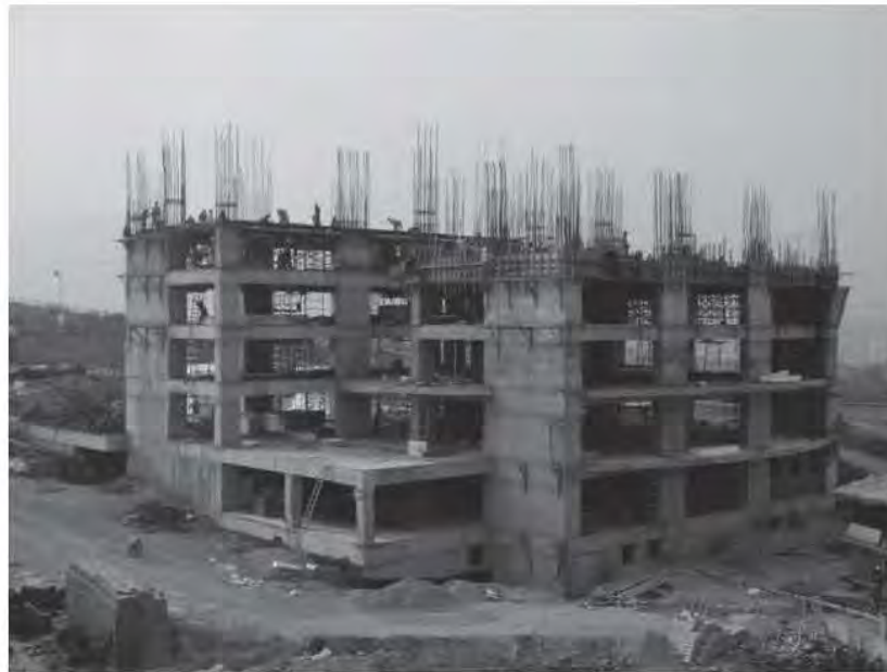
Fig. 5.3.10 Cierre del colado de la losa 3 y comienzo del armado de la losa 4
