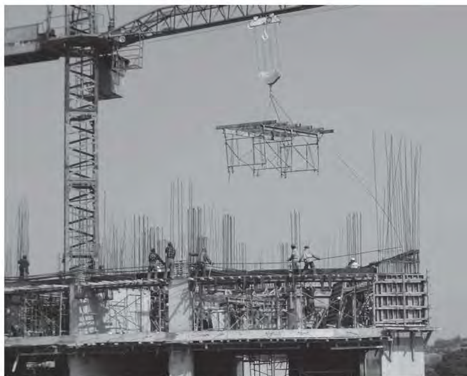
Fig. 3.5.25 y 3.5.26 Elevación de mesas con la grúa
