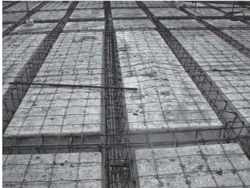
Fig. 3.6.5 Malla colocada lista para colado
