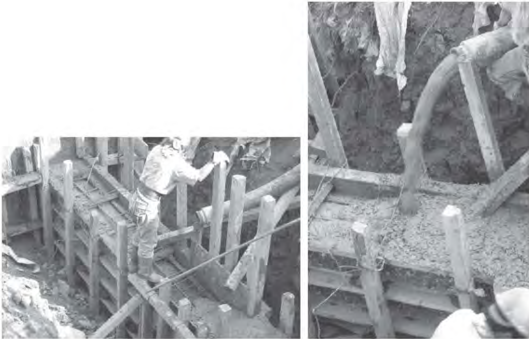
Fig. 2.8.3 y 2.8.4 Salida del concreto en la tubería
