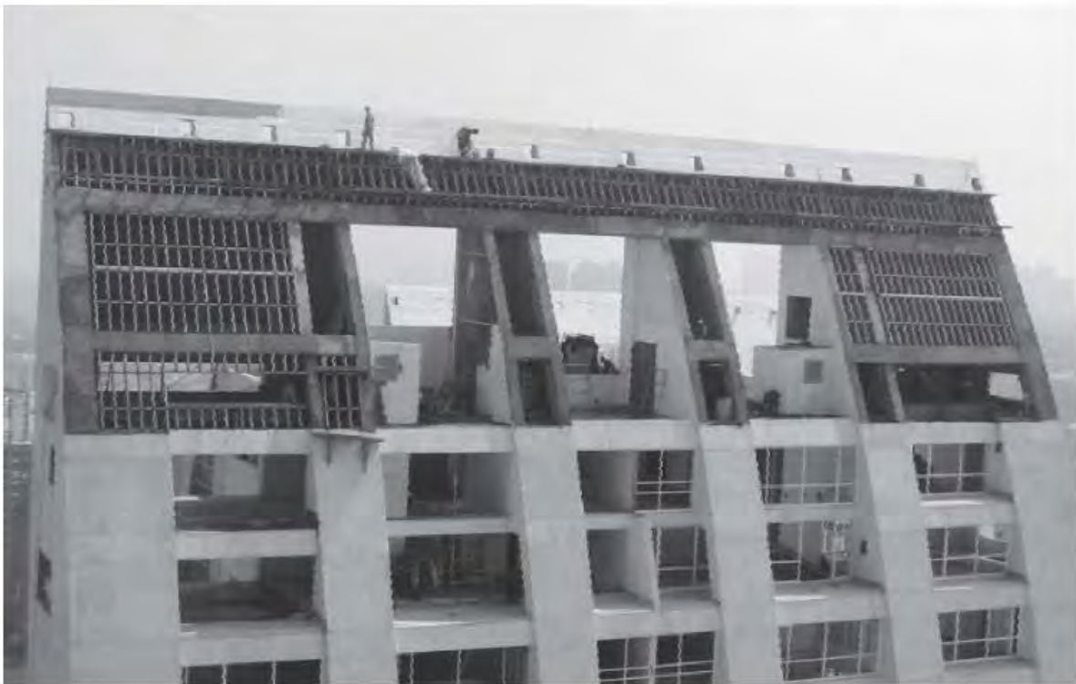
Fig. 4.3.23 Colocación y calefateado de permabase
