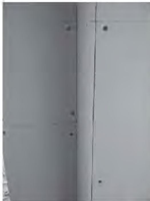
Fig. 4.2.2.20 Fijación de paneles con tornillos a cada 30.5 cm.
