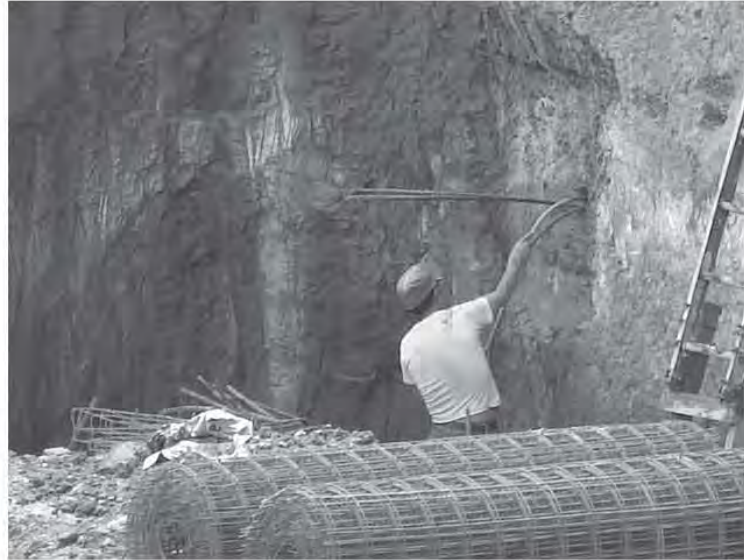
Fig. 5.1.18 Inyección de grout en los barrenos
