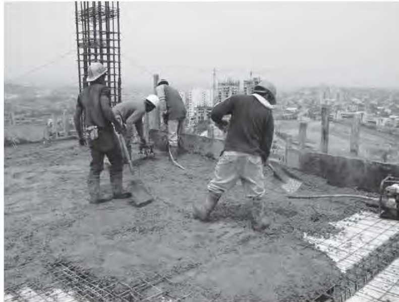
Fig. 3.7.6 Movimiento del concreto cerca de donde quedará colocado
