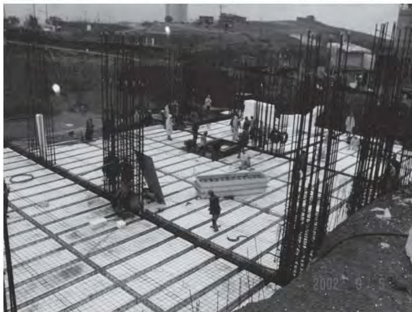
Fig. 3.5.10 Colocación de casetones de fibra de vidrio y malla electrosoldada
