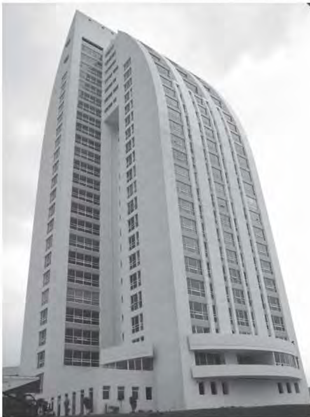
Fig. 5.5.12 Vista de la fachada sur oriente
