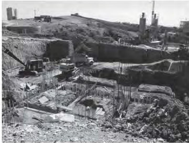
Fig. 5.2.4 Excavación de cisterna
