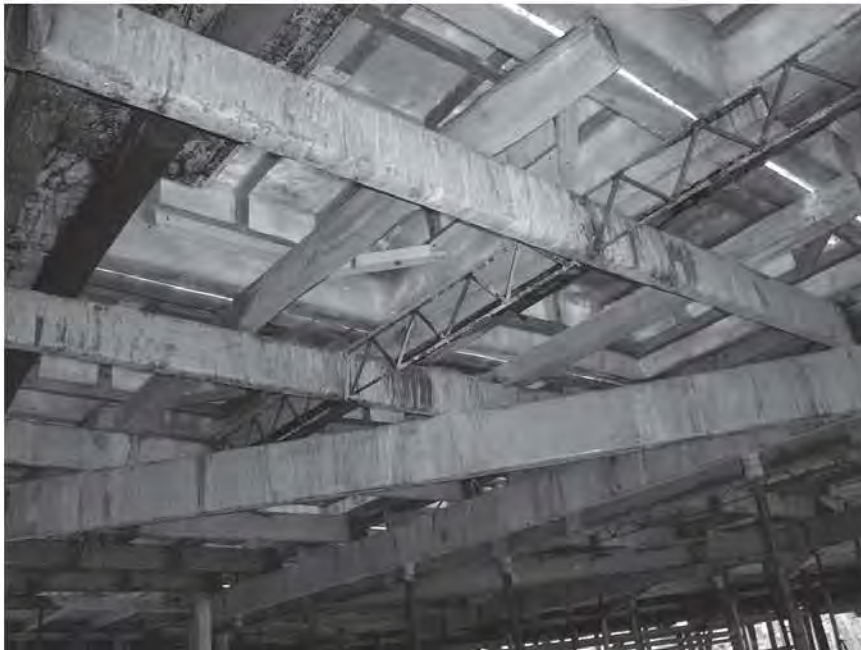
3.5.27 y 3.5.28 Vista inferior de losa cimbrada con mesas metálicas
