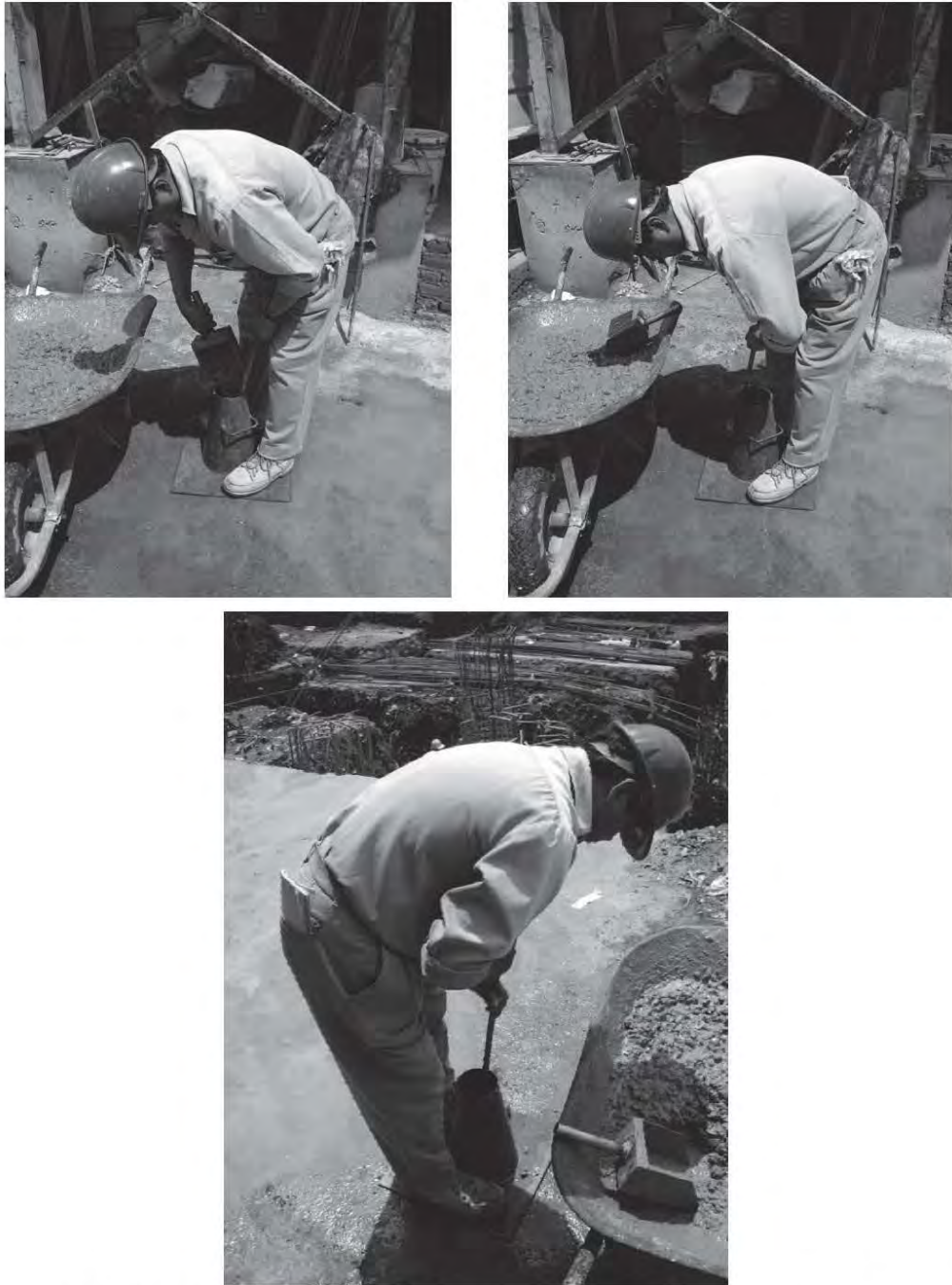
Fig. 2.5.7 a 2.5.8 Llenado de cono de revenimiento y acomodo con varilla de enrase
