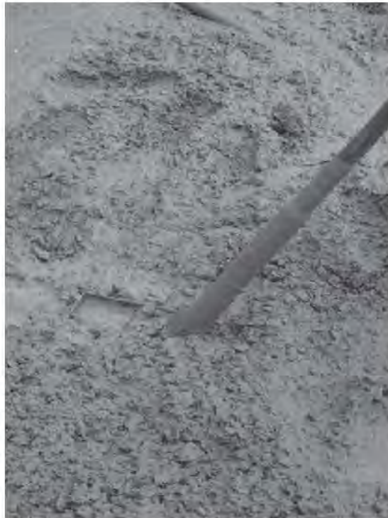
Fig. 3.7.8 Vibrado de capa delgada de concreto
