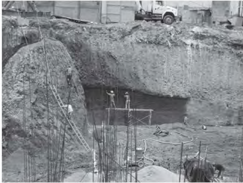
Fig. 5.1.10 Colocación de malla para estabilizar talud
