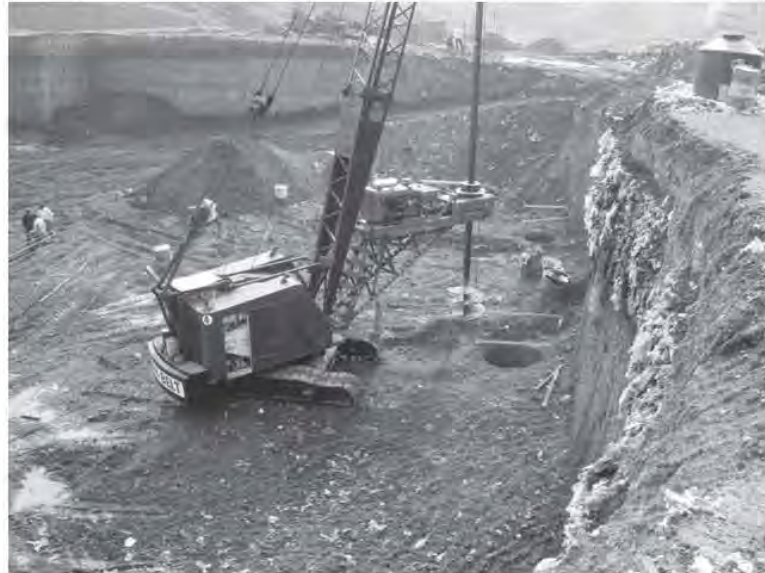
Fig. 2.3.1 Perforadora rotatoria Watson 5000
