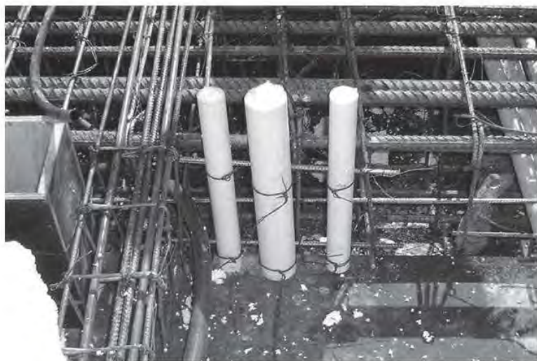
Fig. 3.6.12 Pasos de instalaciones hidrosanitarias
