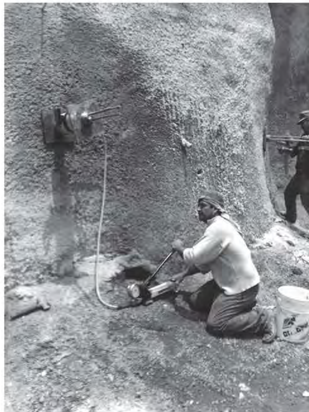
Fig. 5.1.30 Se procede a aplicar la tensión
