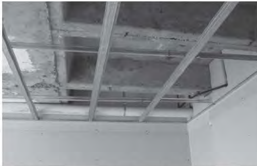
Fig. 4.2.2.14 Bastidor para plafón con canaleta de carga (elemento vertical) parte superior y canal listón (elemento horizontal) parte inferior
