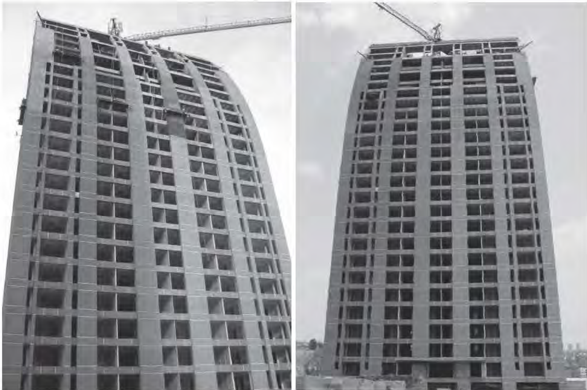
Fig. 5.4.3.4 y 5.4.3.5 En la gráfica de la izquierda se nota que todavía hay hamacas para terminar el aplanado la fachada poniente y en la de la derecha ya esta concluido
