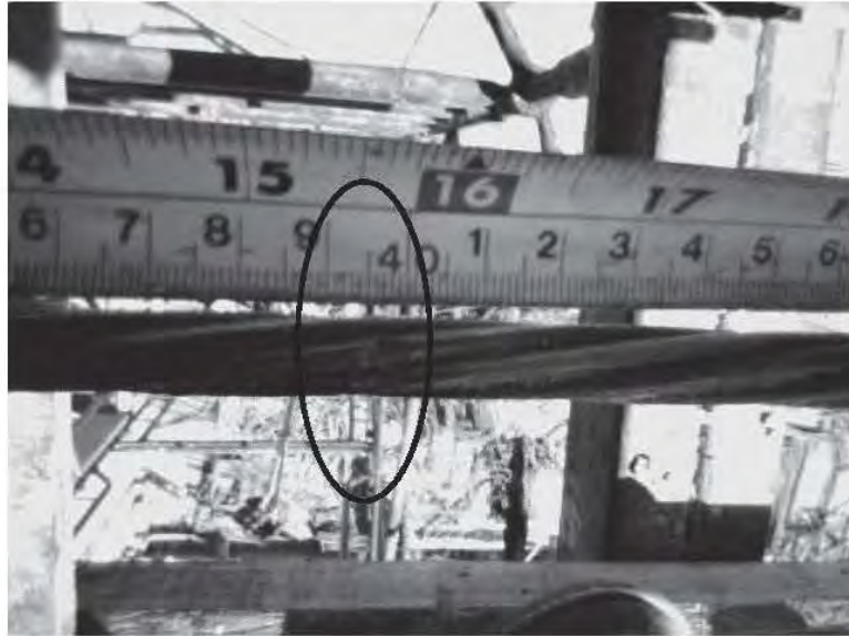
Fig. 3.8.13 Medición de una distancia al paño del concreto, en este caso 40 cm.
