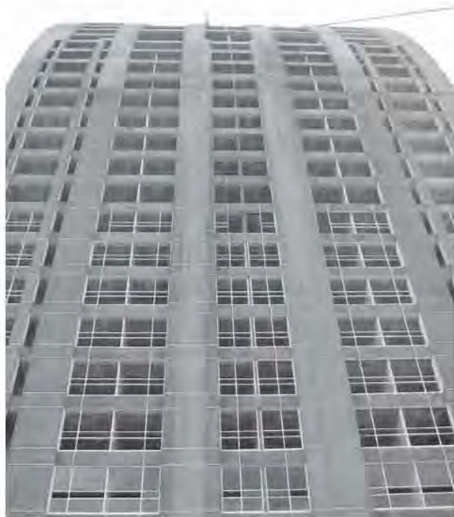
Fig. 5.5.8 Colocación de aluminio y vidrio en fachadas
