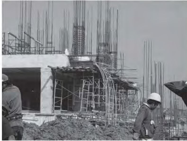
Fig. 5.3.7 Colados de losas hasta el eje C
