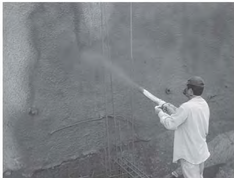
Fig. 5.1.22 Lanzado de concreto
