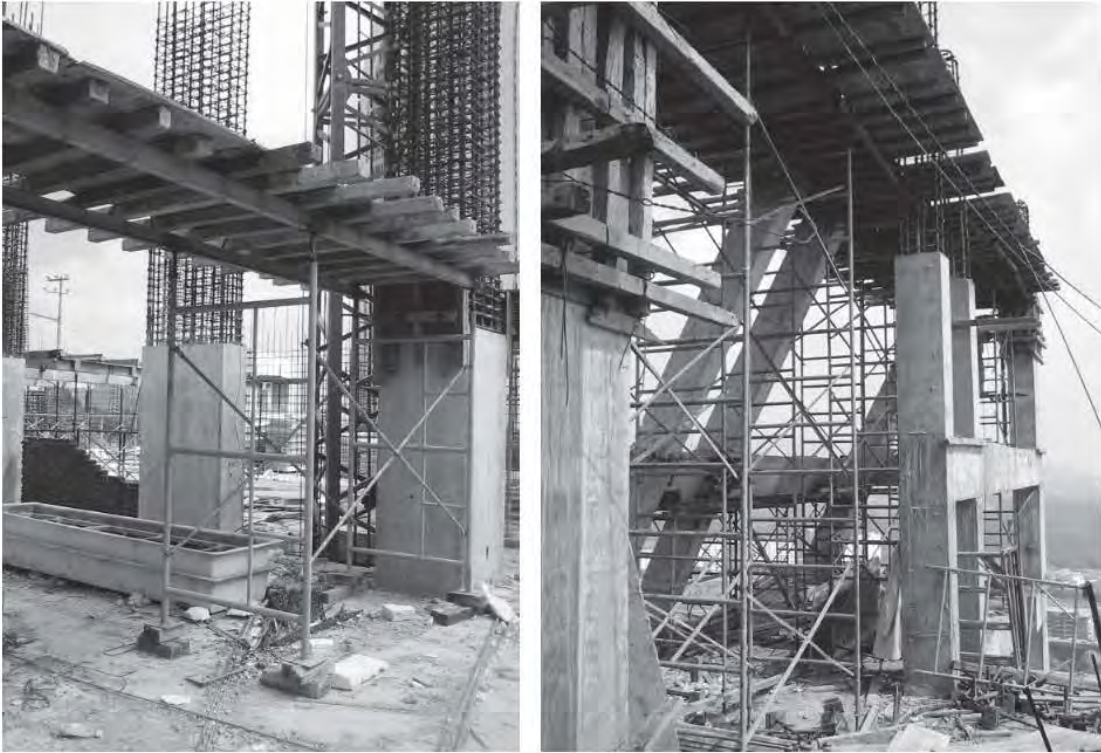
Fig. 3.3.16, 3.3.17 Fondos para traves cimbradas con marcos de alta resistencia
