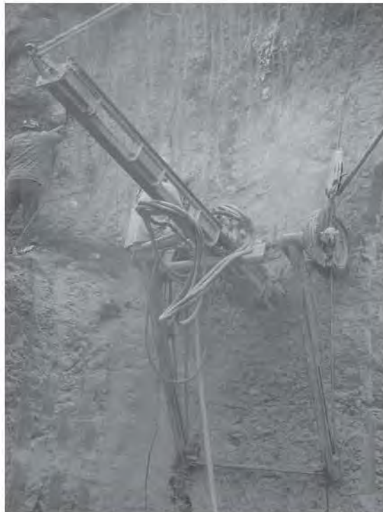
Fig. 5.1.15 Perforación de barrenos para alojar torones
