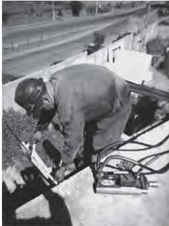
Fig. 3.8.11 Medición de la elongación
