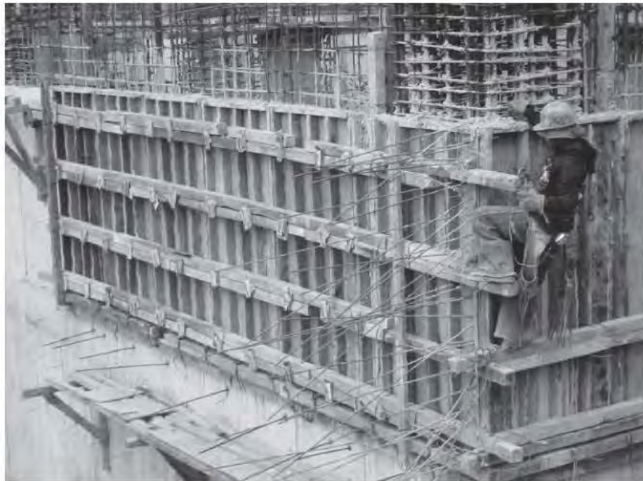
Fig. 3.3.18 Descimbrado de muros
