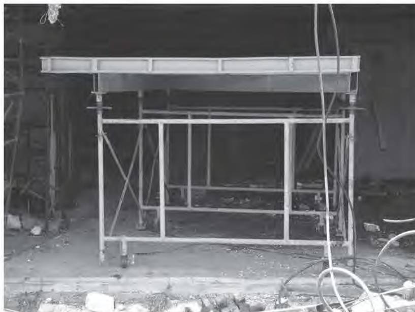
Fig. 3.5.18 y 3.5.19 Mesas de colado y tapas de cimbra de columnas
