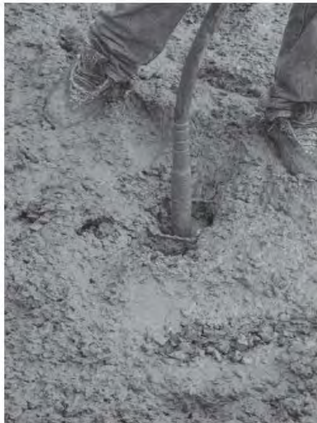
Fig. 3.7.7 Introducción vertical del vibrador
