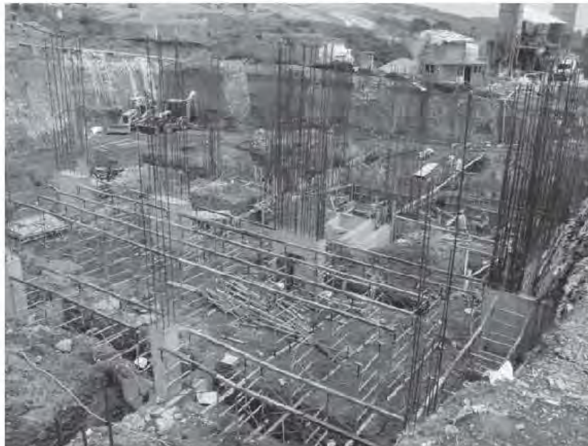
Fig. 5.3.2 Apuntalamiento de losa 89.5 de eje B al c de 3 al 6
