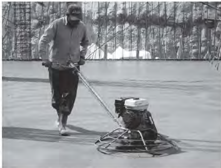
Fig. 3.7.12 Emparejado del concreto
