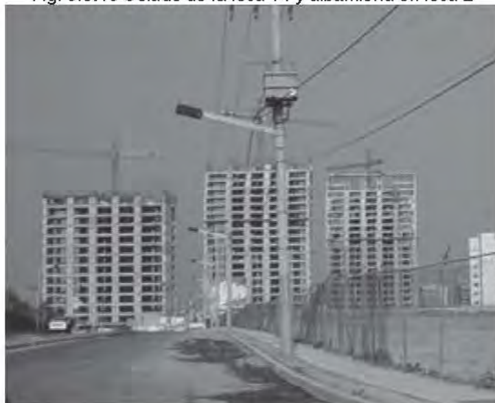
Fig. 5.3.16 Vista de la construcción de la estructura de las torres B C y D de izquierda a derecha
