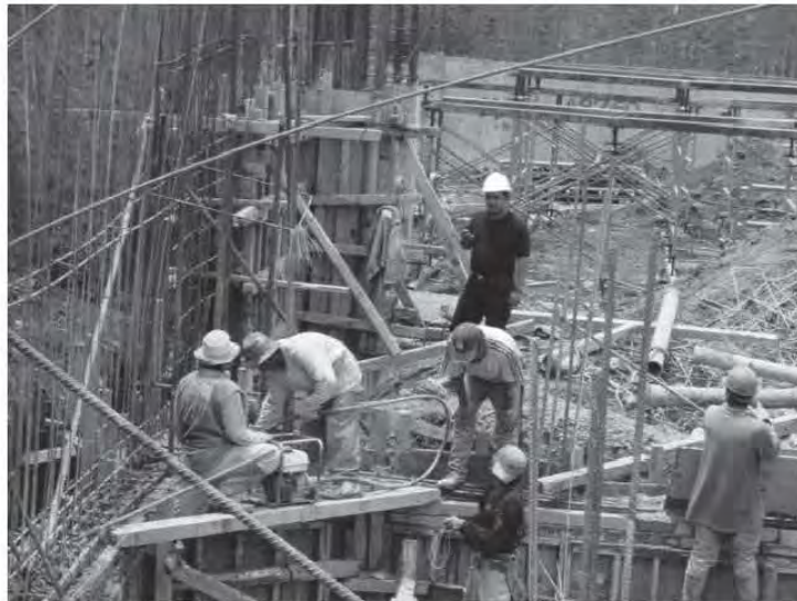
Fig. 2.8.5 y 2.8.6 Acomodo del concreto en los nodos
