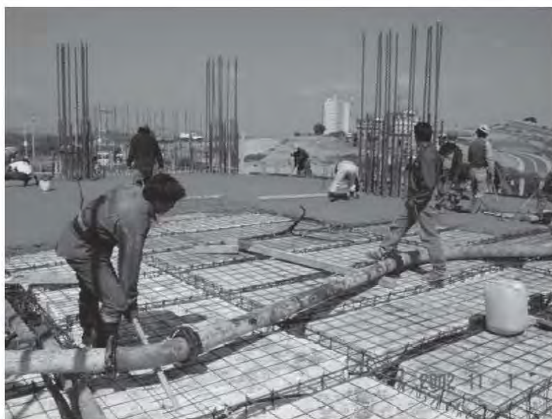
Fig. 3.7.1 Movimientos de tubería durante el colado
