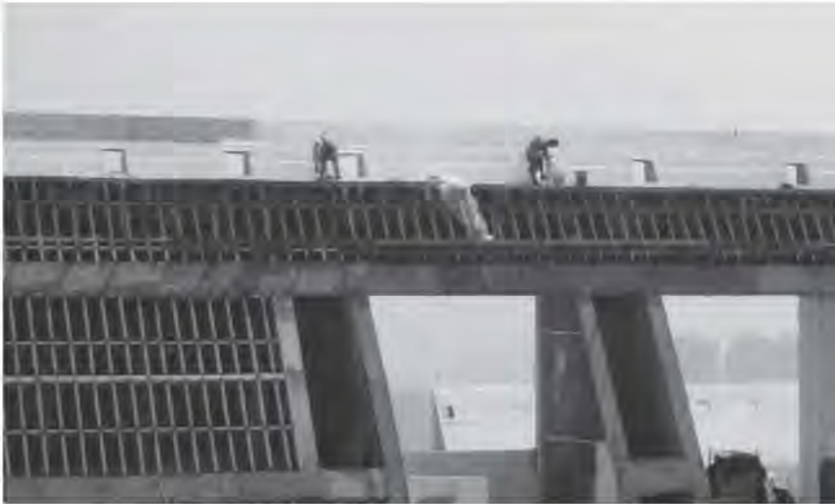
Fig. 4.3.24 Aplicación de basecoat en los paneles de cemento
