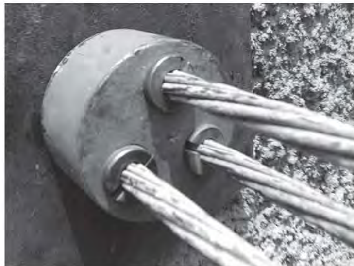
Fig. 5.1.28 Cuñas para anclaje colocadas
