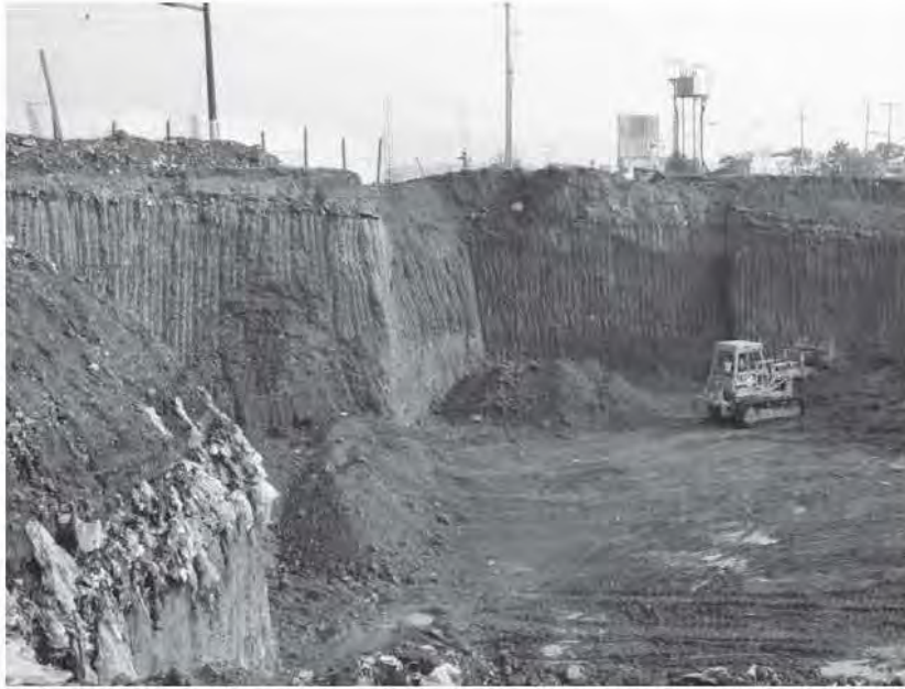
Fig. 2.2.2 Vista de taludes y afinado de fondo
