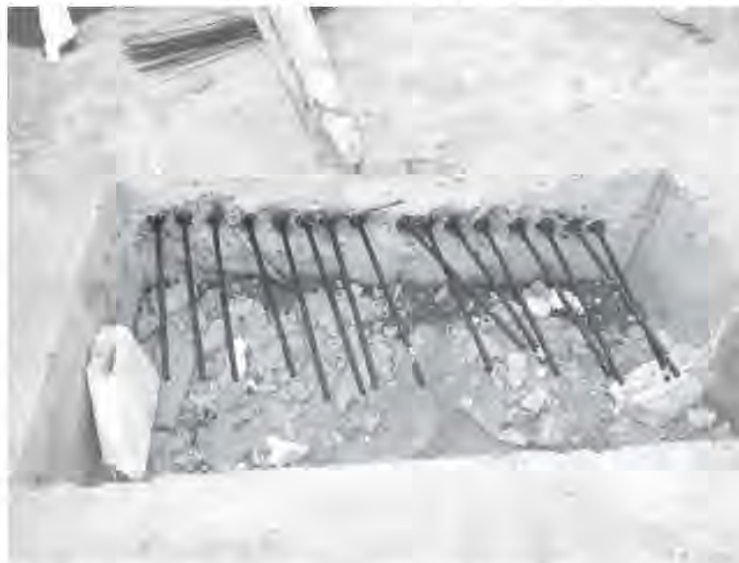
Fig. 3.8.1 Caja de tensado con una cantidad considerable de cables
