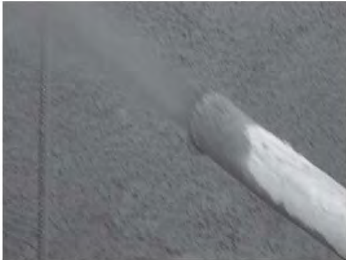
Fig. 5.1.23 Lanzado de concreto
