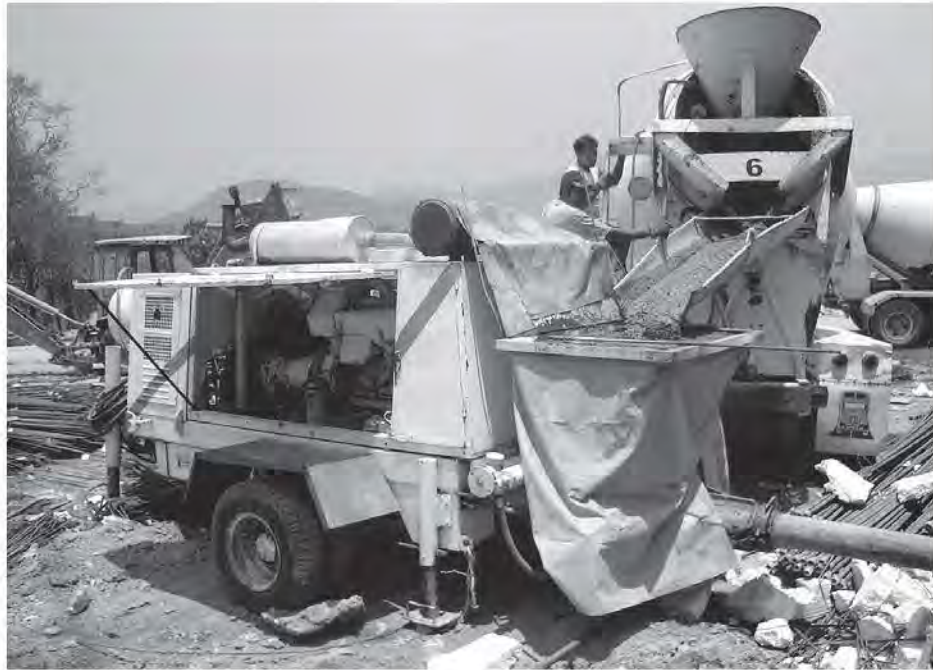
Fig. 2.8.1 Empleo de concreto premezclado y bomba en el colado de pilas
