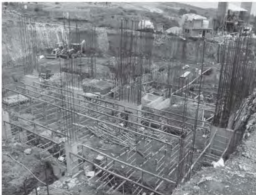
Fig. 3.5.7 Colocación de torres en estacionamientos
