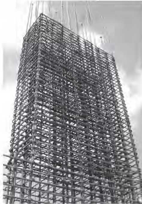
Fig. 3.2.8 Columna revestida
