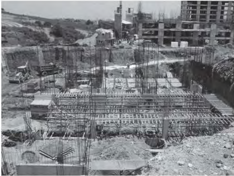
Fig. 5.3.3 Cimbrado de traves de la losa de estacionamiento ejes B y C
