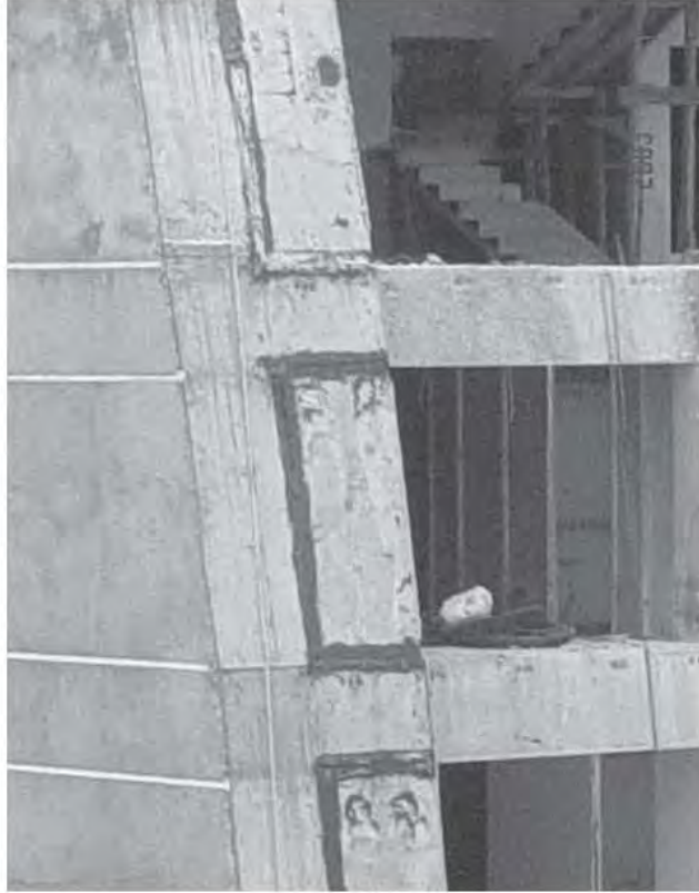
Fig. 4.3.7 Tratamiento de juntas de los elementos de concreto prefabricado
