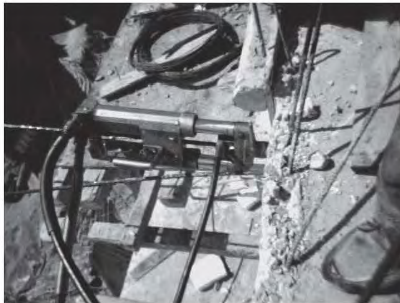
Fig. 3.8.16 Secuencia de tensado
