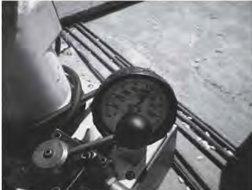
Fig. 3.8.10 Aplicación de tensión deseada (5500 psi en este caso)
