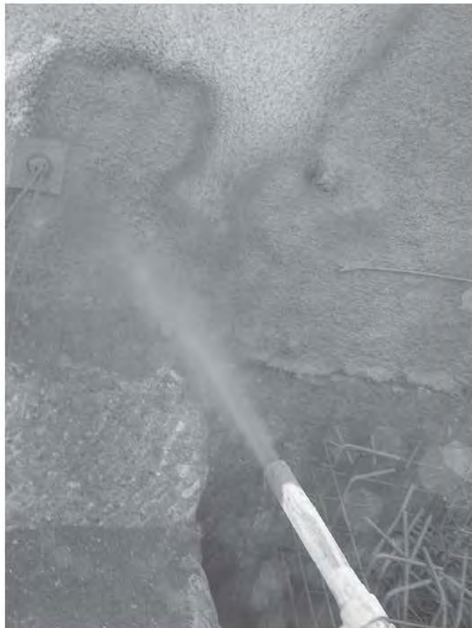
Fig. 5.1.24 Lanzado de concreto
