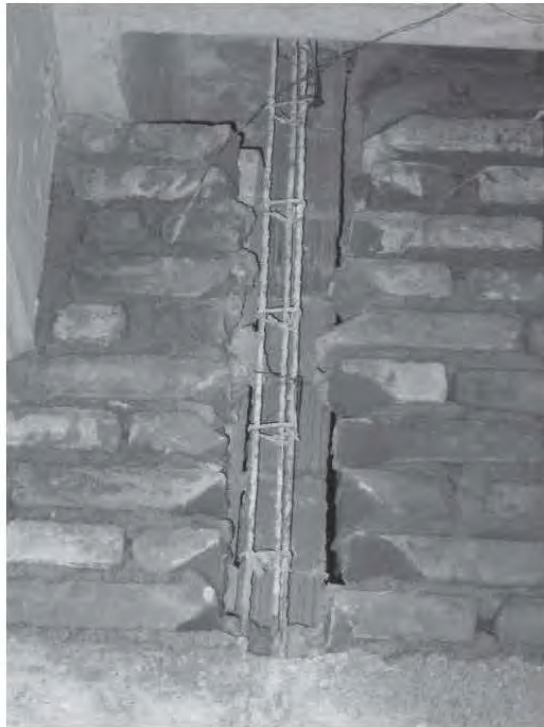
Fig. 4.1.3 Armadura en intersección de muros para castillo
