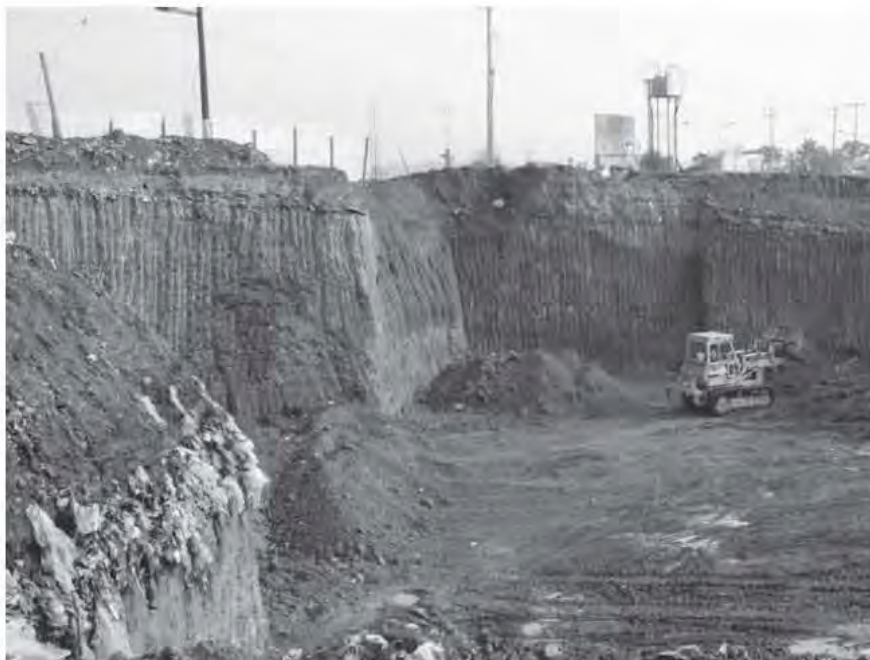
Fig. 5.1.3 Zona de riesgo
