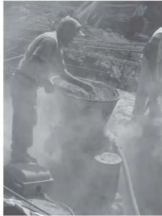
Fig. 5.1.20 y 5.1.21 Vaciado de cemento y agregados en la tolva
