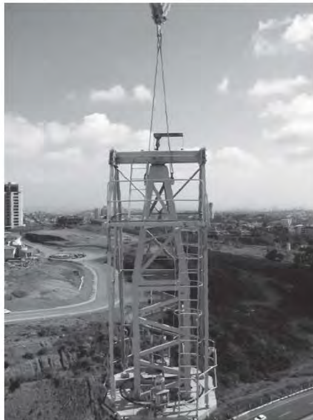
Fig. 5.5.5 Desmontaje de corona
