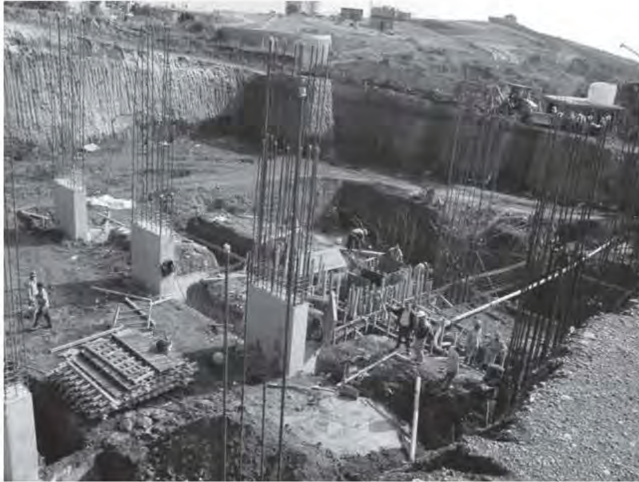
Fig. 5.3.1 Inicio de superestructura. Columnas del eje c entre 3 y 6 de la cimentación al nivel 89.50
