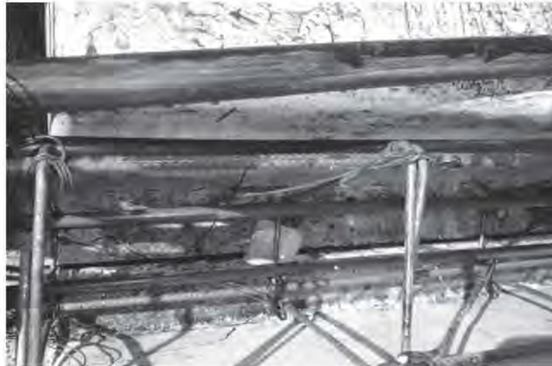
Fig. 3.6.11 Calzado de nervaduras
