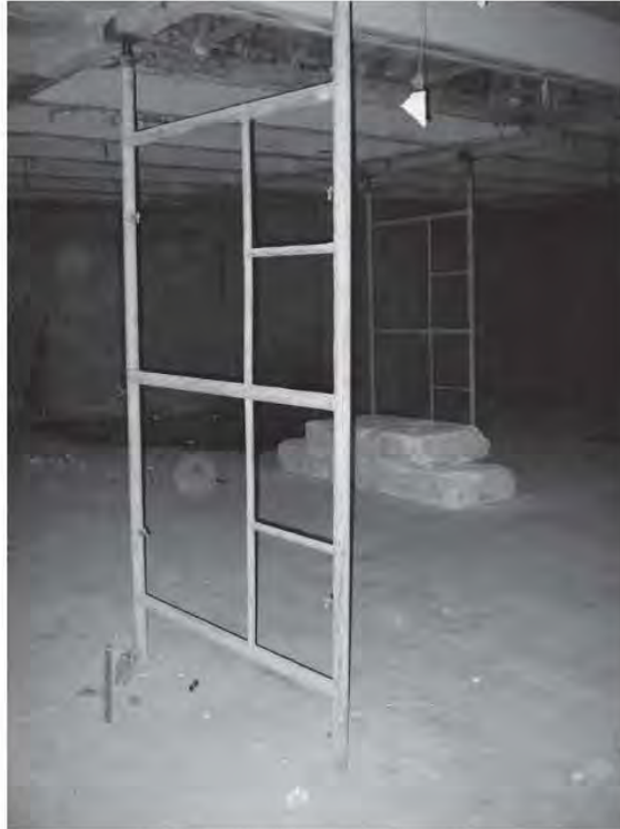
Fig. 3.6.10 Apuntalamiento que se deja en el nivel inferior al que se esta trabajando
