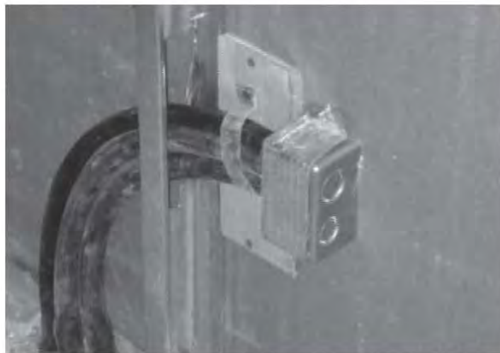
Figs. 4.2.2.6 y 4.2.2.7 Colocación y fijación de chalupas
