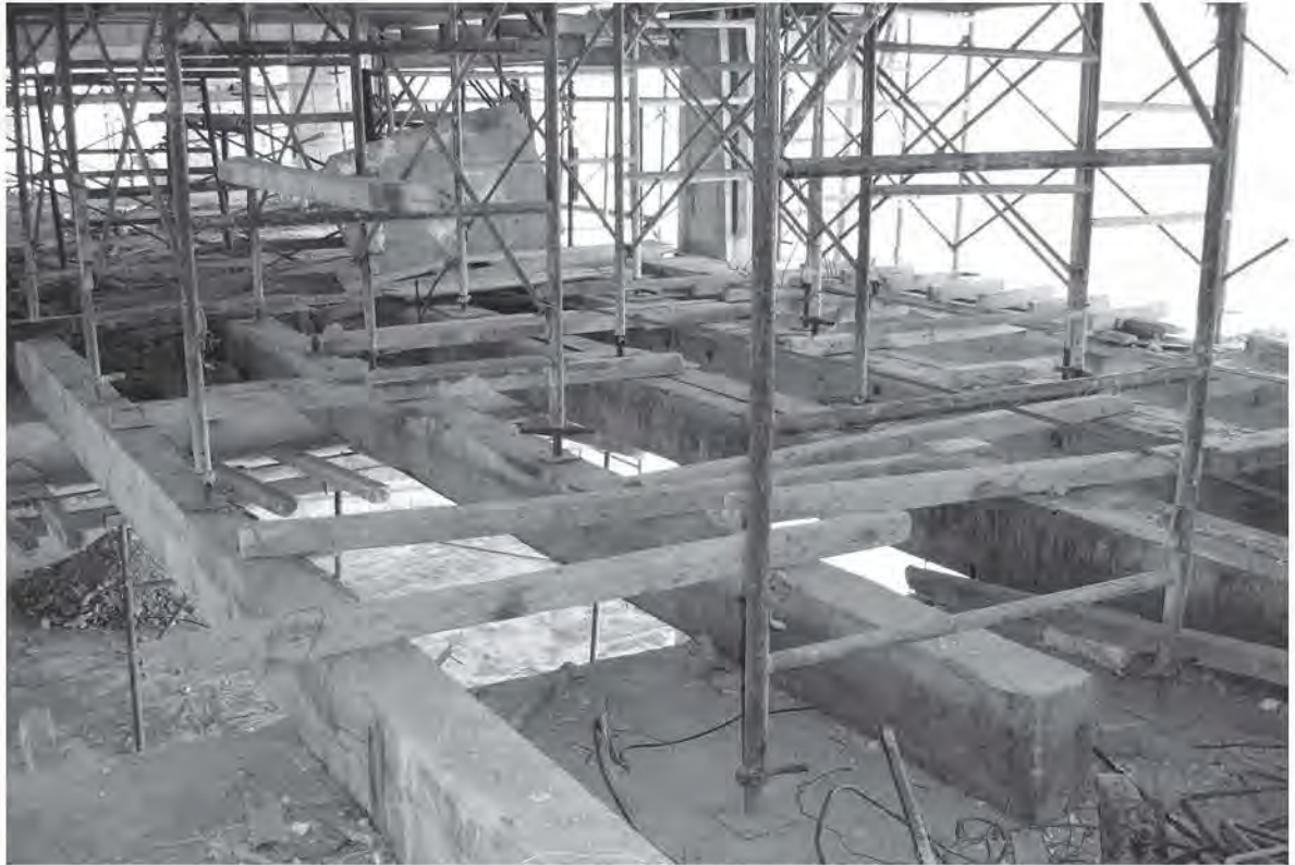
Fig.3.5.33 Cimbrado de volado en nivel 149.10
