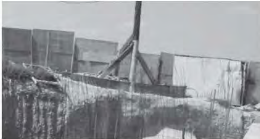
Fig. 5.1.5 Poste arriostrado con vigas IPR
