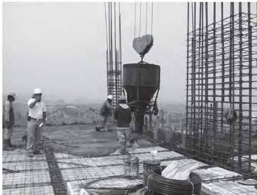
Fig. 3.7.5 Vaciado del concreto en la losa
