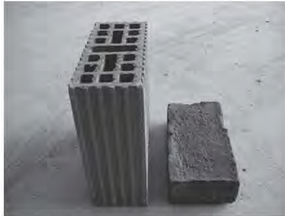
Fig. 4.2.1.1 comparativa de dimensiones entre tabimax y tabique rojo recocido
