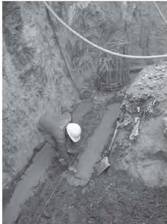
Fig. 2.6.4 Preparación de maestras de nivelación para la el colado de la plantilla
