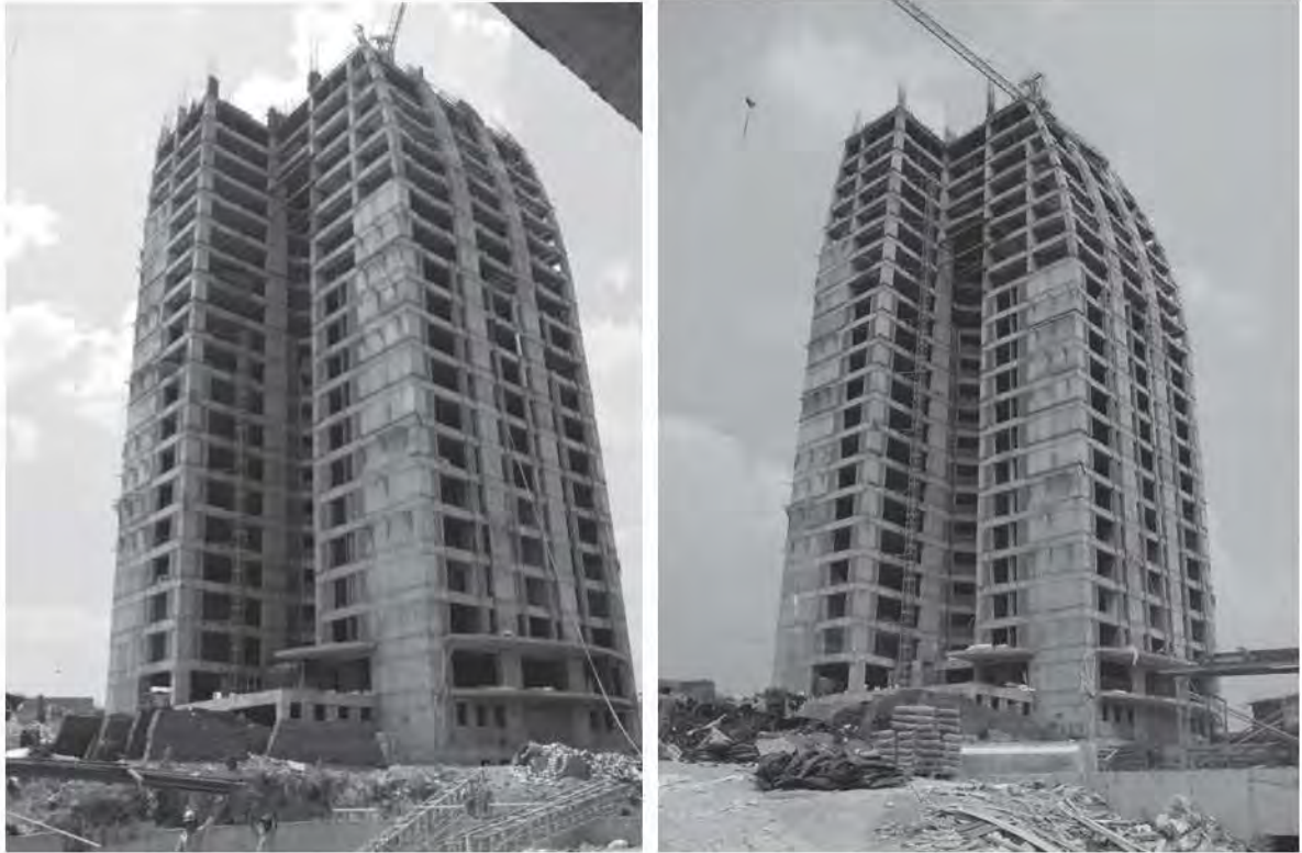
Fig. 5.4.3.1 y 5.4.3.2 Es estas gráficas se aprecia que aun no se ha iniciado el aplanado en la fachada
