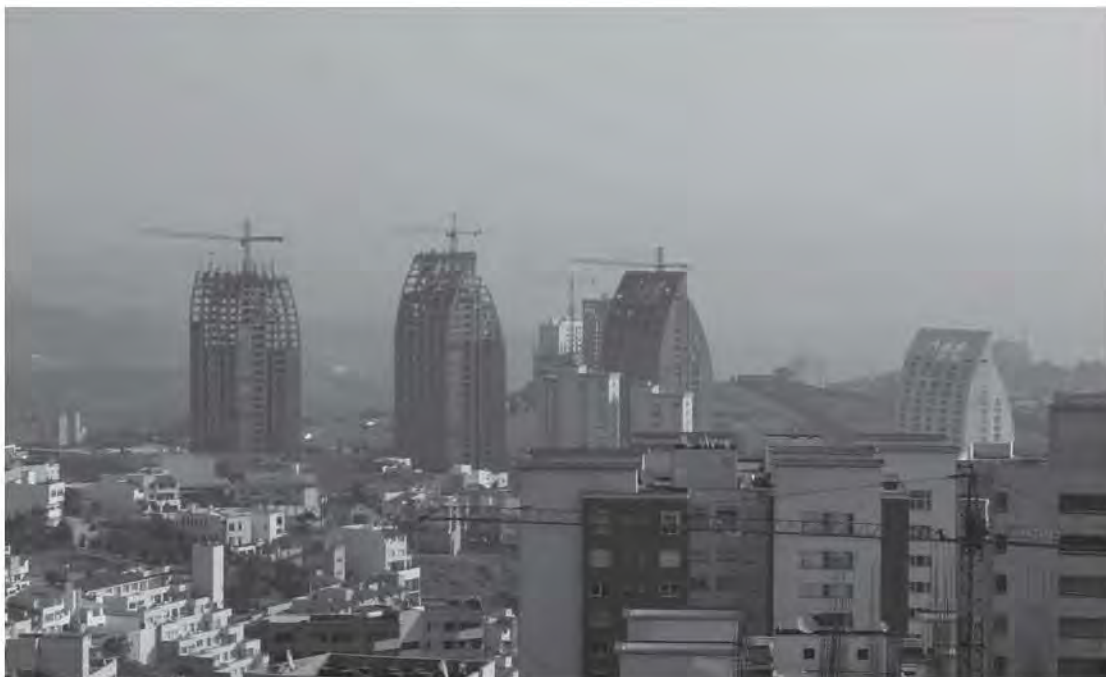
Fig. 5.5.10 Vista del conjunto hacia el norte. De izquierda a derecha las Torres A B C y D de residencial Toledo
