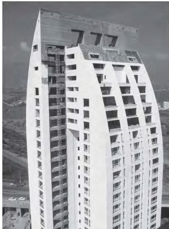
Fig. 5.5.7 Vista de la torre sin grúa y con el elevador de obra en operación
