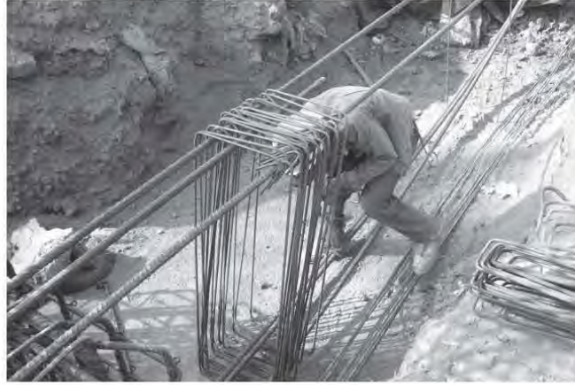
Fig.2.6.7 Colocación de estribos
