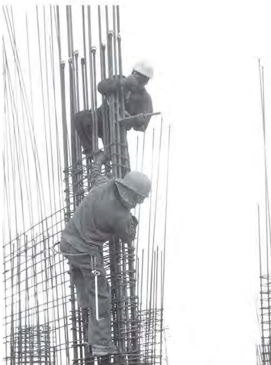
Fig. 3.2.6 Aplicación de torque en los conectores
