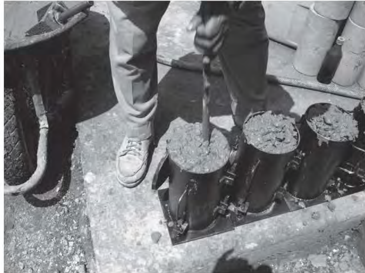
Fig. 2.5.14 a 2.5.17 Llenado y acomode de concreto en los moldes
