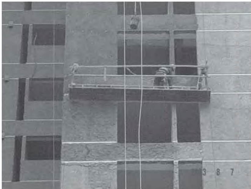
Fig. 4.4.7 Aplicación de aplanado Base
