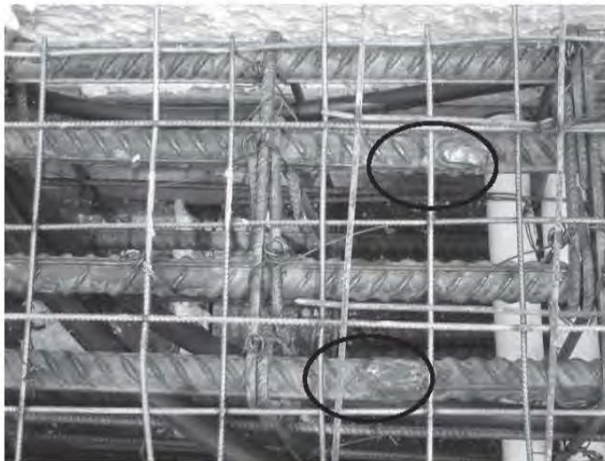
Fig. 3.2.2 Vista de uniones con soldadura en trabes
