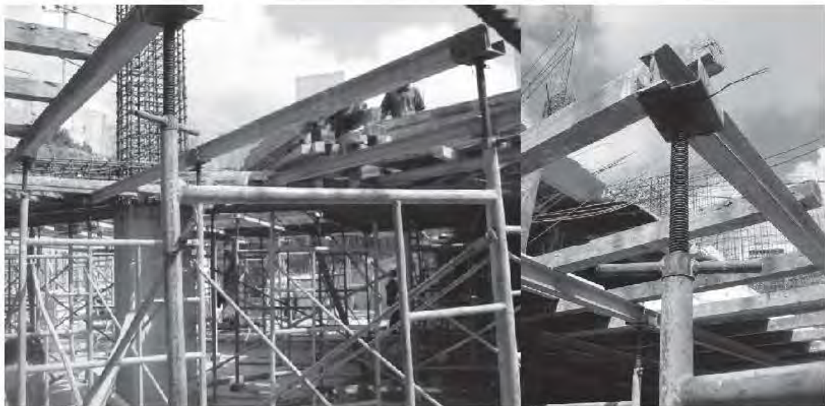
Fig.3.5.12 y 3.5.13 Empleo de marcos y vigas para cimbrar las losas
