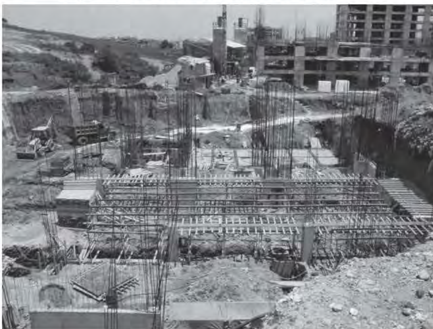
Fig. 3.5.8 Colocación de fondos en traves
