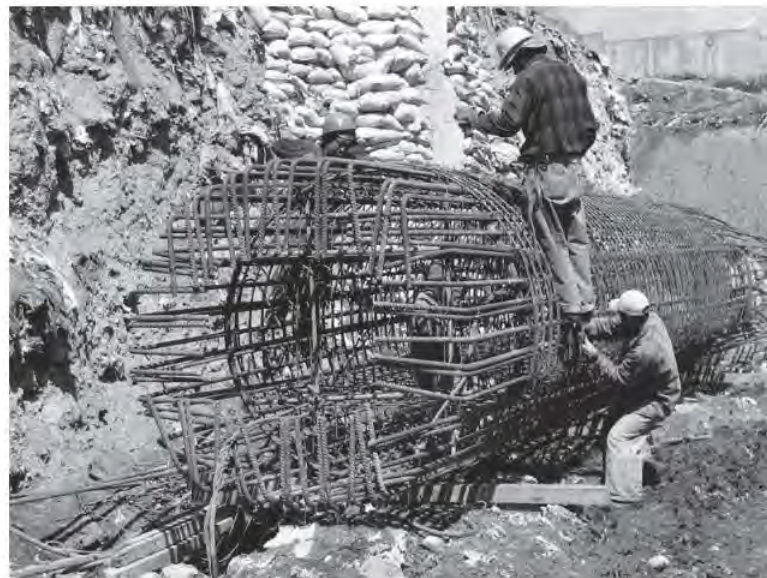
Fig. 2.4.1 y 2.4.2 Armado de pilas
