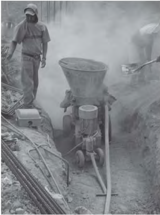
Fig. 5.1.20 y 5.1.21 Vaciado de cemento y agregados en la tolva
