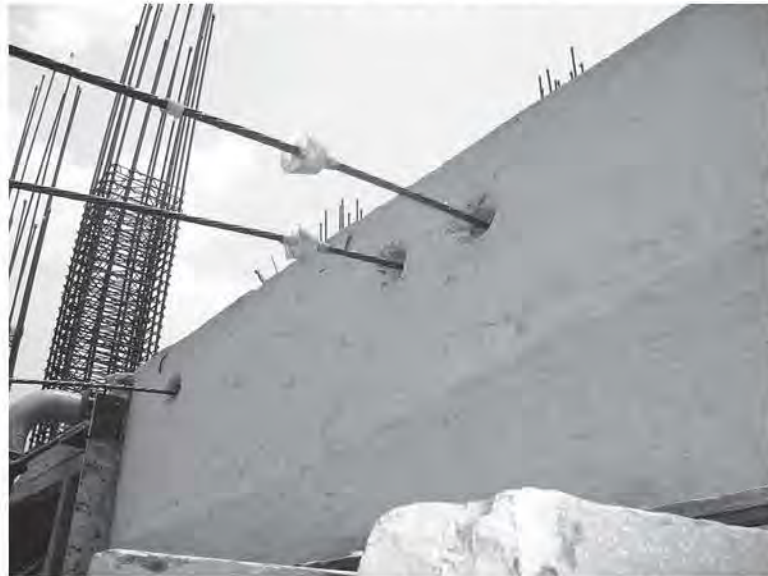
Fig. 3.8.3 Retiro de los pocket formers
