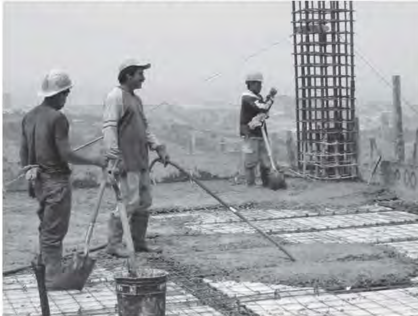
Fig. 3.7.8 Vibrado de capa delgada de concreto
