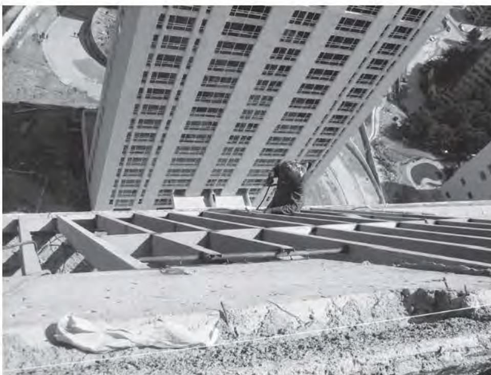
Fig. 4.3.16 y 17 Elaboración de bastidor
