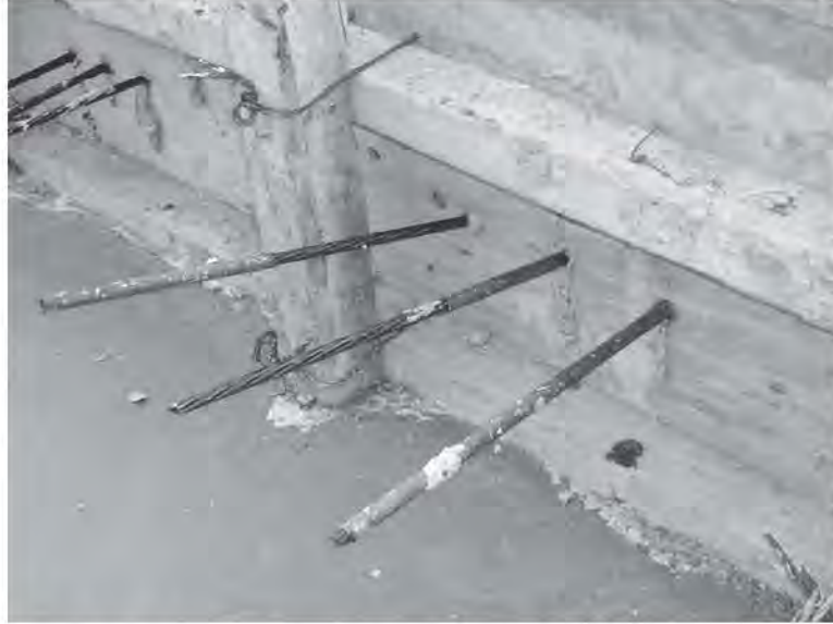
Fig. 3.8.2 Cimbra de frontera
