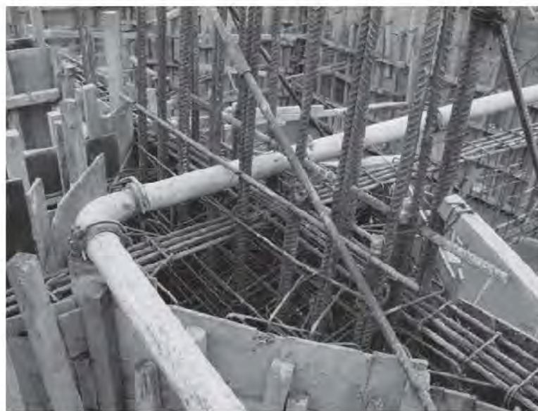
Fig. 2.8.2 Acomodo de la tubería entre las contratrabes
