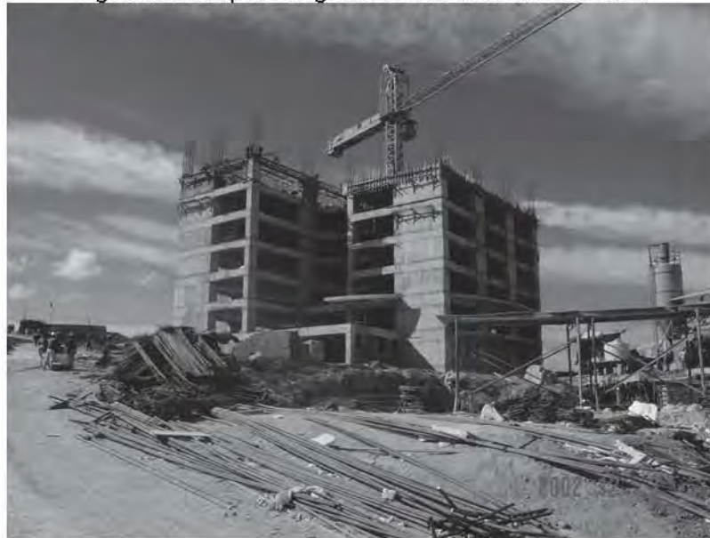
Fig. 5.3.14 Empleo de grúa torre en la elevación de materiales
