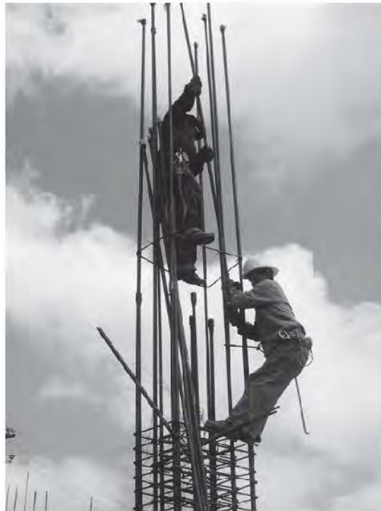
Fig. 3.2.5 Empalme de columnas con conectores mecánicos
