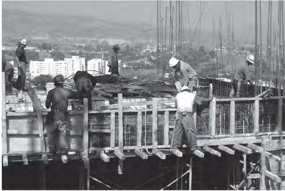
Fig. 3.5.29 Colocación de cimbra en el perímetro de la losa
