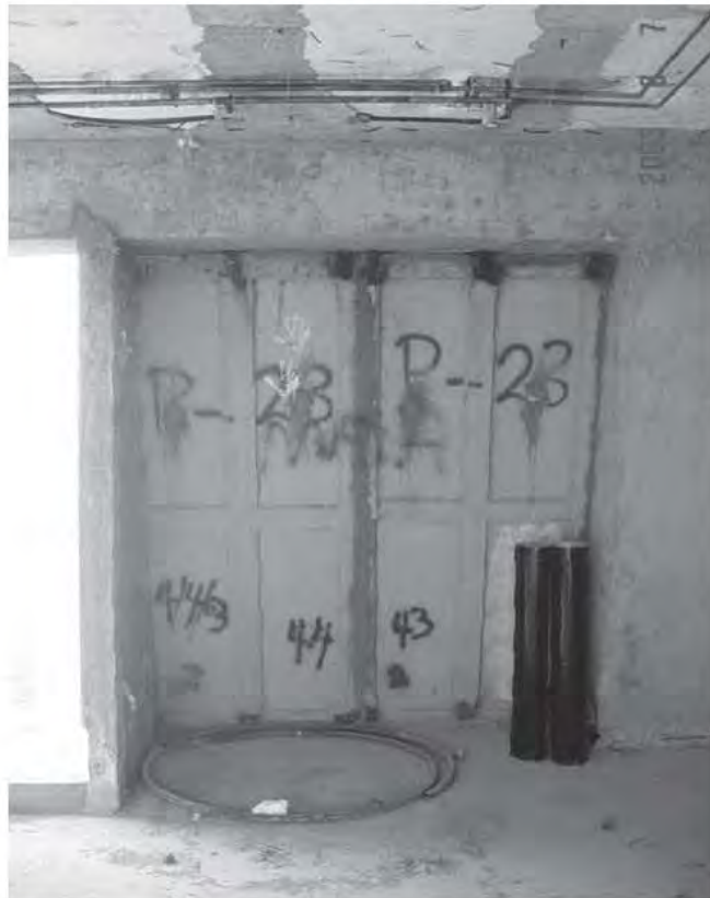
Fig. 4.3.8 Vista de dos elementos prefabricados desde el interior de la torre
