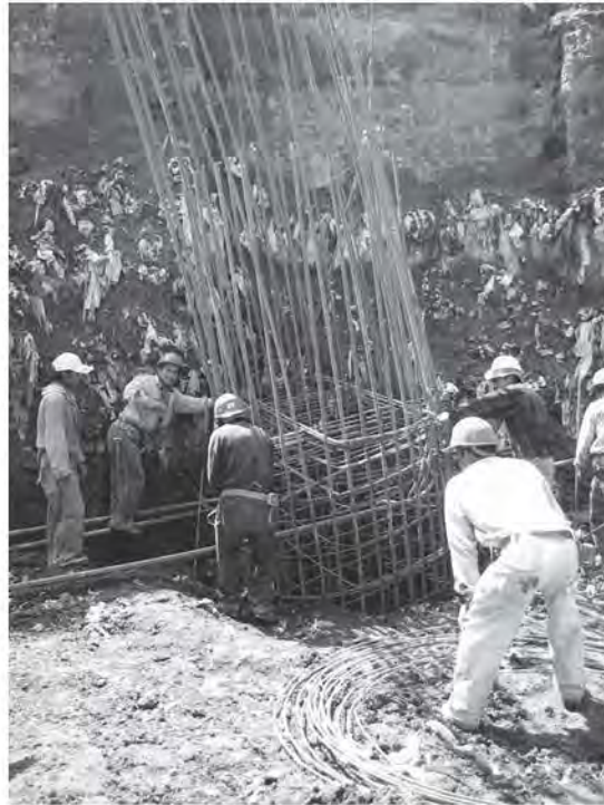
Fig.2.4.5 Introducción de la primera parte en pilas de más de 19 m
