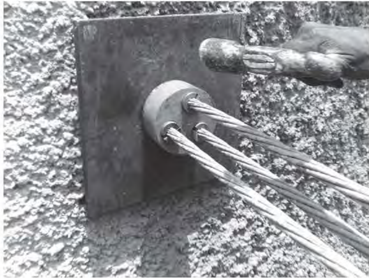
Fig. 5.1.27 Colocación de placa para el tensado
