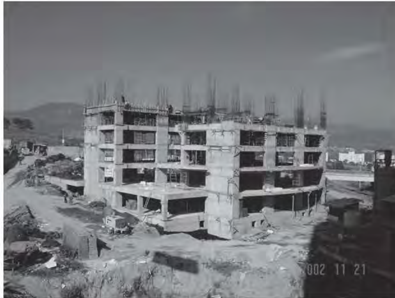
Fig. 5.3.11 Descimbrado de la losa 3 y armado de columnas, cimbrado de frontera para colar la losa 4
