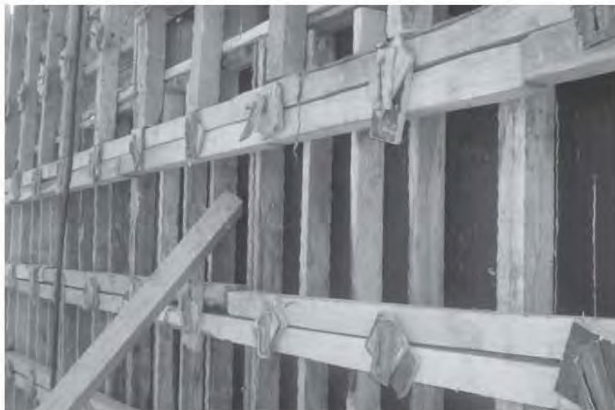
Fig. 3.3.1 Colocación de cimbra en muro
