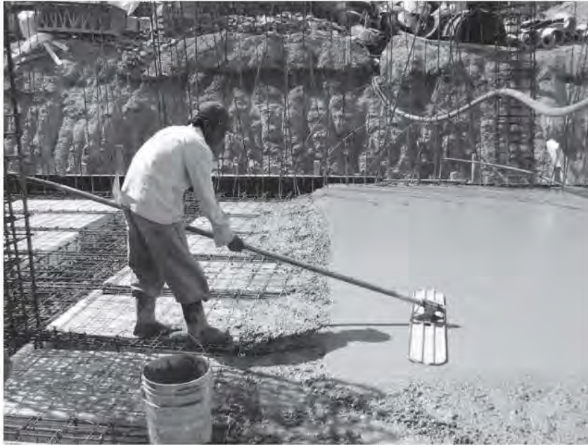
Fig. 3.7.11 Aplanado del concreto
