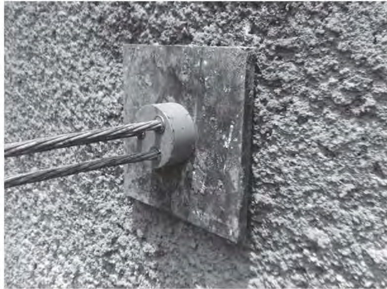
Fig. 5.1.33 Ancla terminada
