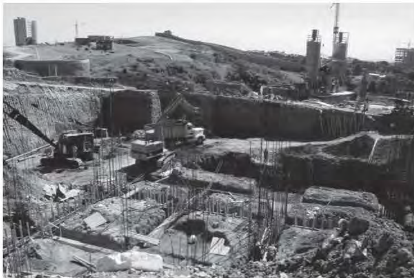
Fig. 2.2.3 Excavación de sistema
