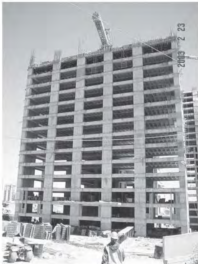
Fig. 5.3.15 Colado de la losa 14 y albañilería en losa 2
