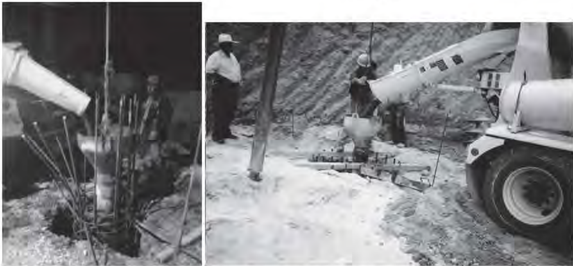
Fig.2.5.3 y 2.5.4 Colado de pilas con ollas a tiro directo
