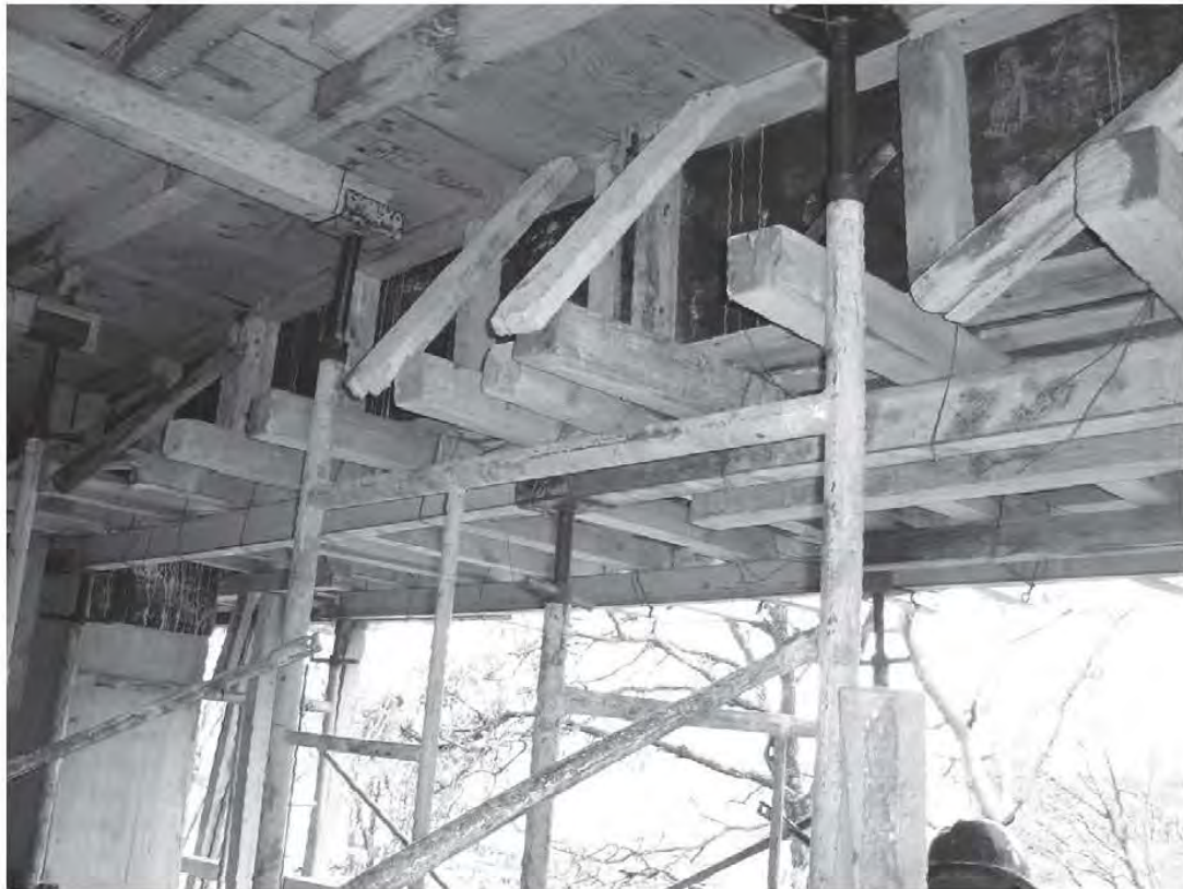
Fig. 3.3.16, 3.3.17 Fondos para traves cimbradas con marcos de alta resistencia
