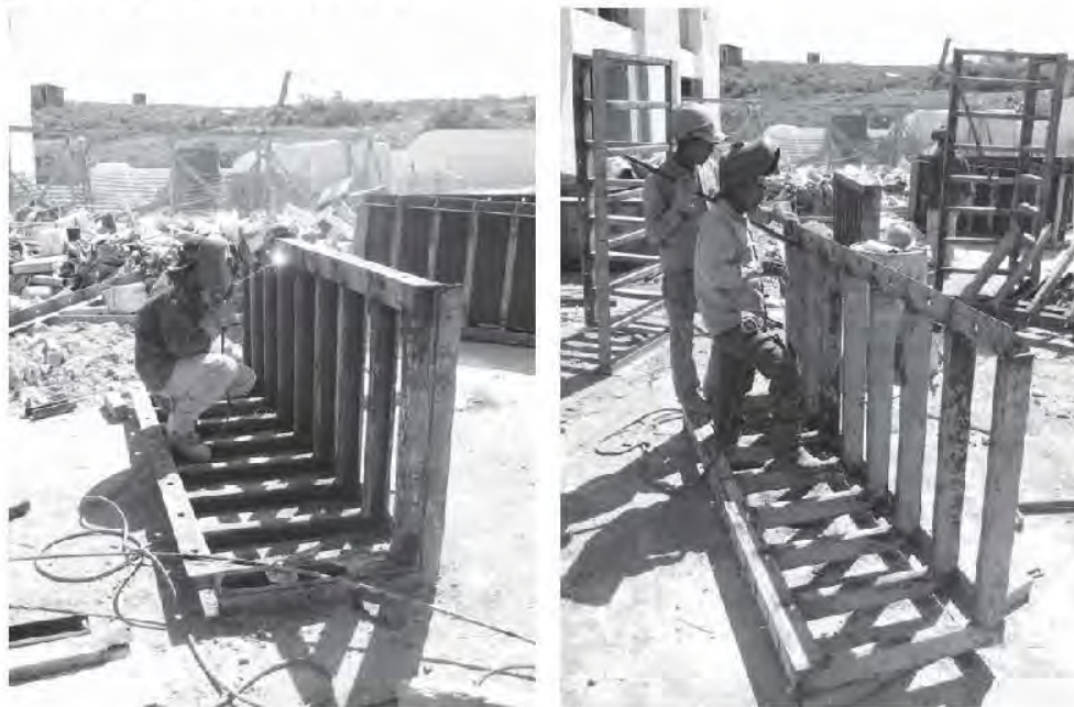
Fig. 3.3.9, 3.3.10 Fabricación de bastidores para columnas
