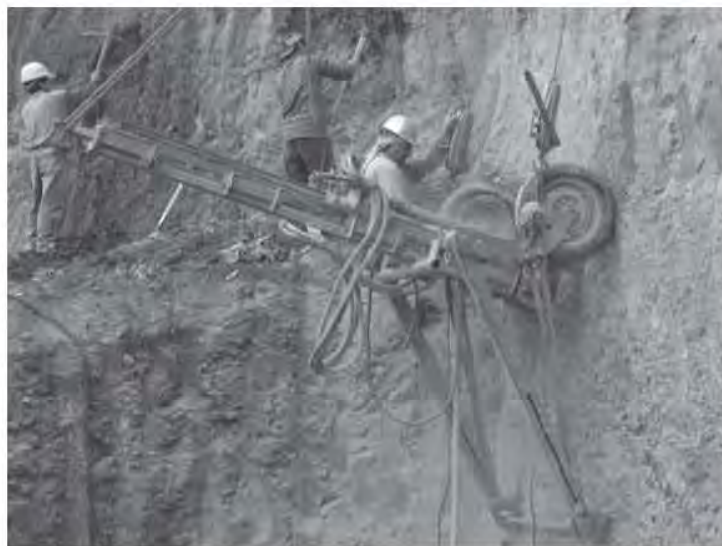
Fig. 5.1.13 Perforación de barrenos para alojar torones
