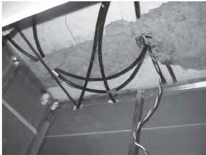
Fig. 4.2.2.10 Instalación hidráulica y eléctrica en plafones
