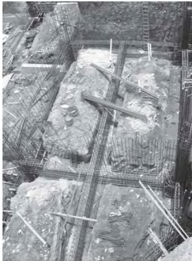
Fig. 2.6.8 2.6.9 y 2.6.10 Armado de dado, contratraves y desplante de columnas
