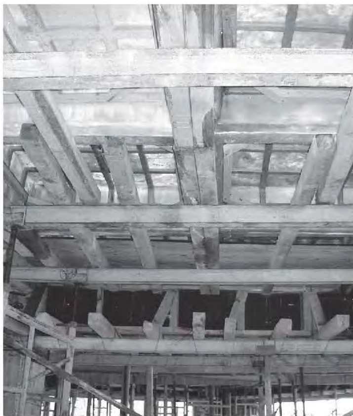
Fig.3.5.14 y 3.5.15 Cimbra de losa
