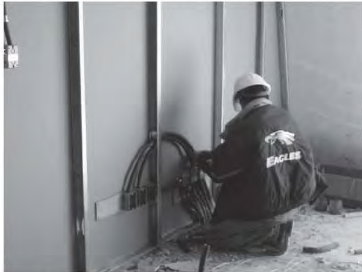
Fig. 4.2.2.5 Colocación de poliducto a los muros
