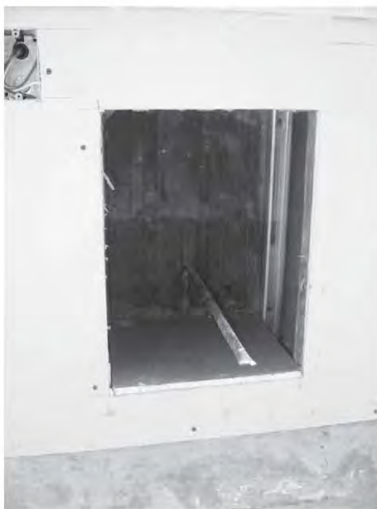
Fig. 4.2.2.8 Hueco en lambrín de tablaroca para alojar filtro de agua de refrigerador
