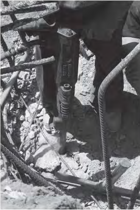
Fig. 2.6.2 y 2.6.3 Demolición de concreto excedente en pilas (Descabezar)
