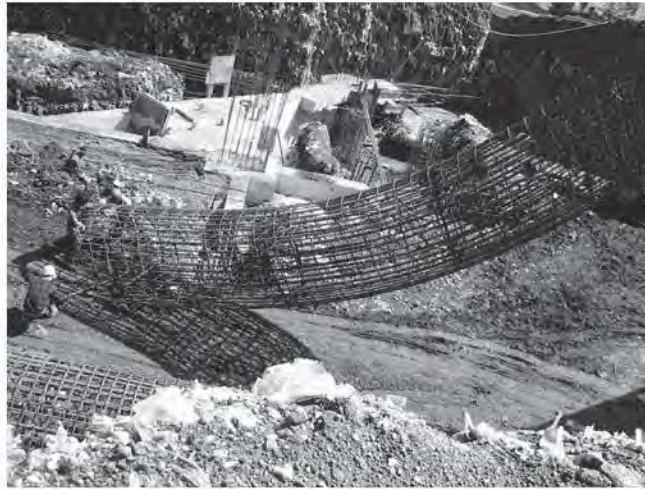
Fig. 2.4.3 Izaje de pilas para su colocación
