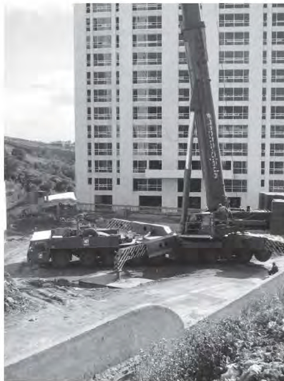
Fig. 5.5.3 Grúa telescópica para desmontaje de la grúa torre
