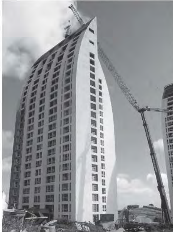
Fig. 5.5.4 Desmontaje de la corona
