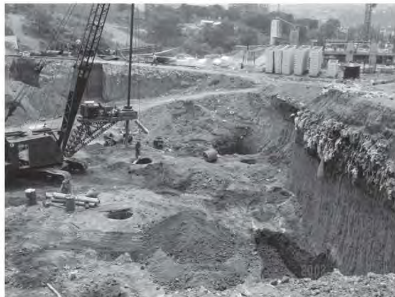
Fig. 2.3.2 Perforación de pilas
