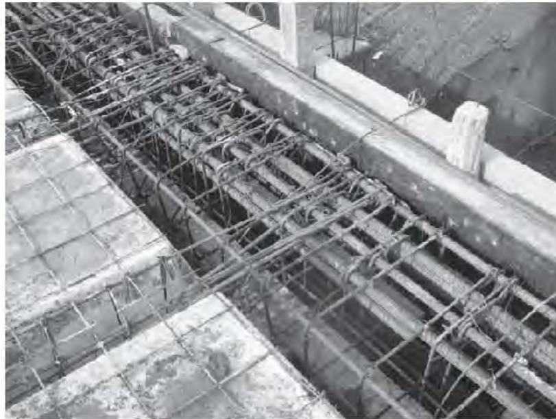
Fig. 3.5.30 Costados de traves terminados
