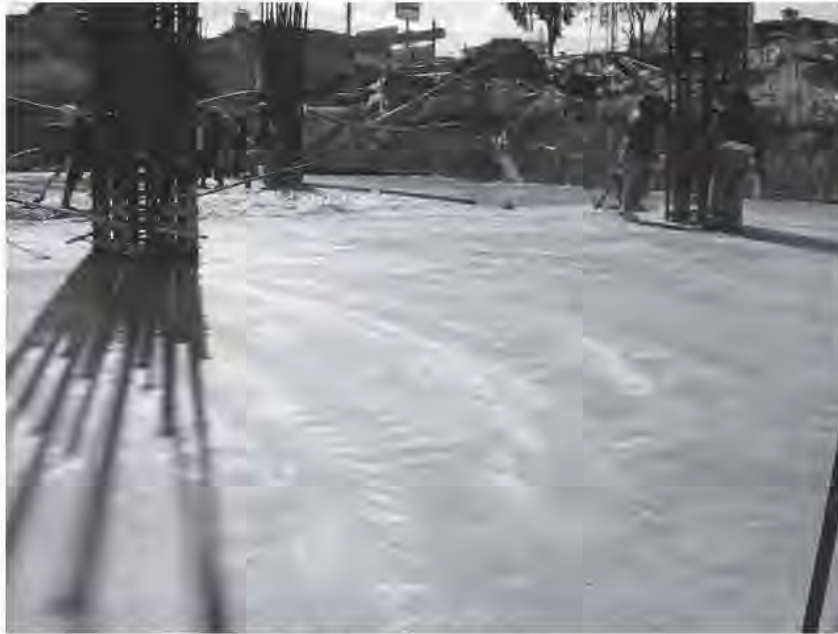
Fig. 3.7.13 Losa pulida a espejo
