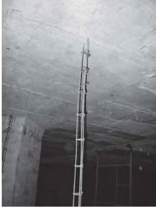
Fig. 4.1.2 Armadura soldada de tres varillas para castillo
