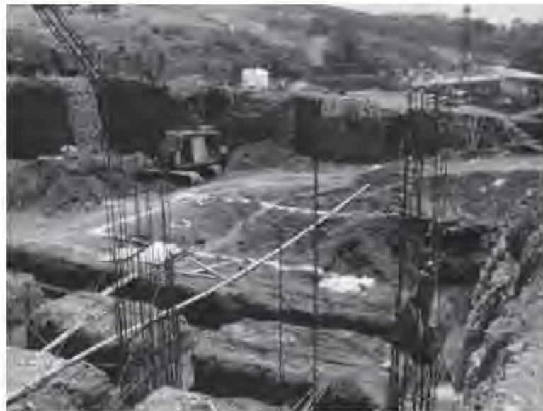
Fig. 2.6.1 Vista de excavación de contratraves
