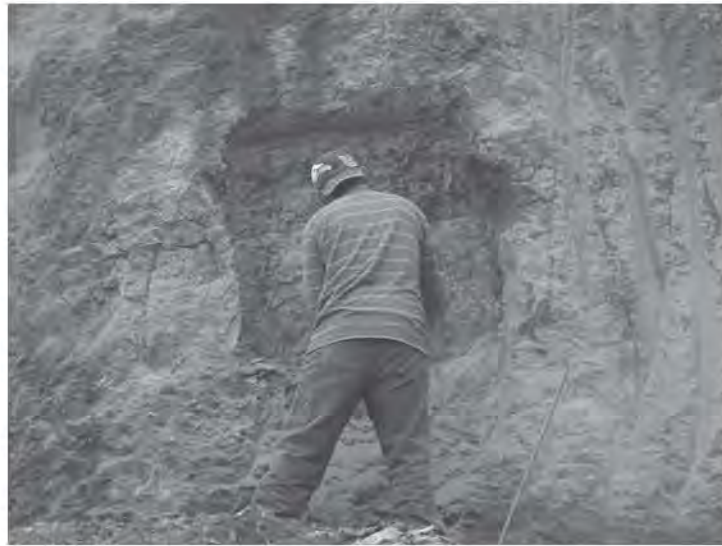
Fig. 5.1.17 Corte para hacer el apoyo del anclaje
