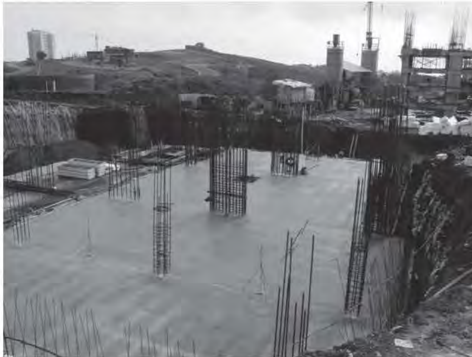
Fig.3.5.11 Losa de estacionamiento colada
