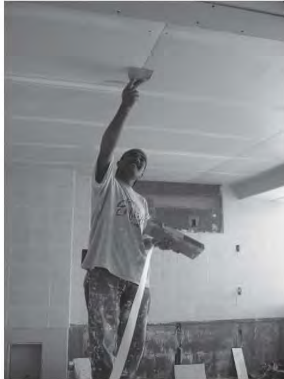
Fig. 4.2.2.22 Colocación de cinta de refuerzo en juntas con el compuesto
