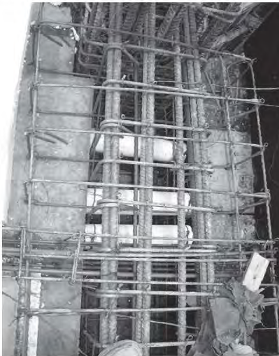
Fig. 3.6.11 Pasos de instalaciones hidrosanitarias
