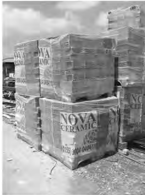
Fig. 4.2.1.10 Almacenamiento de los palets de tabimax
