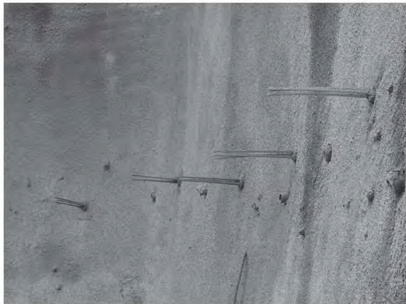
Fig.5.1.26 Concreto lanzado en zona afectada
