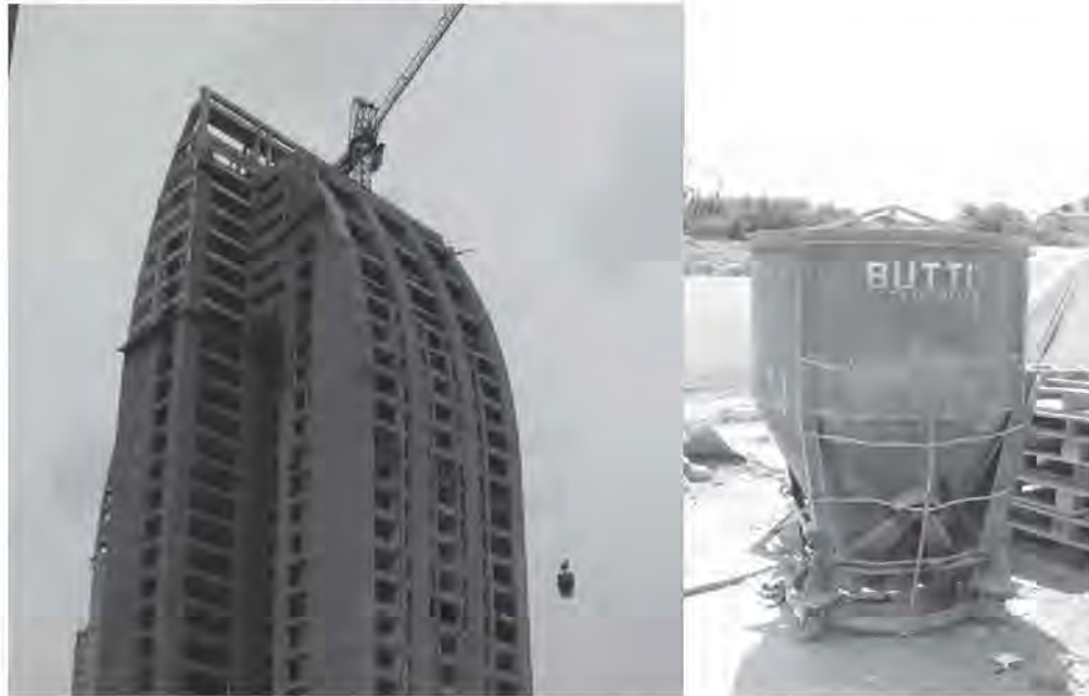
Fig. 3.4.1 y 3.4.2 Elevación de concreto con bachas de acero
