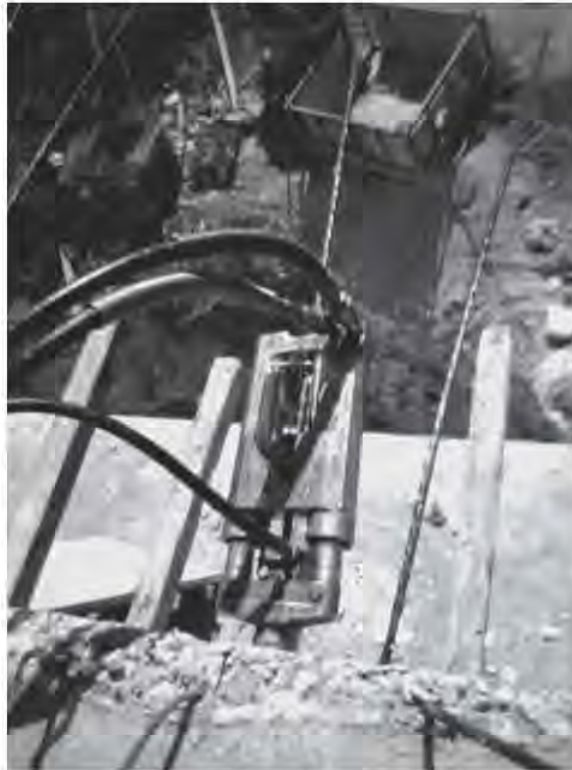
Fig. 3.8.9 Colocación de gato
