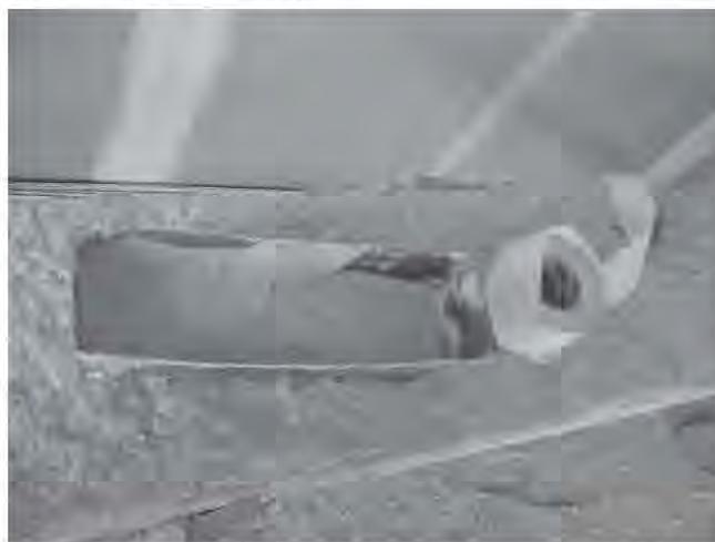
Fig. 4.2.2.21 Compuesto para juntas y cinta de refuerzo
