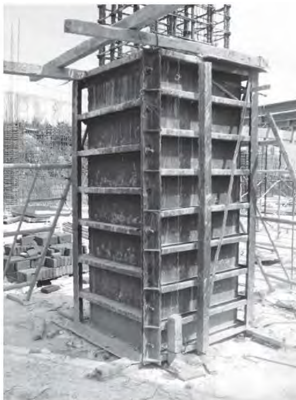
Fig. 3.3.15 Columna cimbrada con molde
