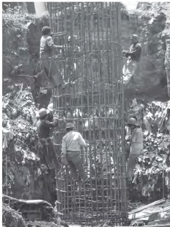
Fig.2.4.6 Armado de la unión de las dos secciones
