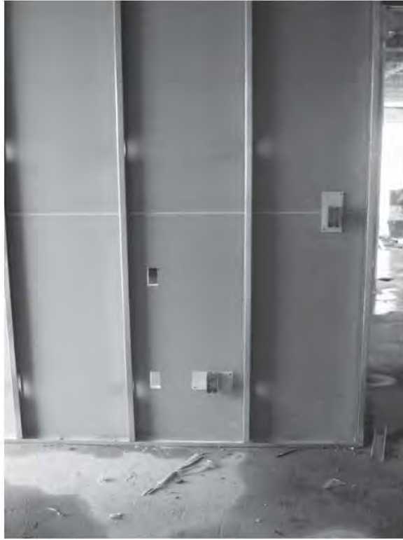
Fig. 4.2.2.4 Huecos y chalupas para contactos y apagadores
