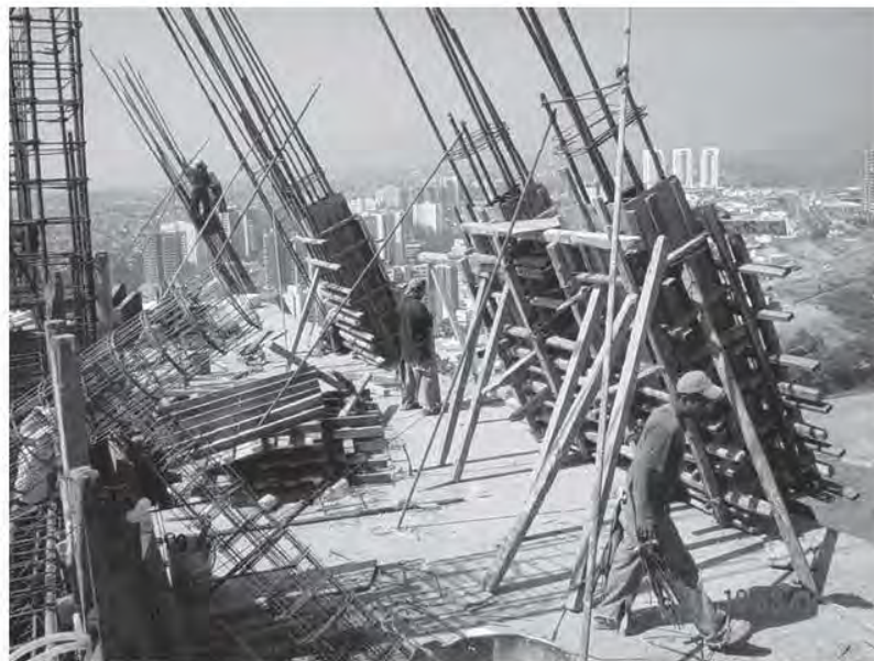
Fig. 3.3.8 Cimbrado de columnas en la parte curva del edificio
