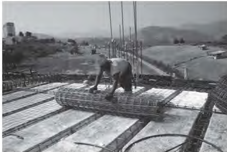
Fig. 3.6.4 Colocación de malla de acero
