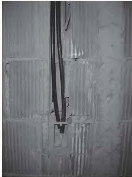
Fig. 4.2.1.7 Ranuras en tabimax para introducir instalaciones eléctricas
