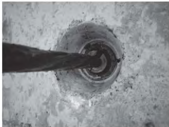
Fig. 3.8.5 Cuñas colocadas listas para colocar el gato
