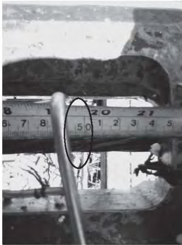
Fig. 3.8.18 Se observa que antes de liberar presión el torón llega a 50 cm. del paño del concreto (10 cm. de elongación)
