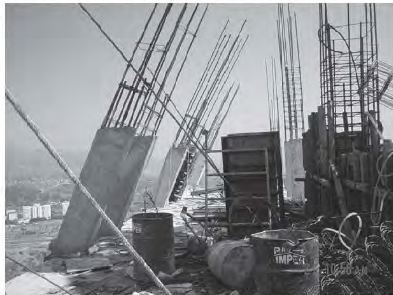
Fig. 3.4.4 Columnas descimbradas
