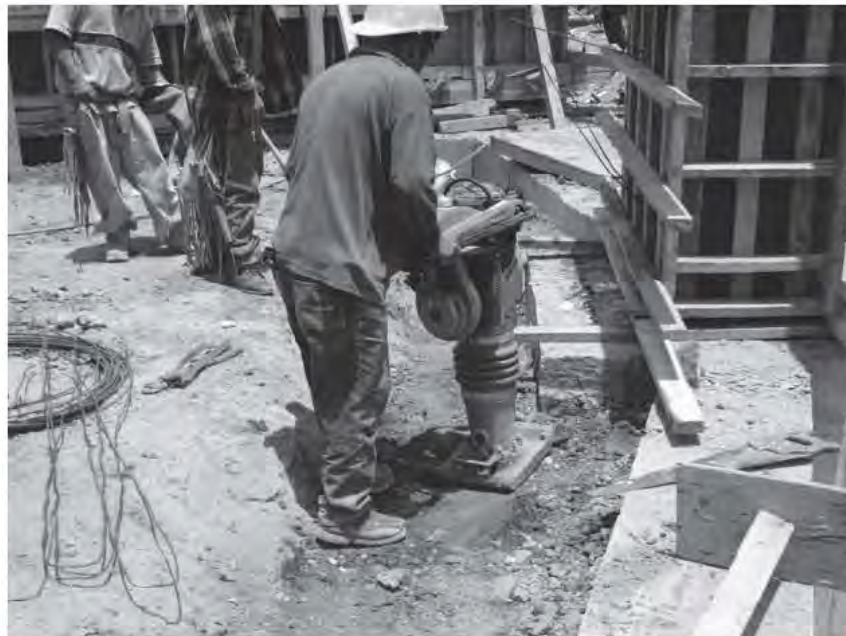
Fig. 2.8.9 Relleno y compactación de huecos en las contratraves
