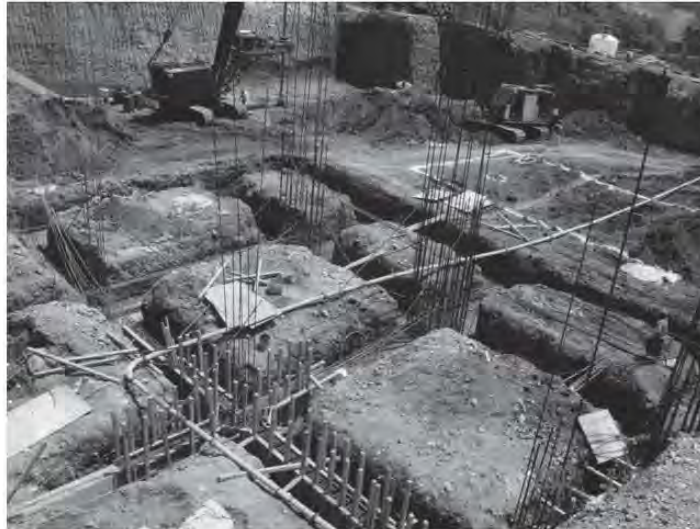
Fig. 5.2.2 Empleo de dos perforadoras para acelerar trabajos de cimentación
