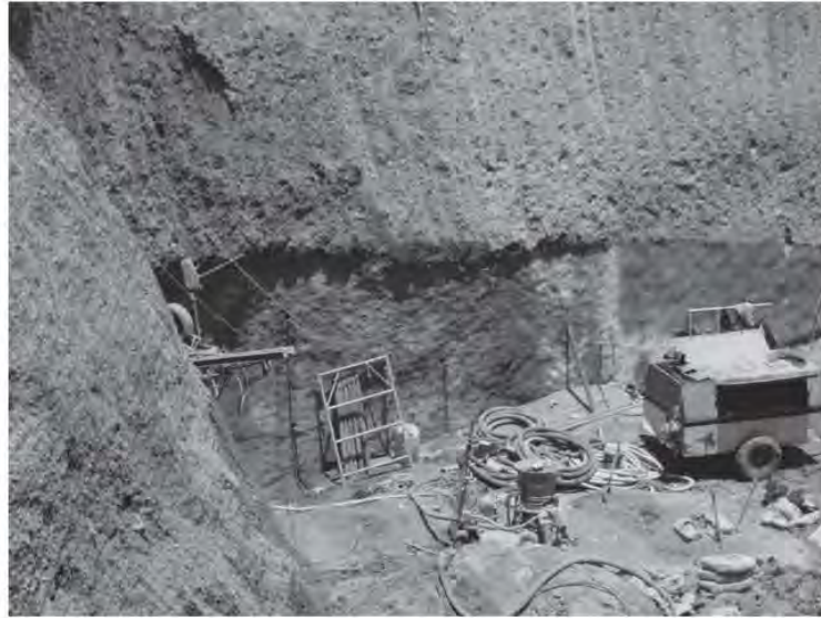
Fig. 5.1.8 Talud estabilizado con concreto lanzado y anclas
