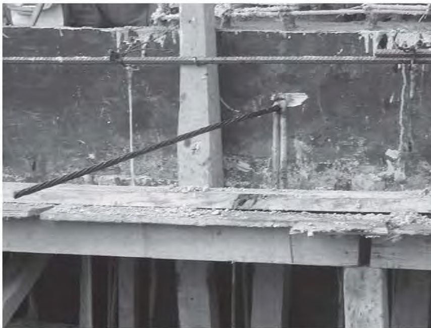
Fig. 3.6.6 y 3.6.7 Paso del cable a través de la cimbra
