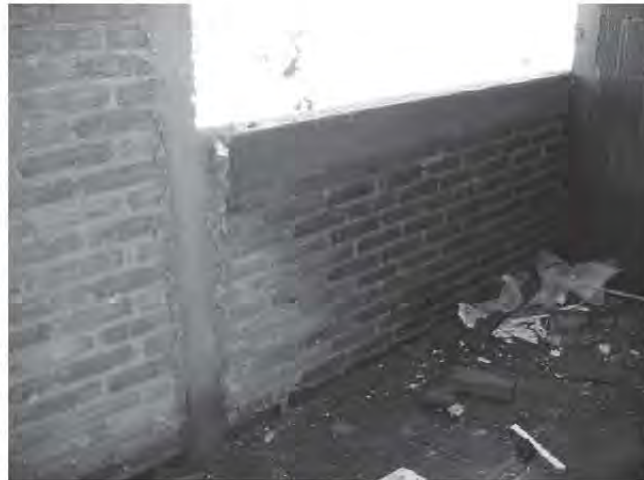
Fig. 4.1.8 Hueco con fiado por castillos y dala
