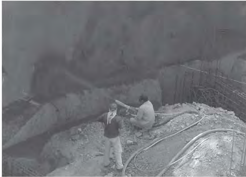
Fig. 5.1.25 Lanzado de concreto
