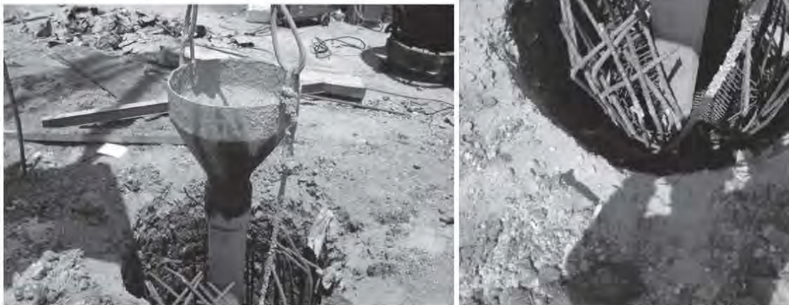
Fig. 2.5.1 y 2.45.2 Tubo tremie inmerso en la pila listo para vaciar concreto
