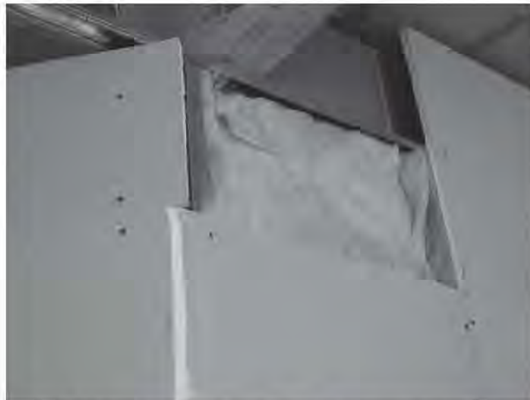
Fig. 4.2.19 Colchoneta de fibra de vidrio termoacústica en muros
