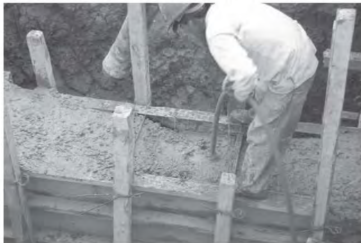
Fig. 2.8.7 Acomodo de concreto en la contratrabe
