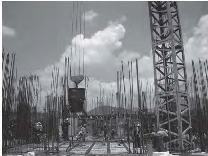
Fig. 3.7.4 Transportación de la bacha con la grúa torre
