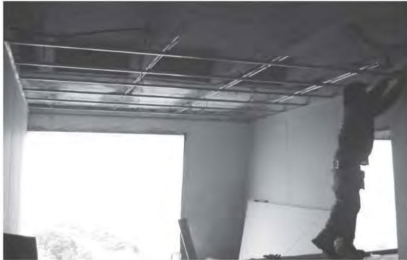
Fig. 4.2.2.13 Armado de Bastidor para plafones
