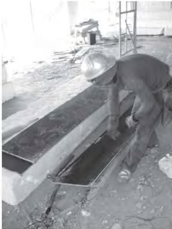
Fig. 3.3.17 Corte de triplay para costados de trabes
