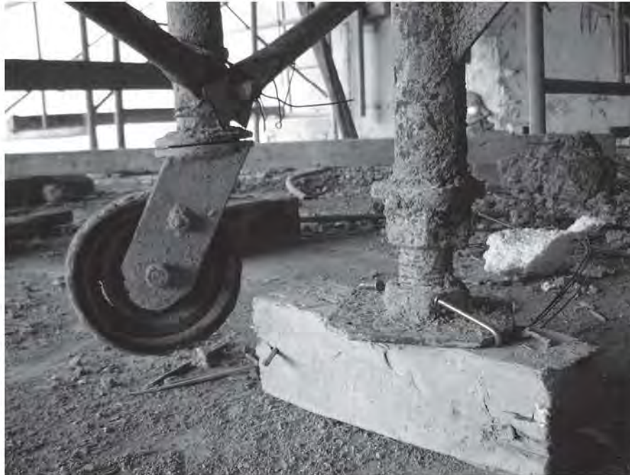
Fig. 3.5.20 Sistema de gato y rueda para fijar y mover las mesas
