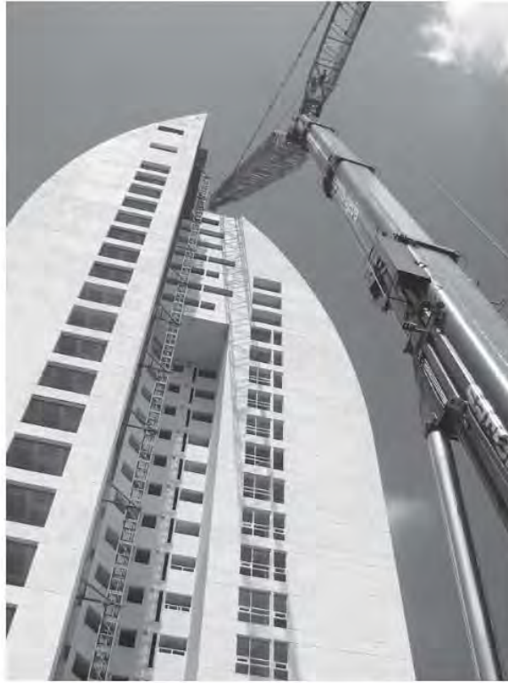
Fig. 5.5.6 Vista del desmontaje
