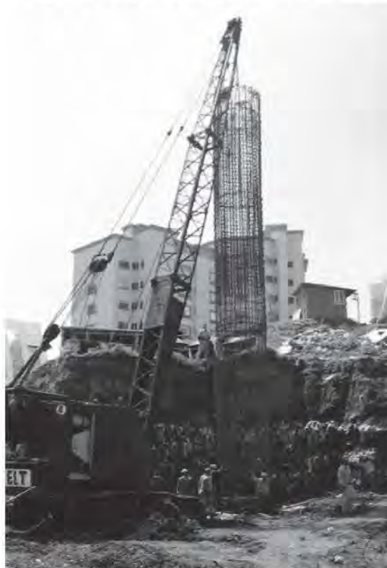
Fig. 2.4.4 Introducción del armado en la perforación
