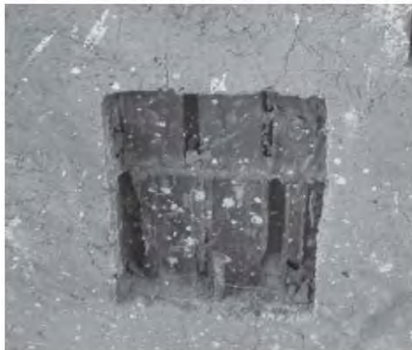
Fig. 4.2.1.9 Hueco en muro de tabimax para filtro de agua de refrigerador
