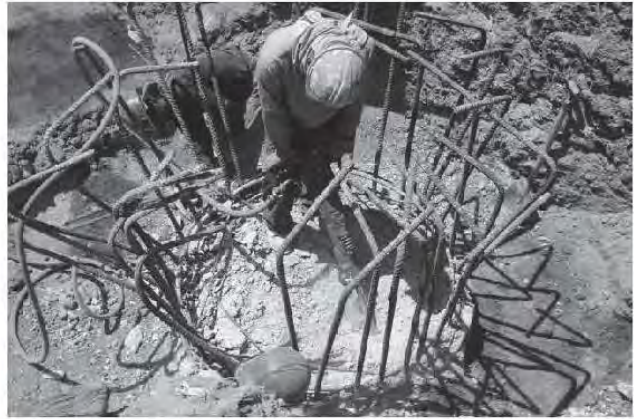
Fig. 2.6.2 y 2.6.3 Demolición de concreto excedente en pilas (Descabezar)
