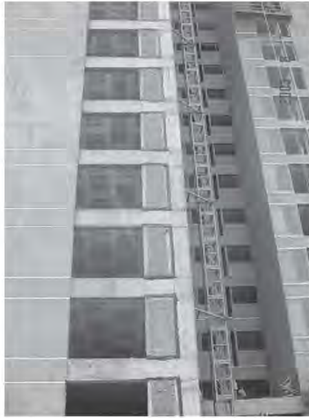
Fig. 4.1.7 Muros de fachada de tabique rojo recocido
