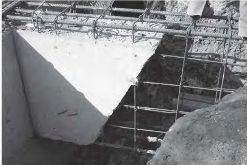
Fig. 2.8.8 Corte de colado en contratraves
