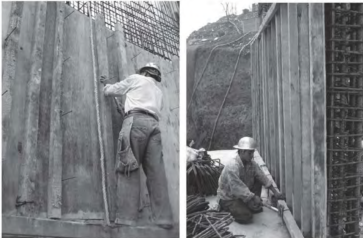
Fig. 3.3.1 Colocación de cimbra en muro
