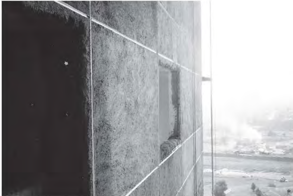
Fig. 4.4.9 Aplanado grueso terminado
