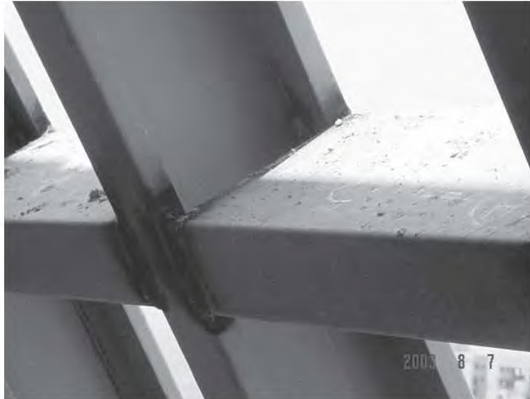
Fig. 4.3.20 Detalle de soldadura del Canal Monten
