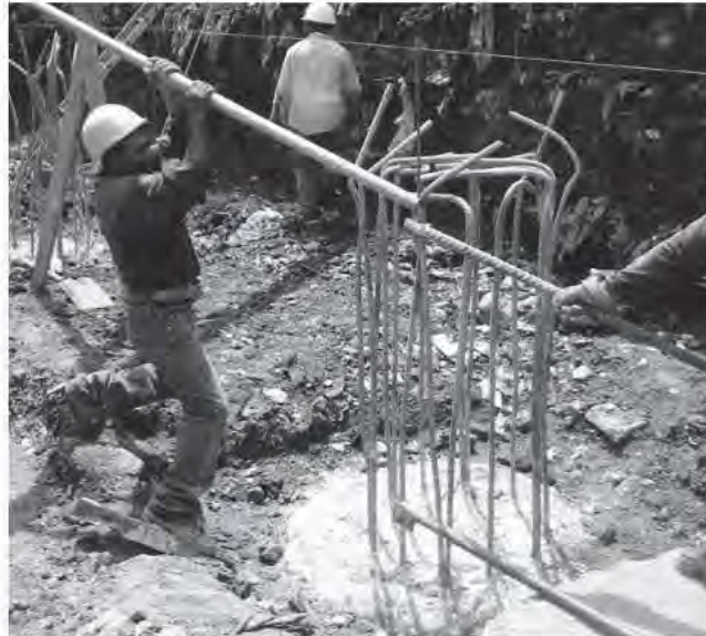
Fig. 2.6.5 Reacomodo de acero de pila descabezada
