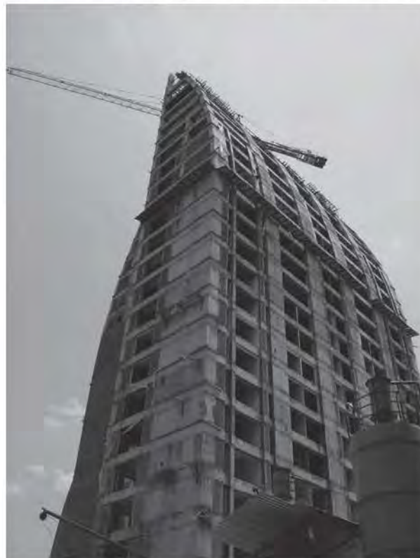
Fig. 5.4.3.3 Colocación de tapias para poder iniciar el aplanado de las fachadas
