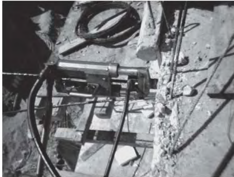
Fig. 3.8.15 Secuencia de tensado
