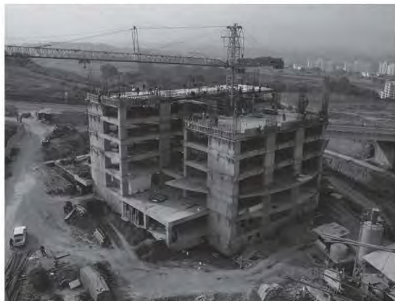
Fig. 5.3.12 Colocación de grúa torre hasta el armado de la losa 5
