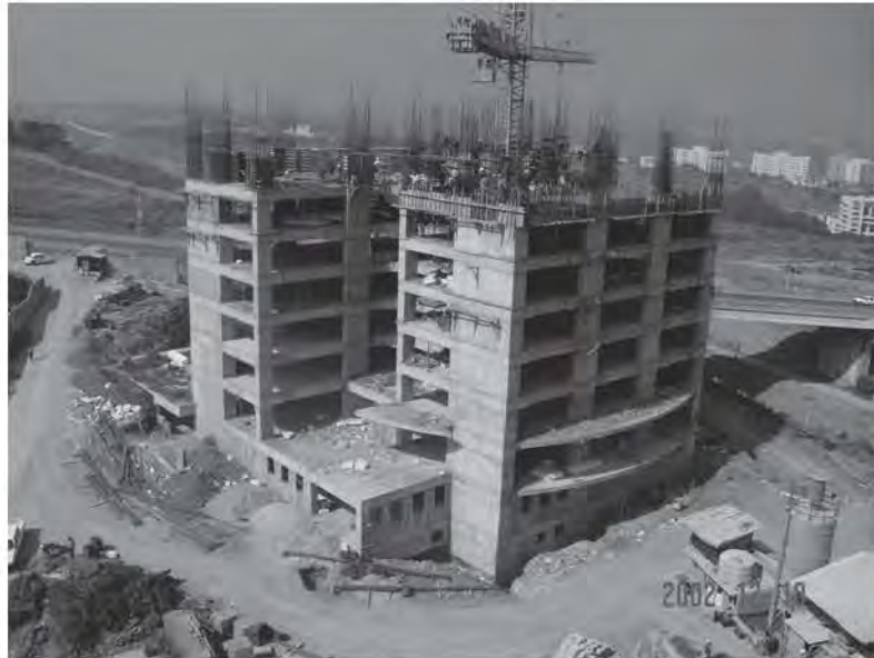
Fig. 5.3.13 Empleo de grúa torre en el colado de losas
