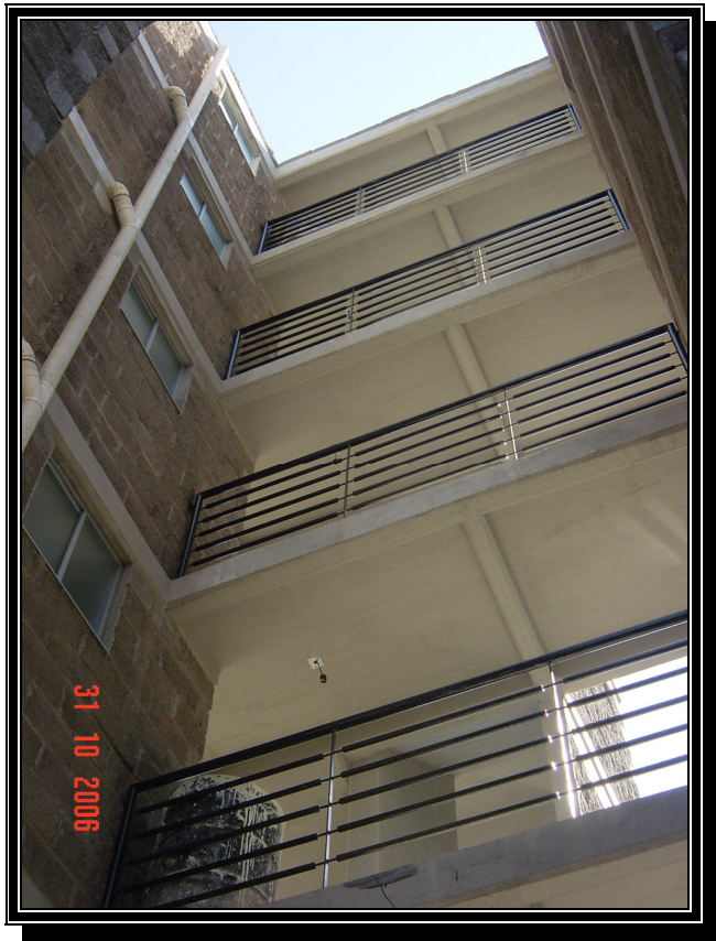
VISTAS INTERIORES DE EDIFICIOS
