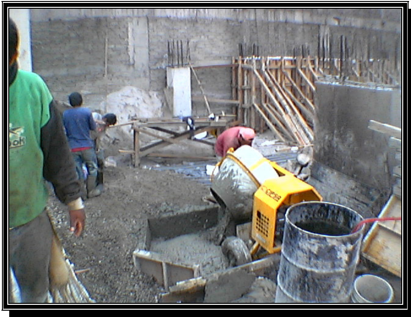
FABRICACIÓN DE CONCRETO
