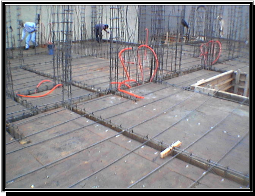
COLOCACIÓN DE ARMADO DE ACERO EN LOSA DE ENTREPISO
