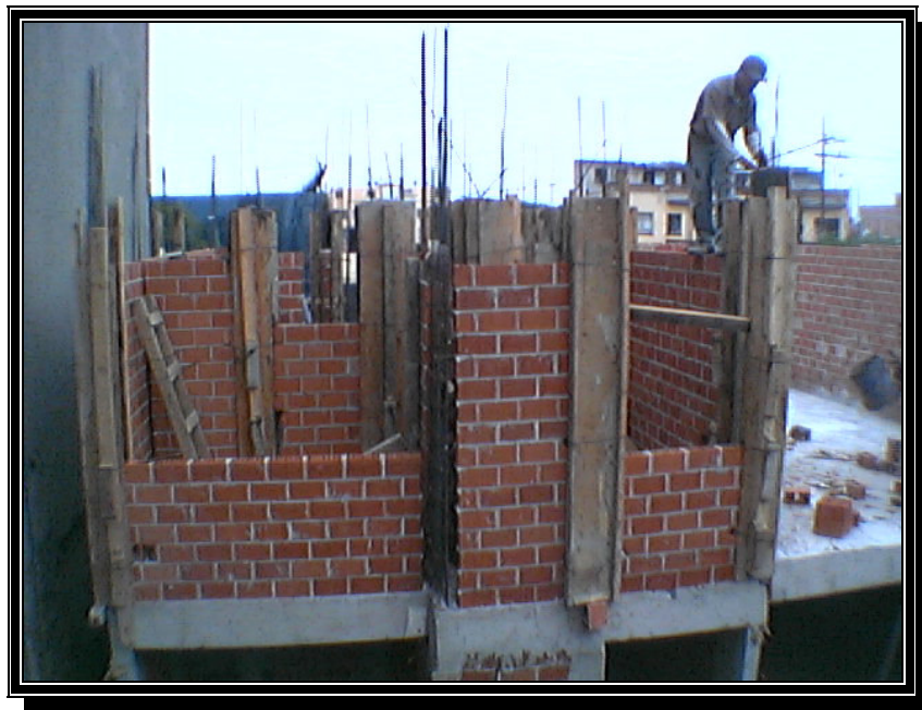
COLADO DE CASTILLOS CON CONCRETO HECHO EN OBRA
