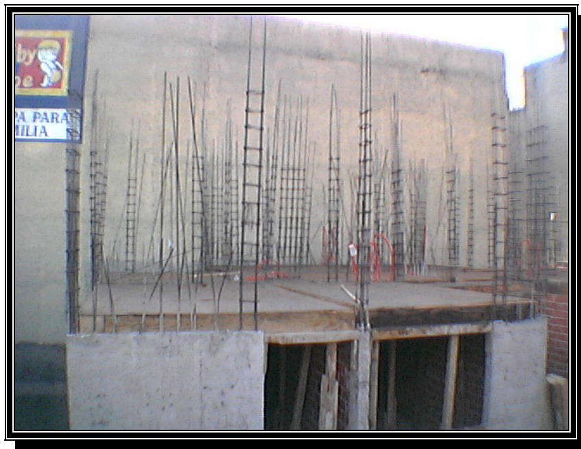
COLOCACIÓN DE CIMBRA PARA LOSA DE ENTREPISO
