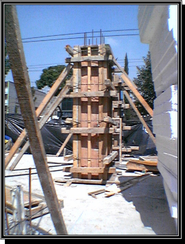
CIMBRA DE COLUMNAS
