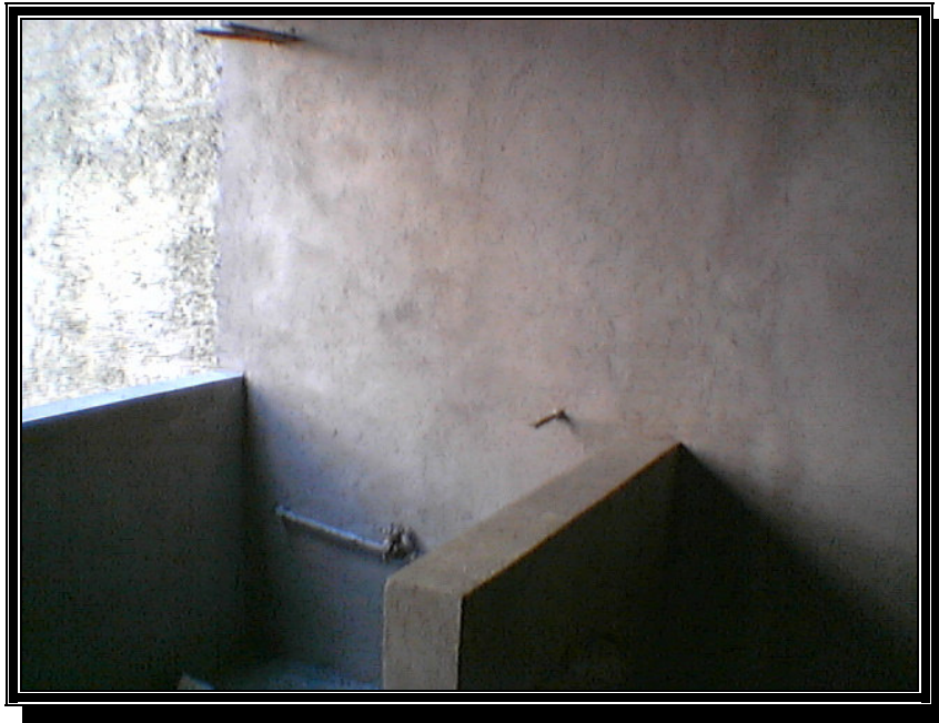
APLANADOS EN COCINAS, BAÑOS Y PATIOS DE SERVICIO.
