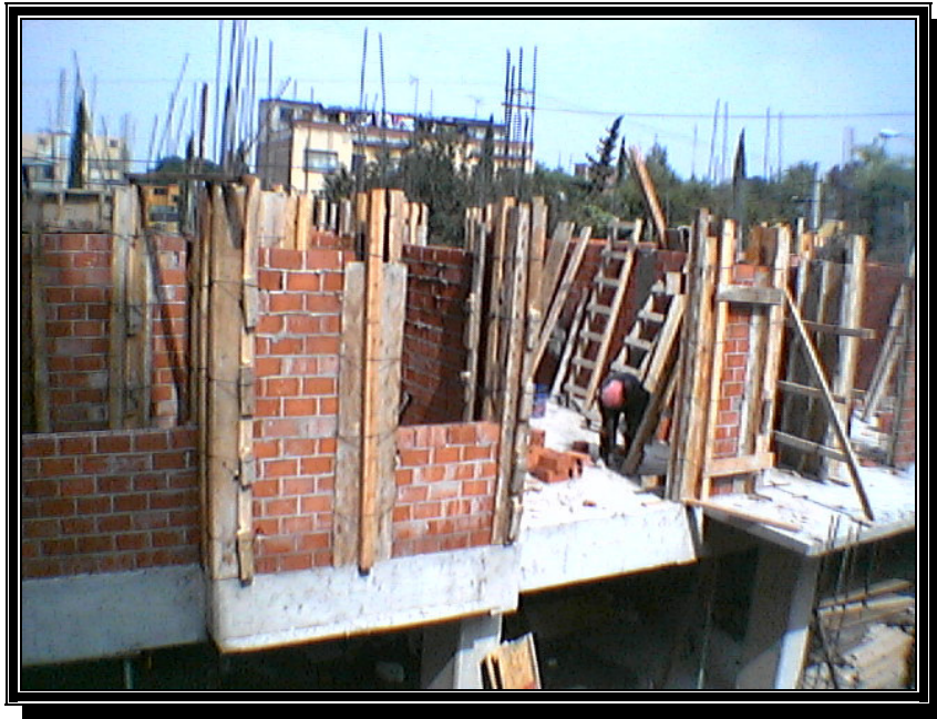
CIMBRA EN MUROS Y CASTILLOS
