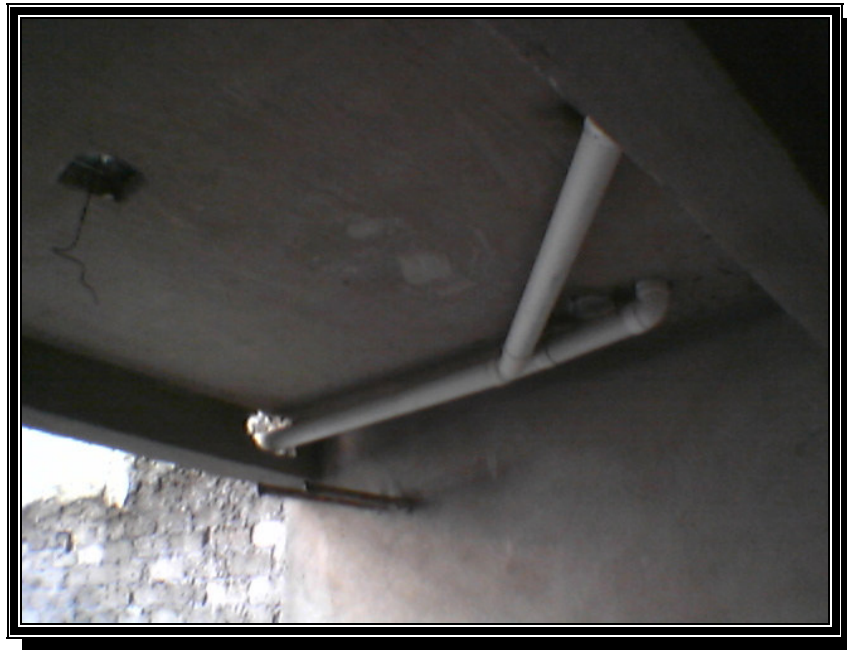
RAMALEO DE INSTALACIÓN SANITARIA
