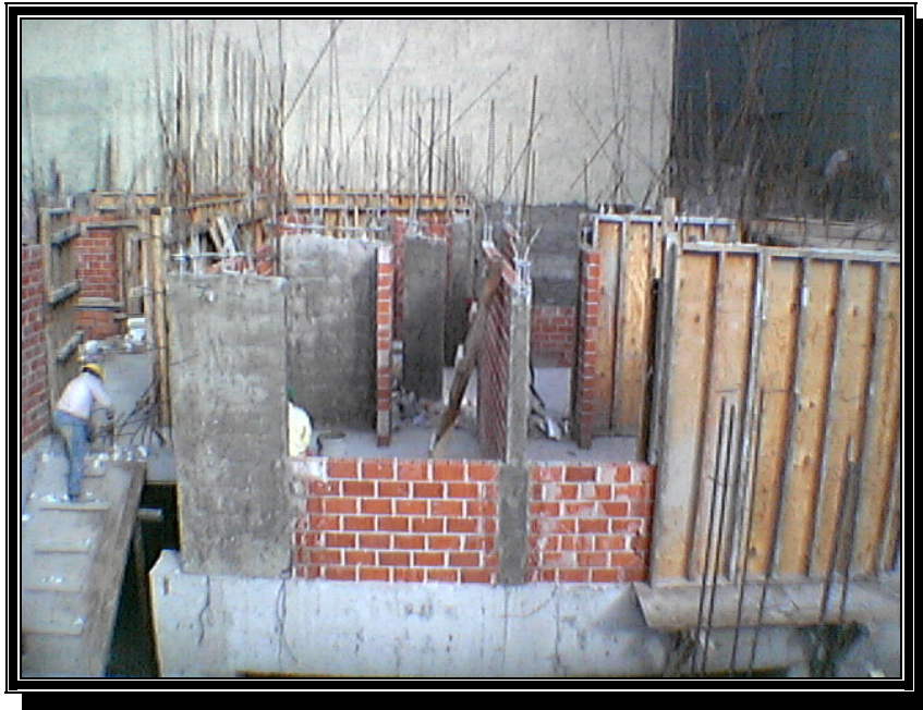
DESCIMBRADO DE MUROS Y CASTILLOS
