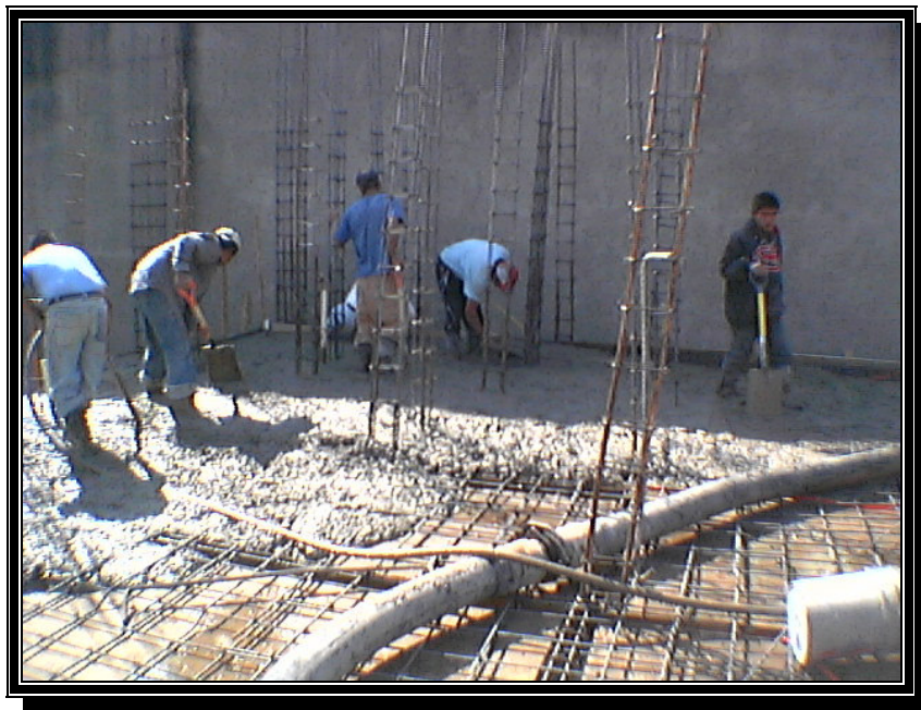
COLADO DE LOSA DE ENTREPISO
