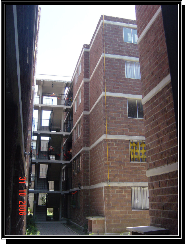
VISTAS INTERIORES DE EDIFICIOS
