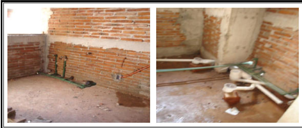
En el Edificio "E" se esta habilitando tanto la instalación hidraulica como sanitaria, pero se puede apreciar los pasos por elementos estructurales.
