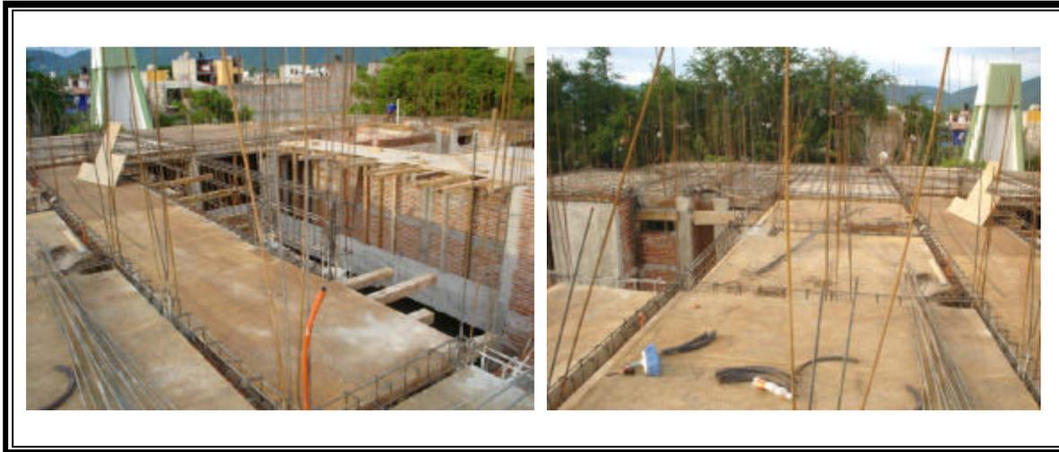
Faltaba terminar el armado de la 2a. Losa de entrepiso del Edificio "E", el cual se espera terminar y proceder al coldado.
