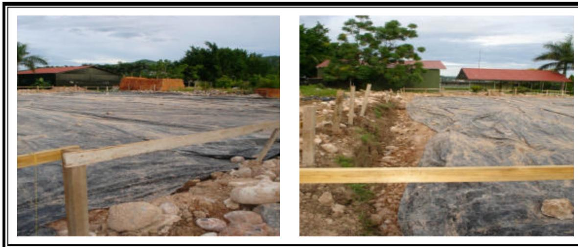
Debido a las lluvias se ha estado cubriendo la plataforma del tercer edificio para protegerla y evitar nuevamente la saturación de agua.
