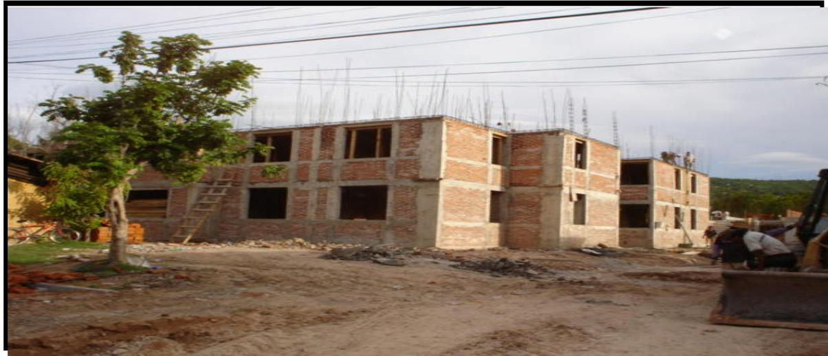
Aspecto general del edificio tipo 12820- el cual se esta habilitando acero para colar el 2o. entrepiso , a la fecha debería estar realizando trabajos de bases y apoyos para instalación de equipos de los cuales aun no han empezado.
