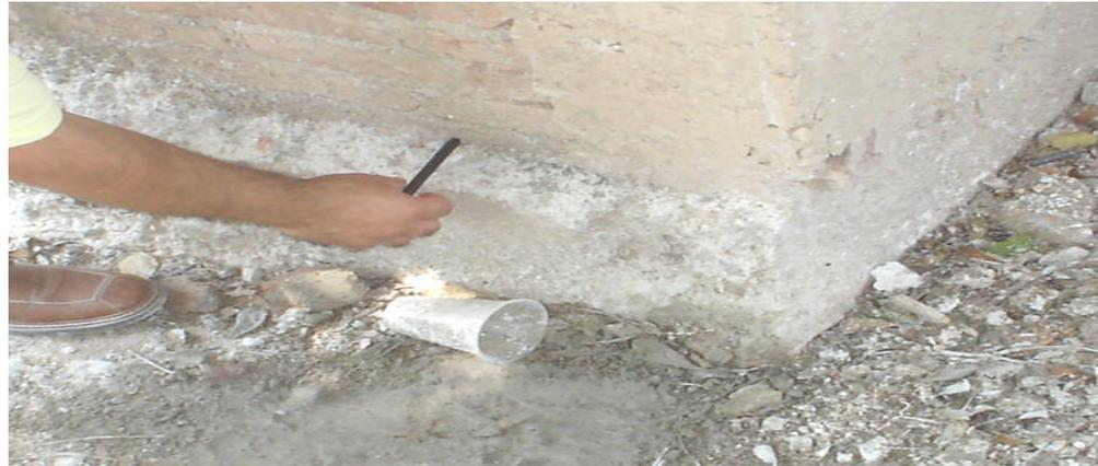
En la cimentación del edificio "E" existe un excedente de concreto en la cimentación, la cual se tendra que subsanar por parte de "El Contratista"
