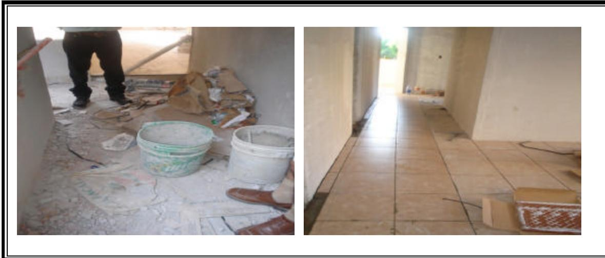
Se puede observar que no hay seguimiento constructivo, se esta colocando loseta en pisos sin haber concluido trabajos de albañilería
