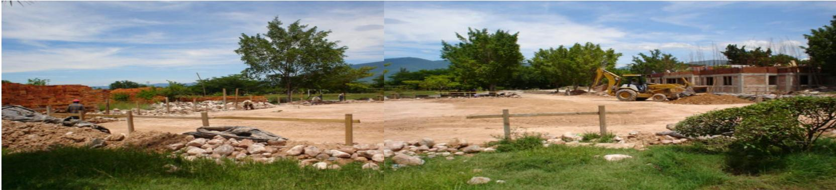
El Edificio "G" no ha podido ser cimentado, debido entre causa el temporal de lluvias, el cual ha provocado a que nuevamente se este compactando para despues realizar el trazo.
