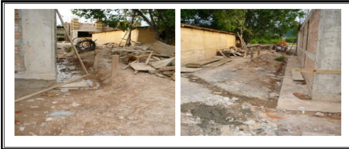
La falta del retiro del material productos de las excavaciones ha provocado como se puede observar cambios en la topografía del terreno.
