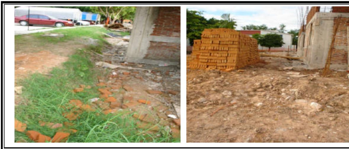
El temporal de lluvias ha provocado, debido a la falta de limpieza en la obra, encharcamiento y problemas en la ejecución de la obra, así como provocado cambios de niveles.
