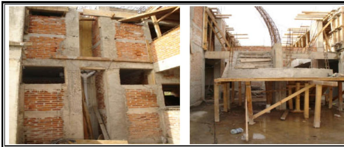
Aspecto general del cubo de las instalaciones, realizando las salidas de instalaciones hidráulica y sanitaria y del cubo de escaleras del mismo edificio el cual deberían estar terminadas y en trabajos de forjado de escalera y jardineras
