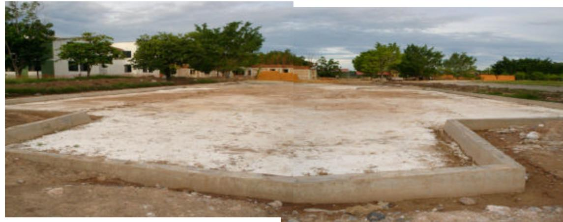
Dentro de los trabajos esta el estacionamiento, el cual se compacto, se realizaron las guarniciones, sin embargo debido a la falta de la instalación hidráulica, se saturó de agua, provocando que nuevamente se mejore el terreno.
