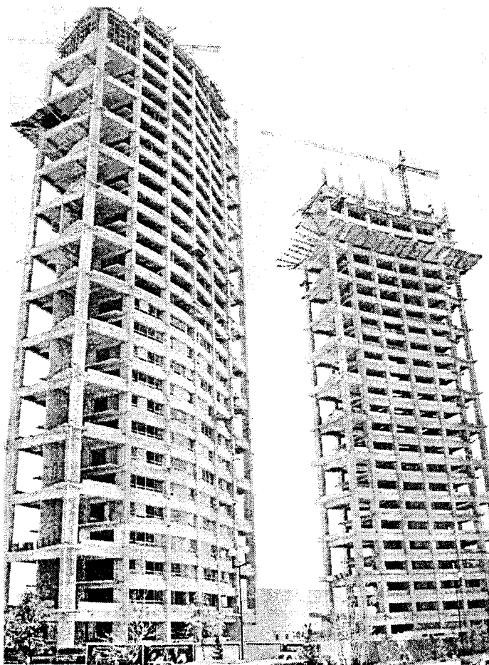
Construcción de condominios de lujo en Guadalajara
