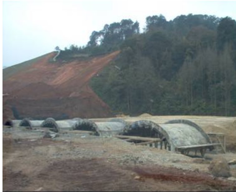
Fotografía 57: Cimbra metálica para bóvedas
