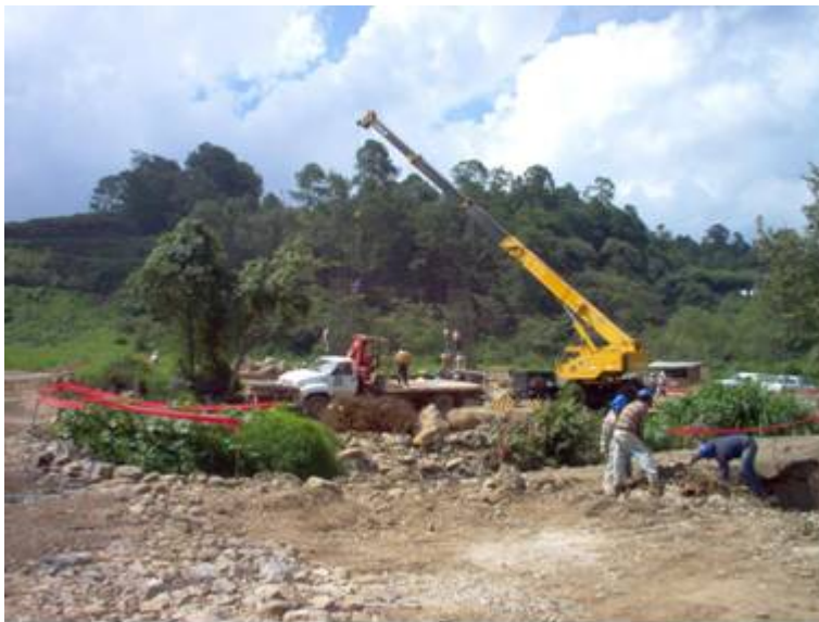
Fotografía 21: Equipo utilizado (Camión de carga y Grúa)
