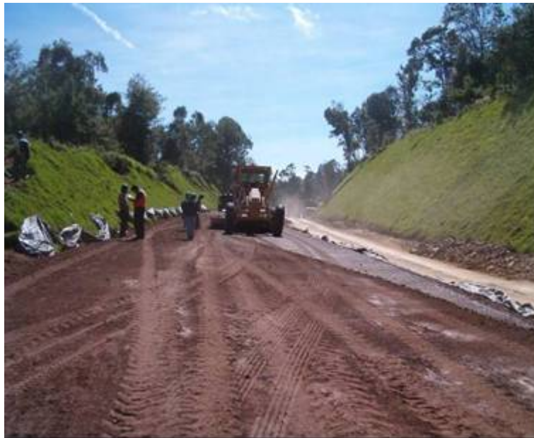
Fotografía 50: Formación de capa de base hidráulica.
