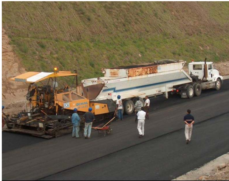
Fotografía 56: Colocación de carpeta asfáltica
