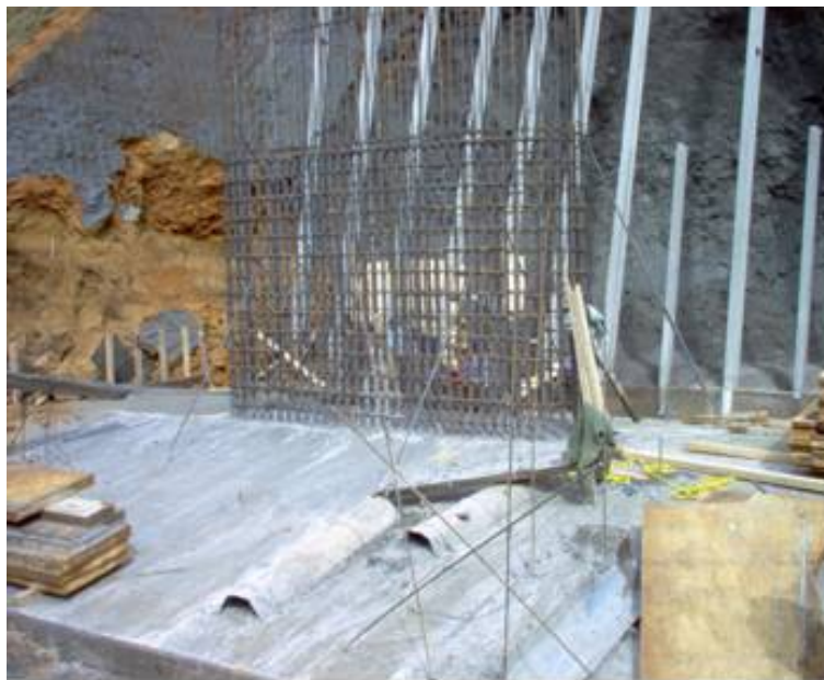
Fotografía 38: Concreto lanzado en la zona de los PIVs
