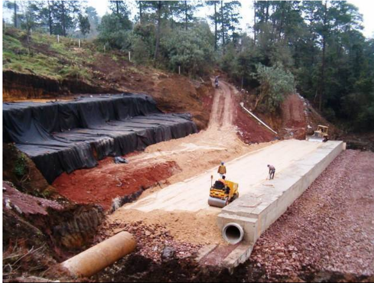
Fotografía 29: Obras de drenaje en terraplenes
