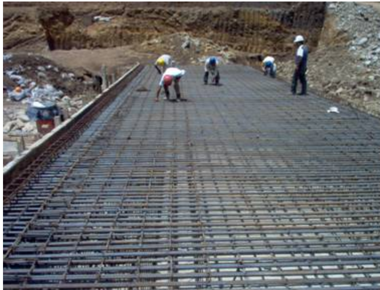
Fotografía 60: Colocación de acero de refuerzo en bóvedas
