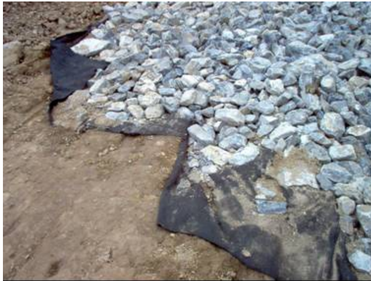
Fotografía 43: Utilización de geotextil separador.
