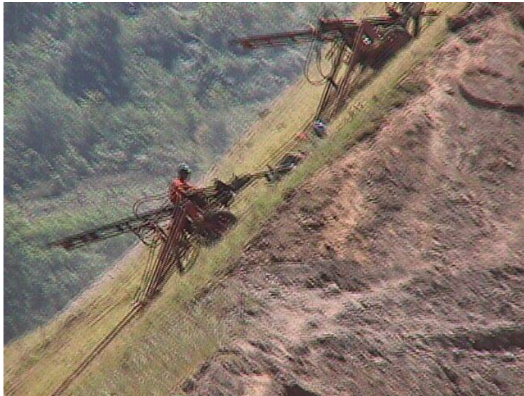
Fotografía 68: Perforaciones para los drenes transversales de penetración.
