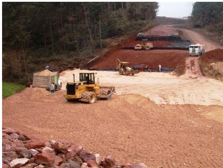
Fotografía 33: Proceso de formación de terraplenes.
