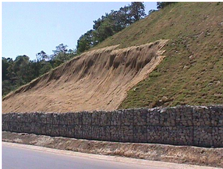
Fotografía 39: Colocación de muros gavión.
