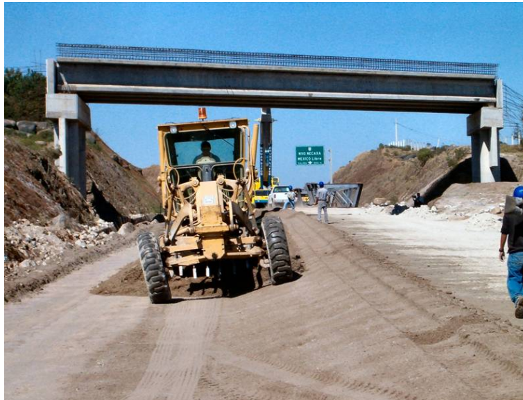
Fotografía 12: Compactación de la capa de base.
