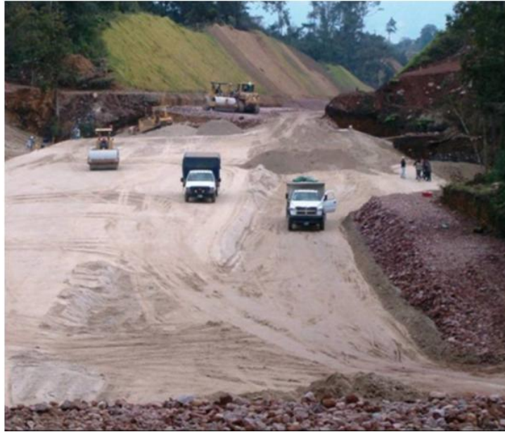
Fotografía 28: Formación de terraplenes.
