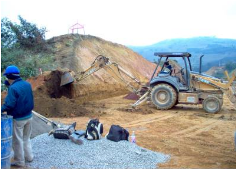
Fotografía 63: Desplante de las obras de drenaje menor
