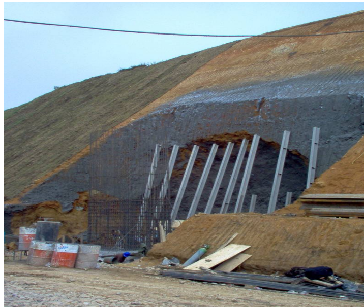
Fotografía 25: Concreto lanzado en la zona de los PIVs
