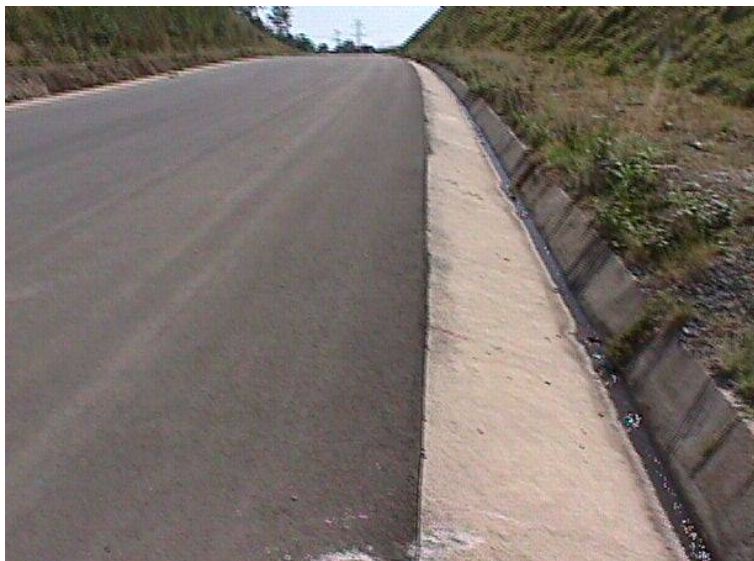
Fotografía 14: Obras complementarias (cunetas)
