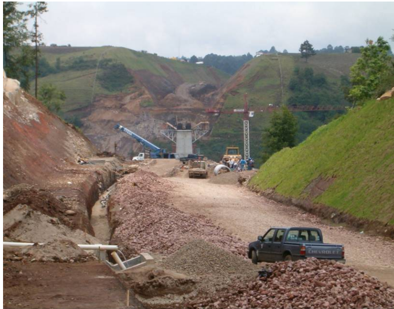
Fotografía 67: Construcción de subdrenes
