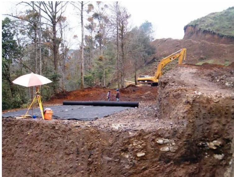
Fotografía 44: Proceso de encapsulado con el geotextil.
