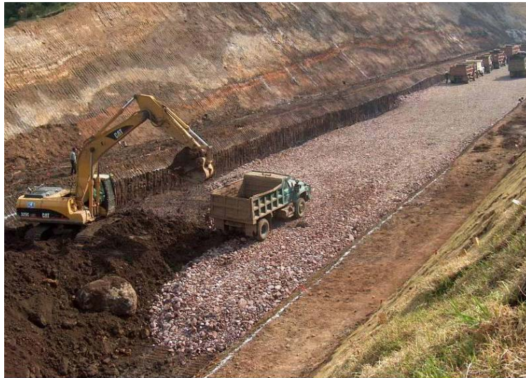
Fotografía 9: Proceso de excavación
