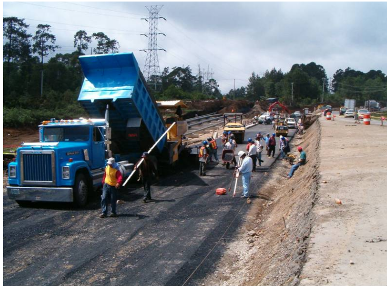
Fotografía 13: Colocación de la carpeta asfáltica
