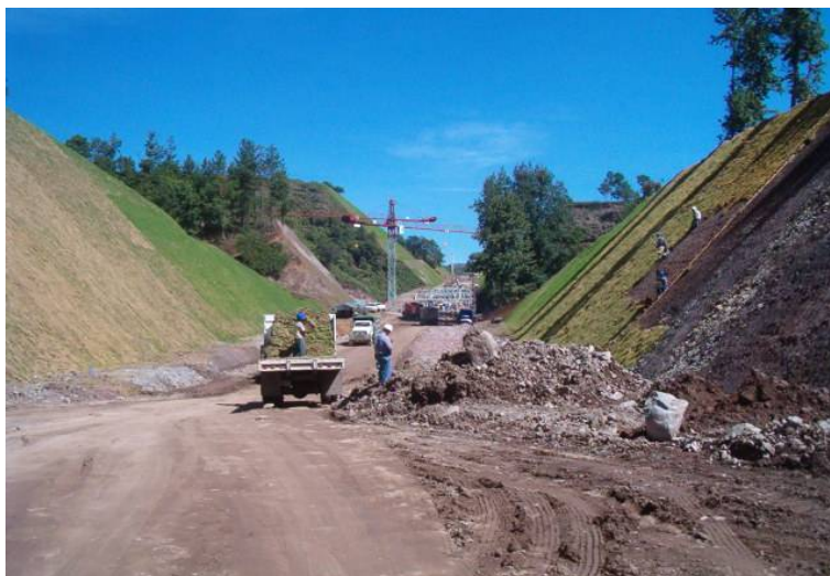
Fotografía 36: Colocación de pasto en taludes
