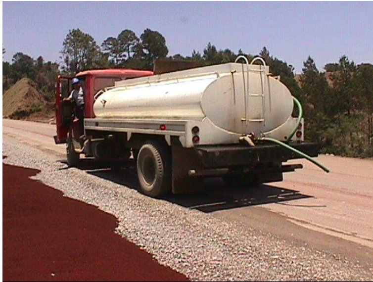
Fotografía 18: Equipo utilizado (Pipas con agua)
