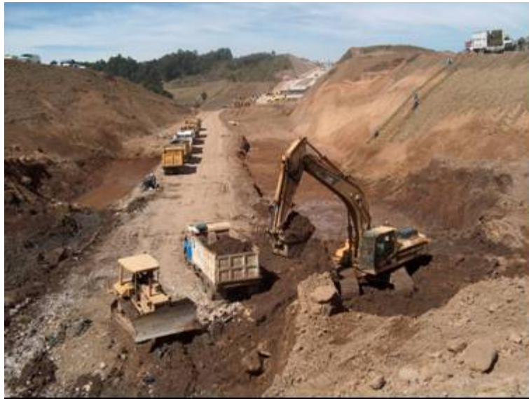
Fotografía 11: Excavación para la formación de terraplenes.
