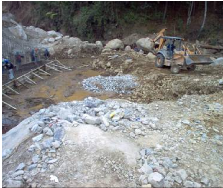
Fotografía 59: Colocación del material con bandeos
