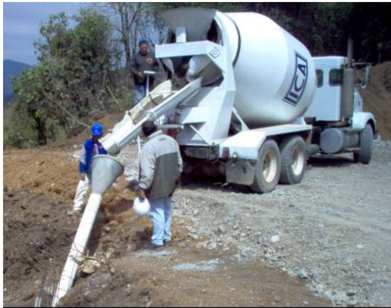
Fotografía 65: Colado de las obras de drenaje menor
