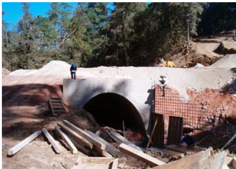
Fotografía 10: Construcción de bóvedas
