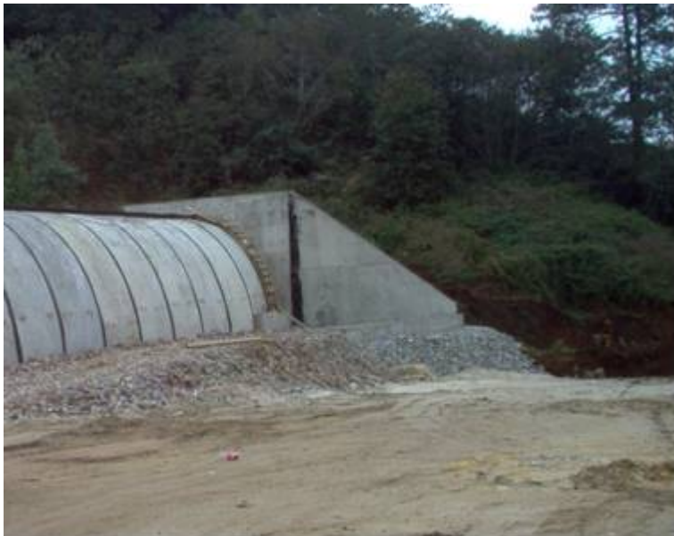
Fotografía 47: Pedraplenes de sustentación en las bóvedas.
