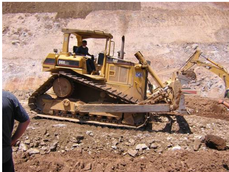
Fotografía 23: Equipo utilizado (Tractor D6R)
