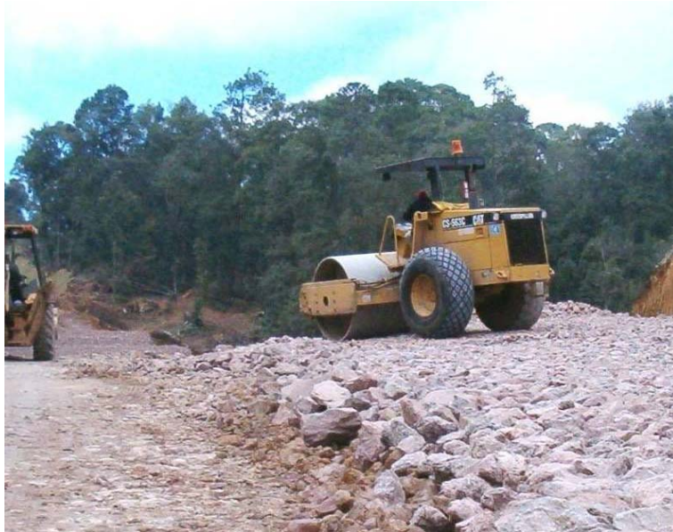
Fotografía 46: Compactación de pedrapelena.
