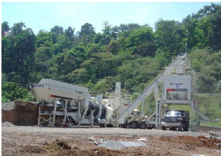
Fotografía 55: Transporte del concreto asfáltico.
