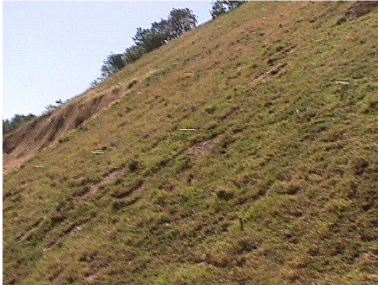
Fotografía 69: Drenes transversales de penetración
