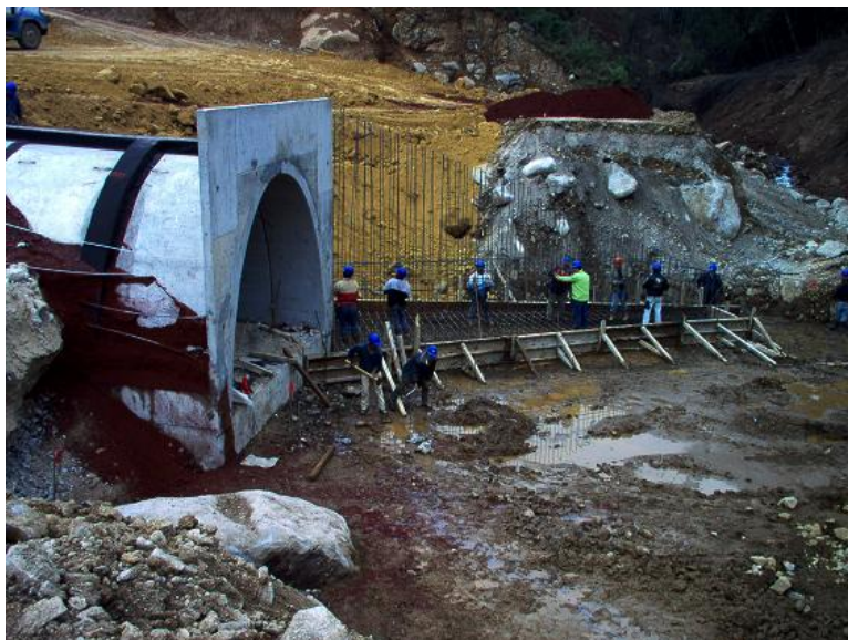
Fotografía 61: Construcción de muros en bóvedas
