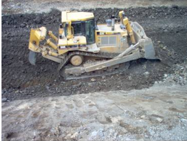
Fotografía 22: Equipo utilizado (Tractor D8R)
