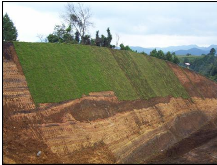
Fotografía 37: Revestimiento de taludes con pasto
