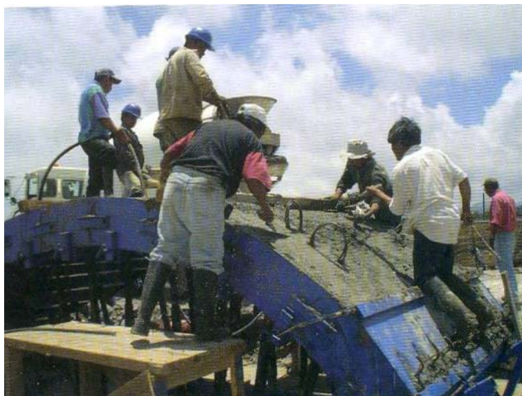
Fotografía 62: Colado de bóvedas
