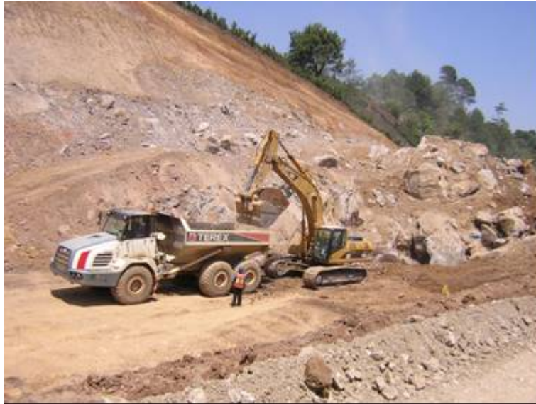
Fotografía 24: Equipo utilizado (Retroexcavadora)
