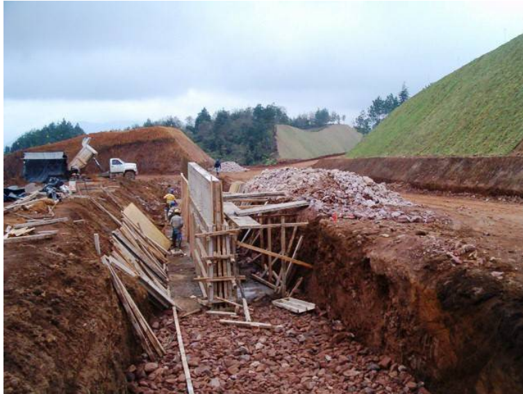
Fotografía 41: Muros Alcancía de concreto armado
