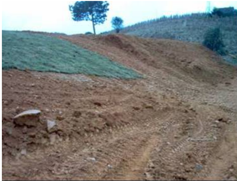
Fotografía 6: Revestimiento de los taludes de los bancos de tiro
