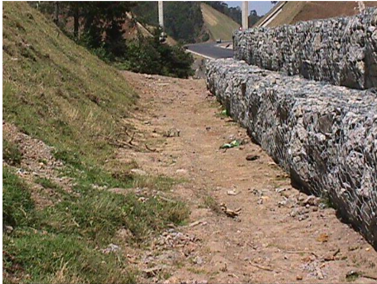
Fotografía 40: Vista trasera de los muros gavión.
