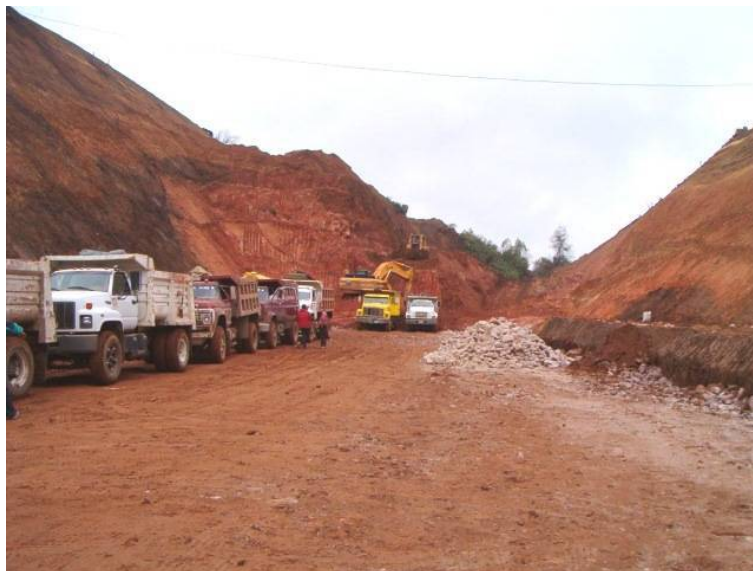
Fotografía 31: Proceso de corte en los frentes de trabajo
