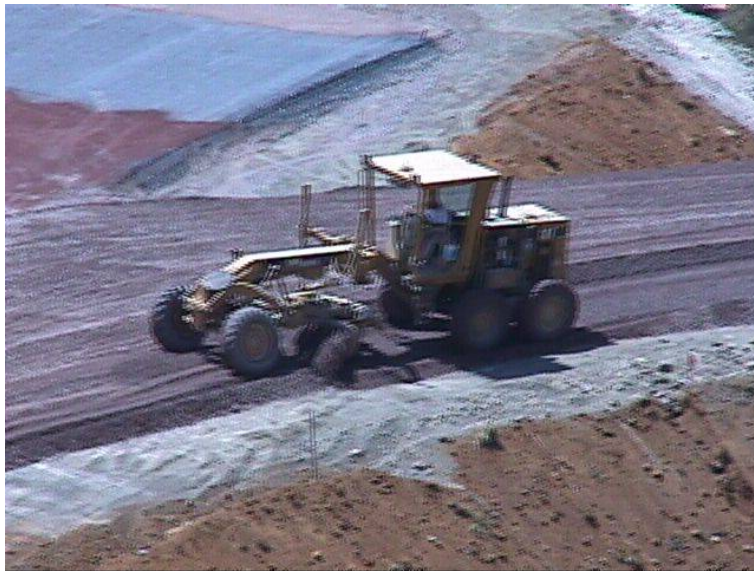
Fotografía 17: Equipo utilizado (Motoconformadora)
