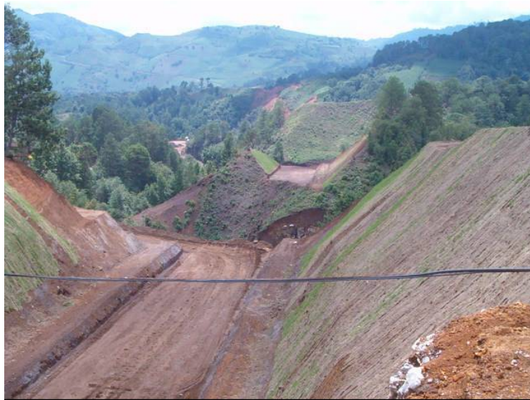
Fotografía 32: Proceso de corte terminado en los frentes de trabajo
