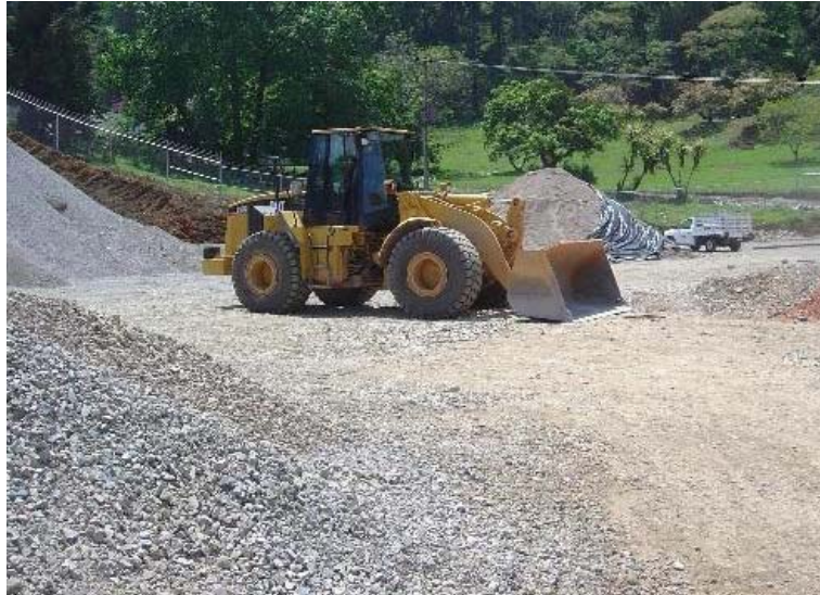
Fotografía 54: Patios de almacenamiento de material para asfalto.
