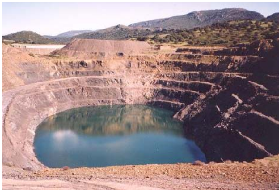
Figura 1.8.—Instalación minera en Almadrenejos, España
