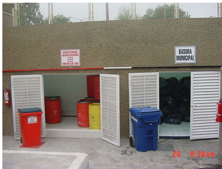
Vista frontal del almacén temporal de residuos Peligrosos y Biológico Infecciosos.
