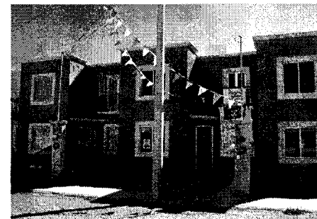
FACHADA 1ERA ETAPA CASA MUESTRA (BALCÓN)
