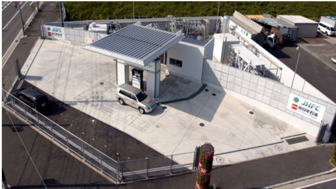
Figura A3.1, Estación de recarga de hidrógeno de Asahi, Yokohama.
