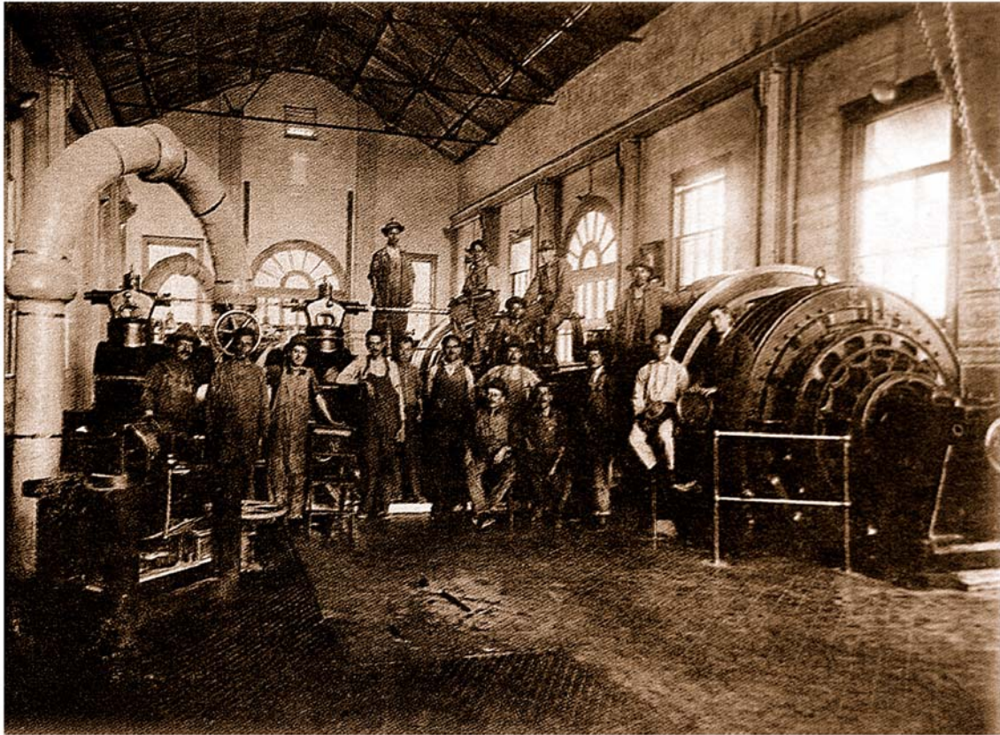
Fig. 82. "Vista interior de la Casa de Máquinas del Ferrocarril". Fondo Eduardo Saldivar, del AHEA, Fotografía No. 10
