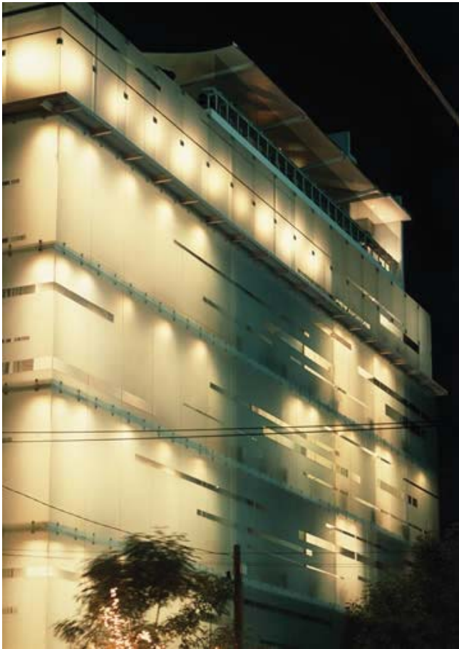
Hotel Habita Ciudad de México / TEN Arquitectos 2000
