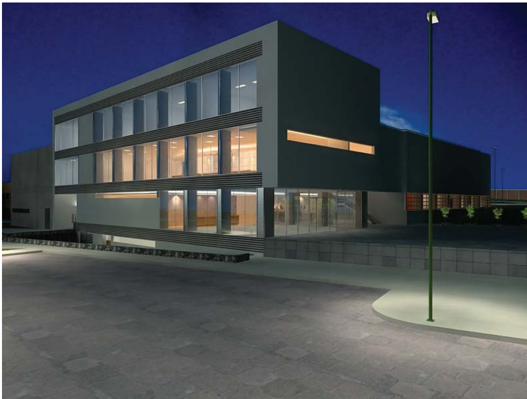
Vistas del edificio norte de la Coordinación. Transparencia de la fachada de cristal que permite observar el interior de la cafetería, el área administrativa y las aulas.
