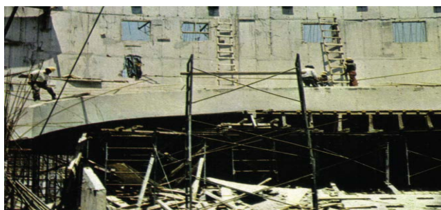
Construcción de la Sala Miguel Covarrubias, Centro Cultural, Ciudad Universitaria
