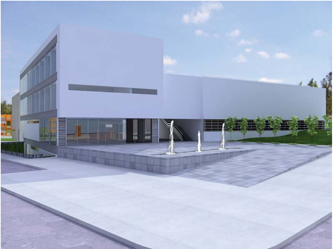
Plaza exterior y acceso principal al edificio de la Coordinación de Servicios Administrativos, CODESA.
