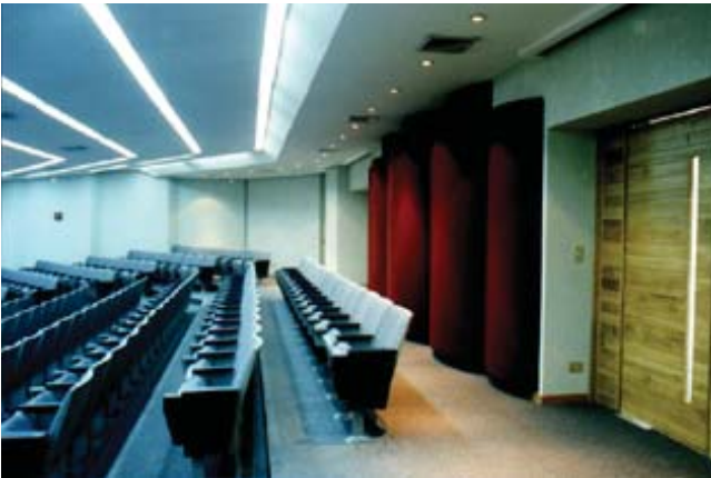
En estas aulas se utilizaron difusores policilíndricos para absorber las bajas frecuencias.
