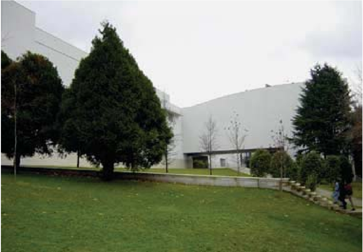
Vista del edificio de la Facultad de Estudios Informativos, Universidad de Santiago de Compostela
