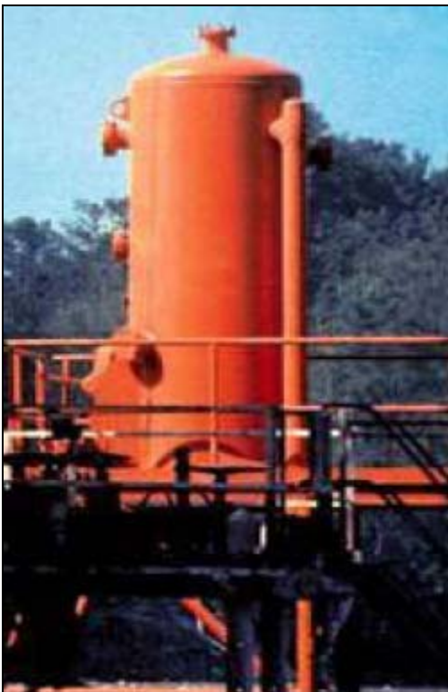
FIG. 3.12. DESGASIFICADOR ATMOSFÉRICO
