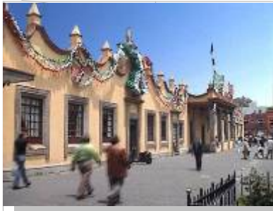
Grafico No. 17 Fachada del edificio Delegacional Ubicada en Jardín Hidalgo No. 1.
