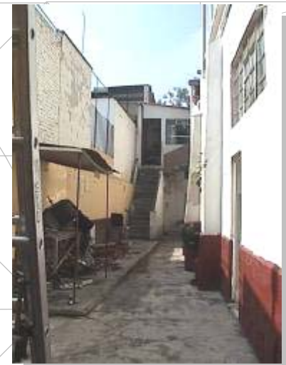
Grafico No. 35 Los desperdicios del mobiliario obstaculizan la circulación.
