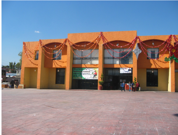
Nuevo edificio delegacional ubicado en el Centro Histórico de Xochimilco. Diciembre, 2006.
