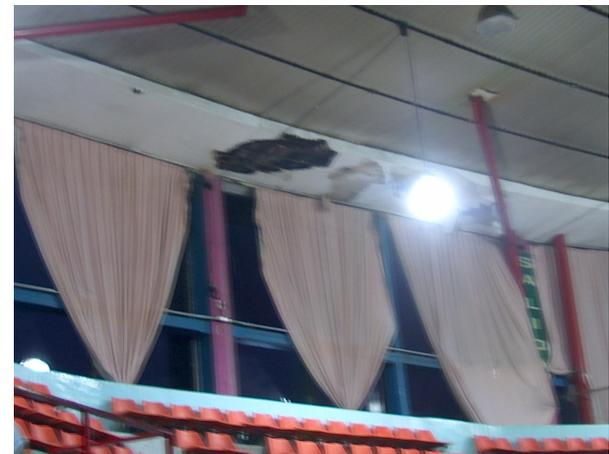
*Vista de interior de cubierta y de sección de plafón quebrado*
