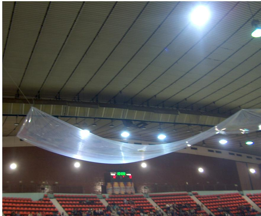
*Vista de interior de cubierta y de plástico para cubrir goteras.*
