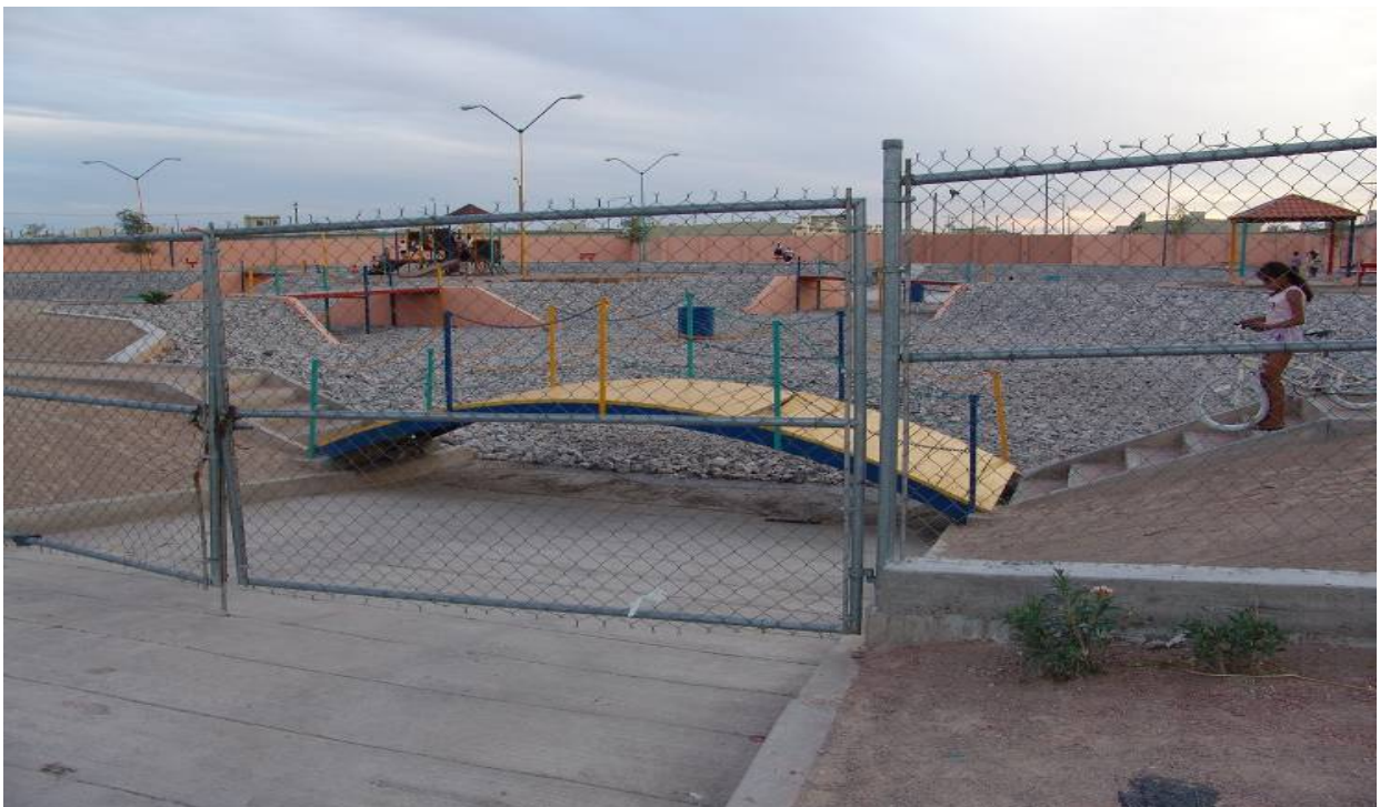
Foto 100. Área verde en Villas del Real. El área en realidad es un gigantesco pozo de absorción.
