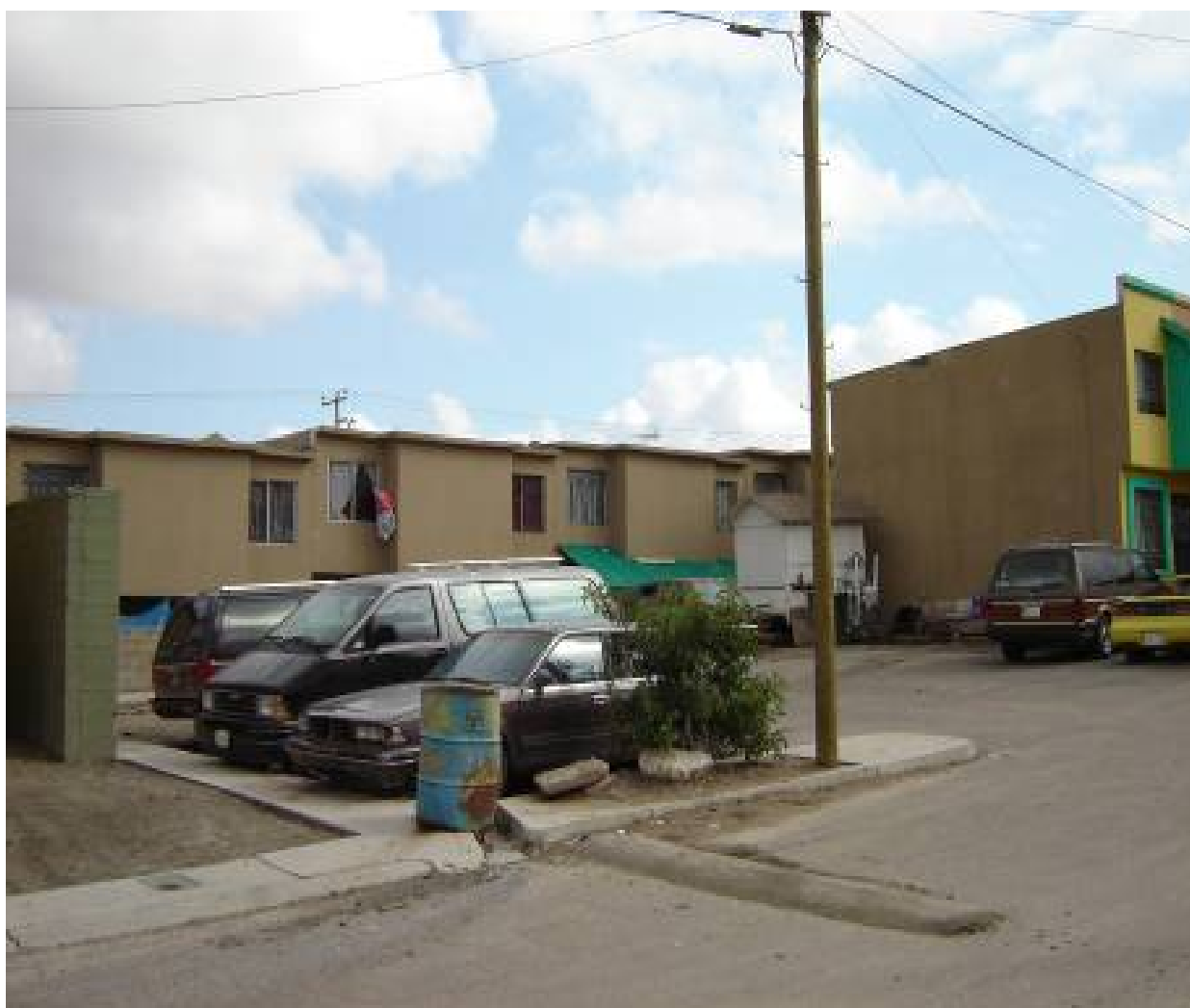
Foto 44. Estacionamiento común en Villa Fontana, Tijuana.
