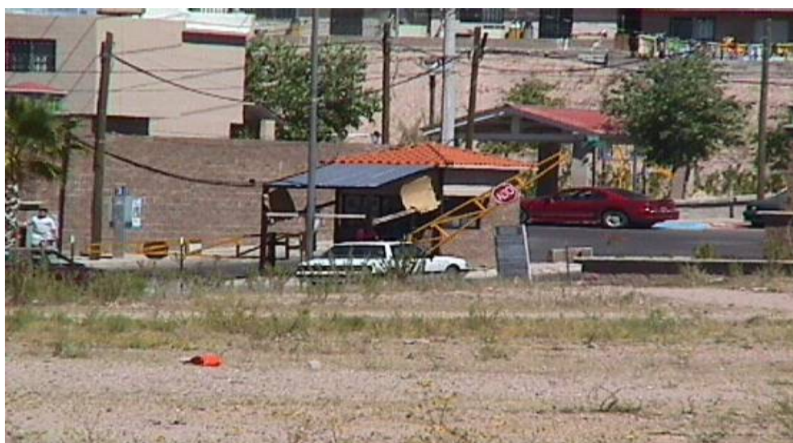
Fotos 122 y 123. Acceso Monumental y caseta de vigilancia en Nogales
