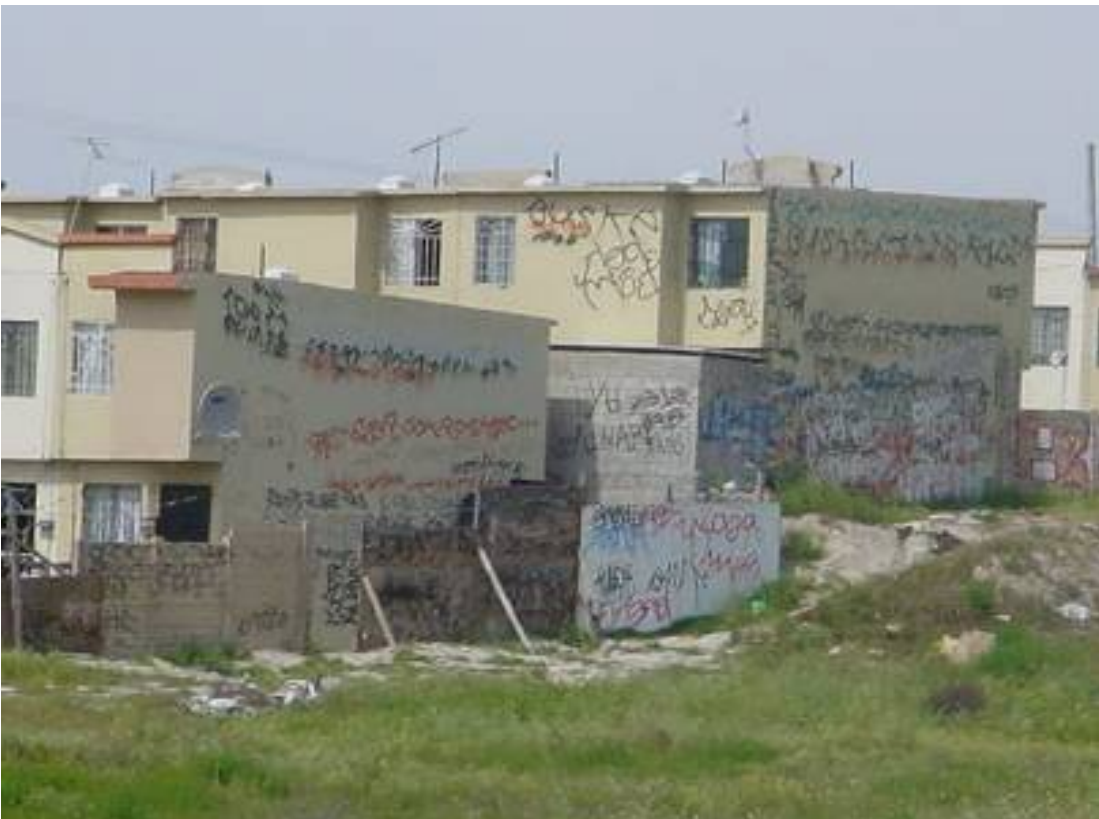
Foto 38. Vista de barda perimetral en Villa del Sol
