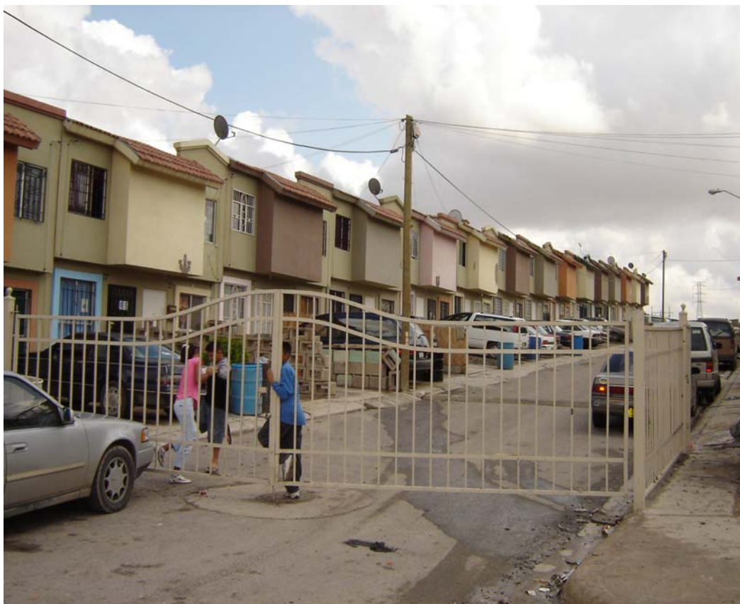
Foto 43. Puerta de acceso en Privada de Villa del Sol
