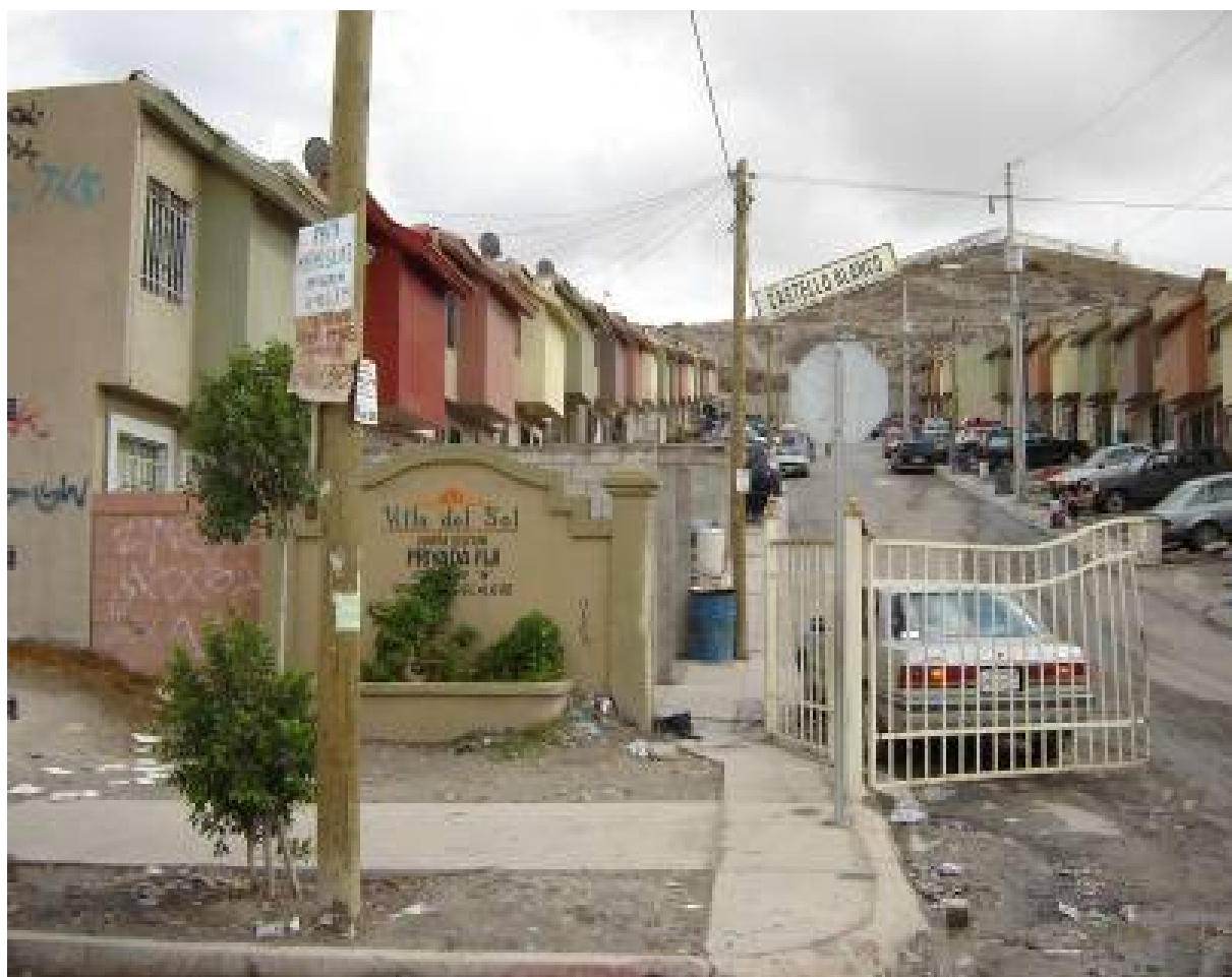
Foto 39. Deterioro y abandono de la privada en Villa del Sol
