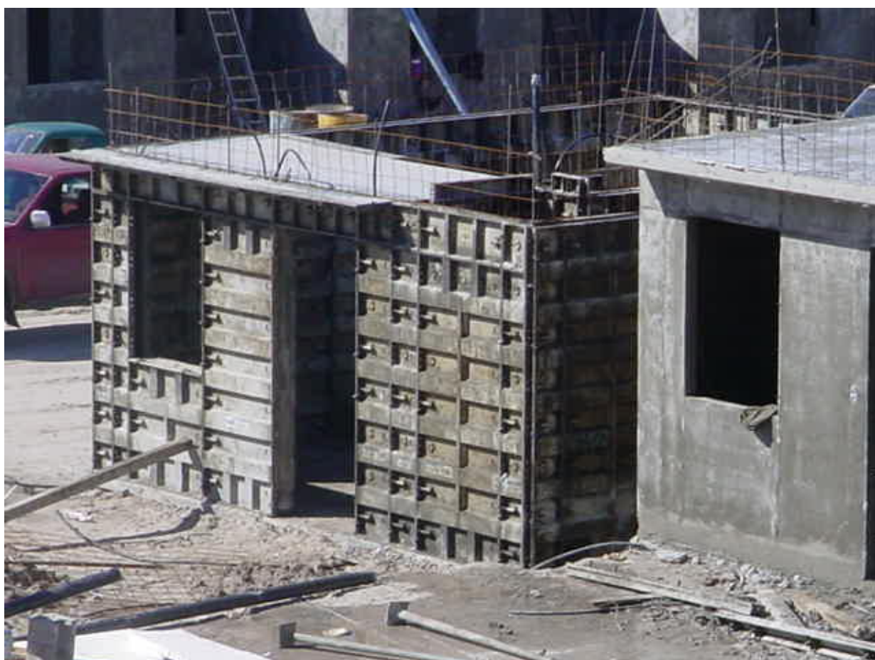
Foto 89. Detalle de construcción mediante moldes de concreto. Hacienda Casa Grande, Tijuana.
