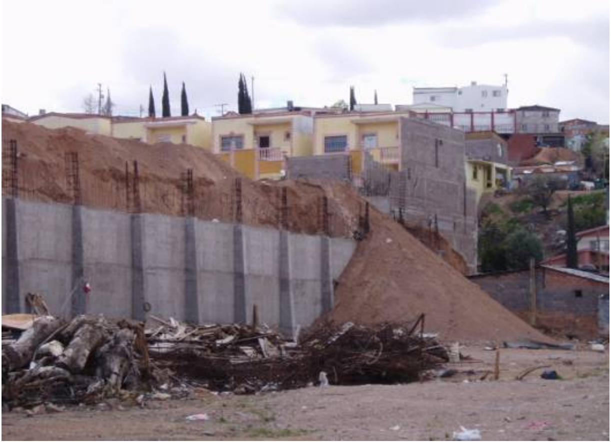
Foto 92. Muro de Contención, Los Girasoles
