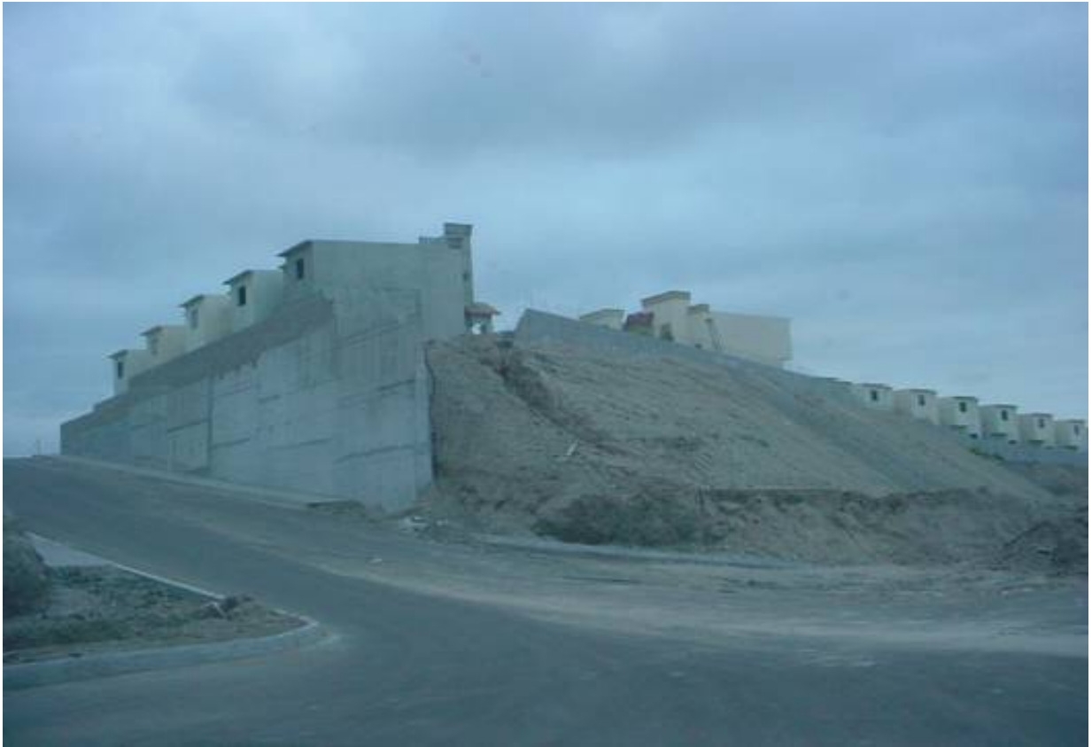
Foto 80 y 81. Cortes de tierra y muro de contención. Hacienda Casa Grande, Tijuana.
