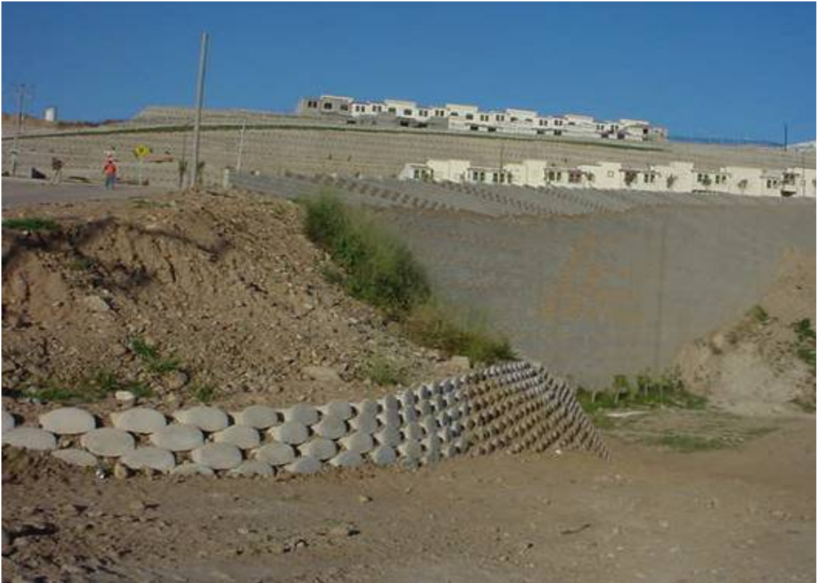
Foto 82 y 83. Muros de contención en residenciales medios. Sector de Agua Caliente
