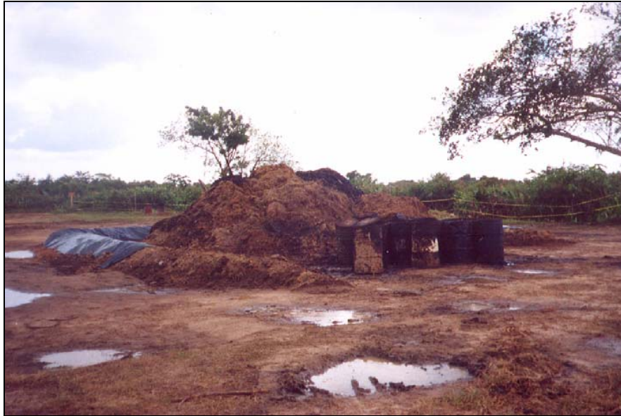
Figura III.2. Trabajos de restauración en el derrame del pozo Sánchez Magallanes No. 214, a 200 m al noreste de la Batería de separación Sánchez Magallanes 3, Col. La Trinidad, Cárdenas, Tabasco.
