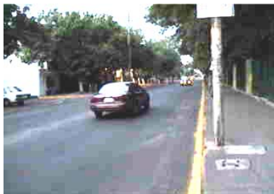
Foto 1. Vista de la Av. Redención hacia el Este. A la izq. se aprecia el acceso a las oficinas de Fuller.
