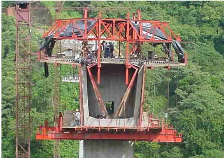
Figura III.32.- Carro de Colado. Cortesía de Freyssinet de México.
