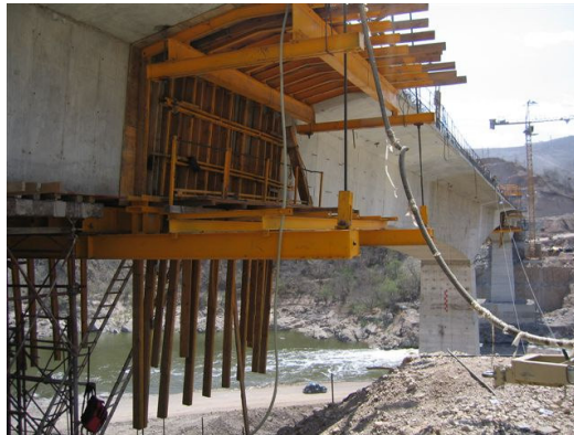
Figura III.44.- Fabricación de la dovela de cierre. Cortesía de Freyssinet de México.
