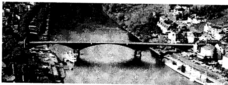
Figura 1.6.- Puente sobre el Mosela en Coblenza
