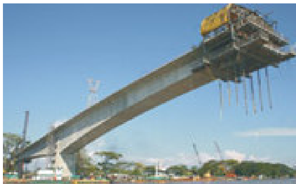
Figura III.31.- Construcción de un puente en doble voladizo.
