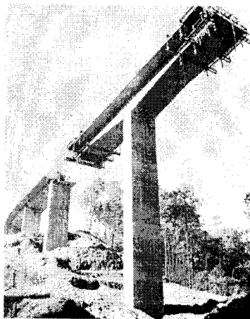
Figura I.35.- Construcción del puente Totolapa.
