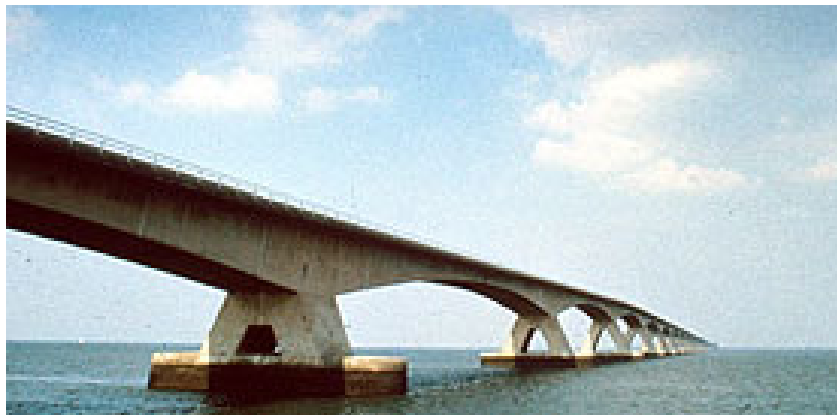
Figura III.6.- Puente sobre el Escalda Oriental, Holanda.
