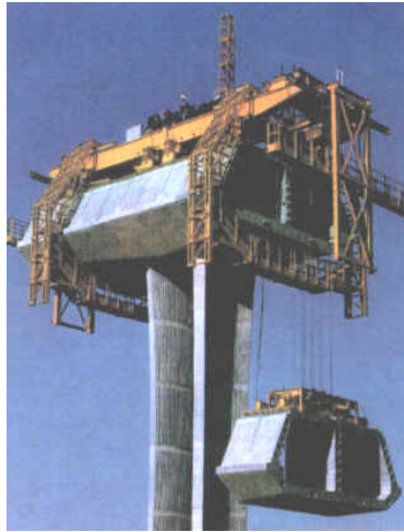
Figura III.3.- Construcción en voladizo usando piezas prefabricadas.
