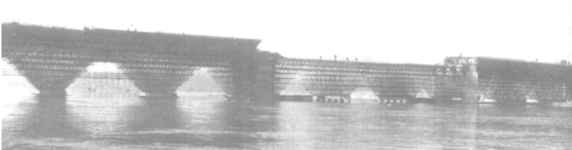
Figura III.1.- Andamiaje para la construcción del puente sobre el Po en Italia.
