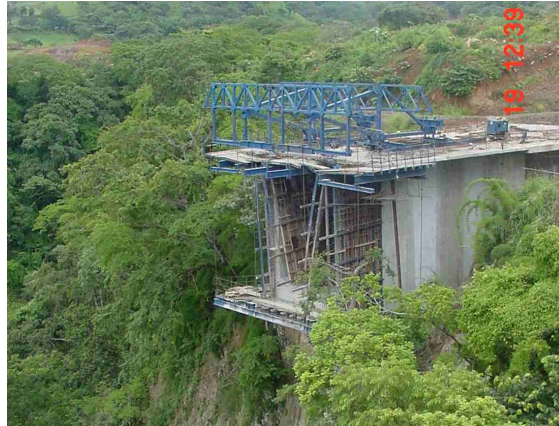
Figura III.42.- Dovela de estribo. Cortesía de Freyssinet de México.
