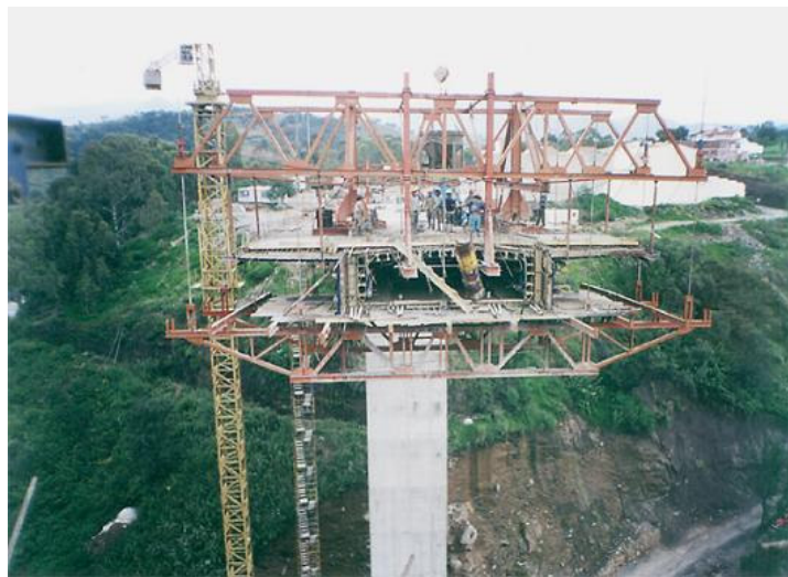
Figura III.34.- Carro de Colado. Cortesía de Mexpresa.
