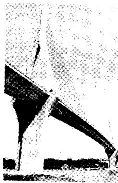
Figura I.32.- Puente Ing. Antonio Dovalí Jaime, terminado.
