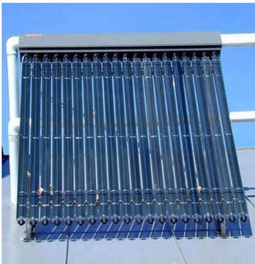
**Figura 14.** Aspecto físico de un sistema de colectores de vacío. **Fuente:** textoscintificos.
