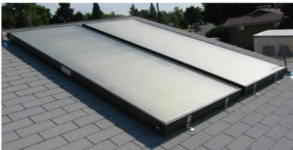
**Figura 10.** Generalmente los colectores planos de baja temperatura son instalados en azoteas.
