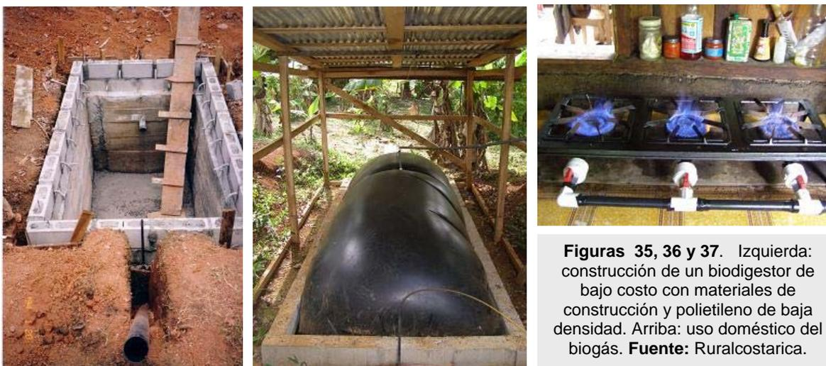
**Figuras 35, 36 y 37.** Izquierda: construcción de un biodigestor de bajo costo con materiales de construcción y polietileno de baja densidad. Arriba: uso doméstico del biogás. **Fuente:** Ruralcostarica.
