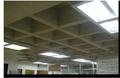
Losa reticular de concreto armado
