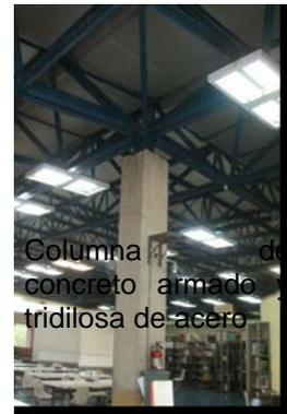
Columna de concreto armado, tridilosa de acero
