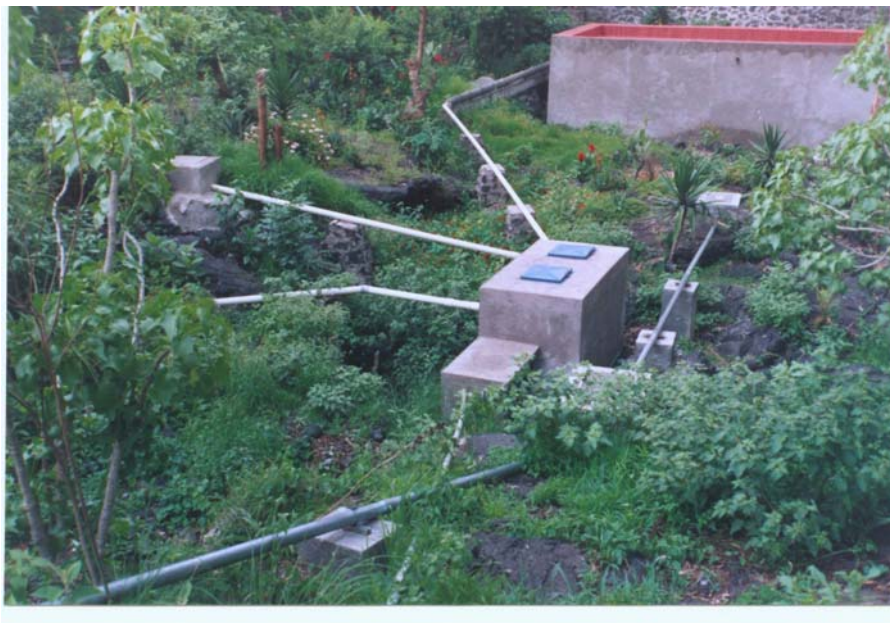
Figura 3.2c Fotografía de los sedimentadores primarios del humedal artificial de flujo vertical localizado en la Zona Cultural de la Ciudad Universitaria
