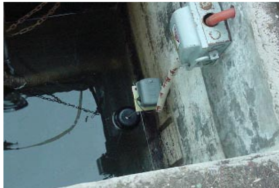
Figura A4.7 Vista desde arriba de la cisterna de salida del humedal de Viveros de Coyoacán
