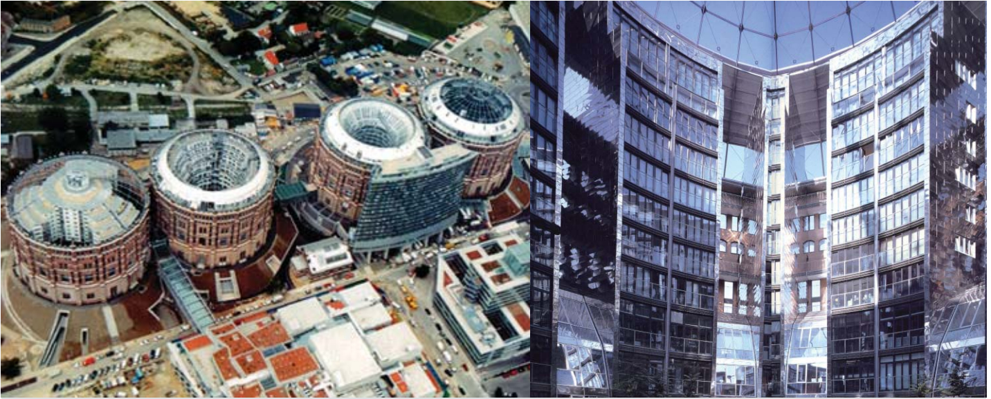
Viviendas “Gasómetros” en Viena
