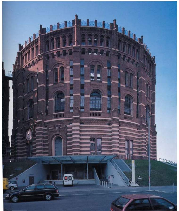
Gasómetro de Jean Nouvel
