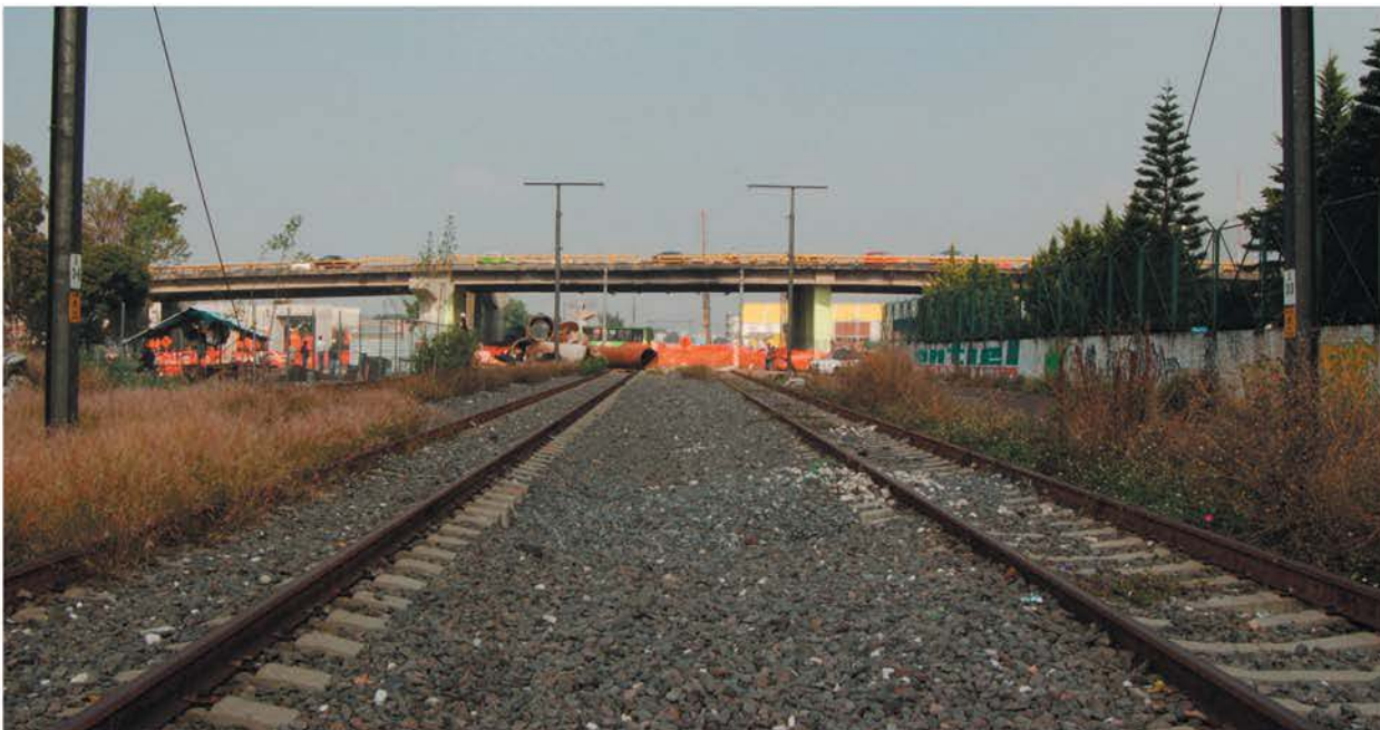
Imagen desde las vías del tren hacia circuito interior, lo que reafirma lo encapsulada que se encuentra la colonia dentro de la ciudad.
