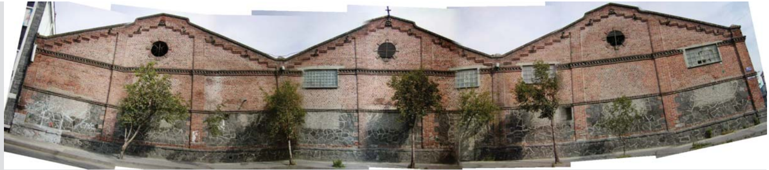
Fachada calle Clavel
