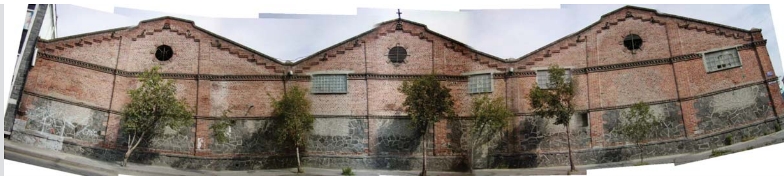
Fachada calle Clavel
