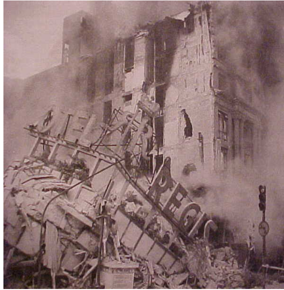
Hotel REGIS derrumbado.
