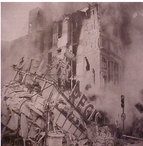
Hotel REGIS, Derrumbado en pleno centro de la Ciudad.
