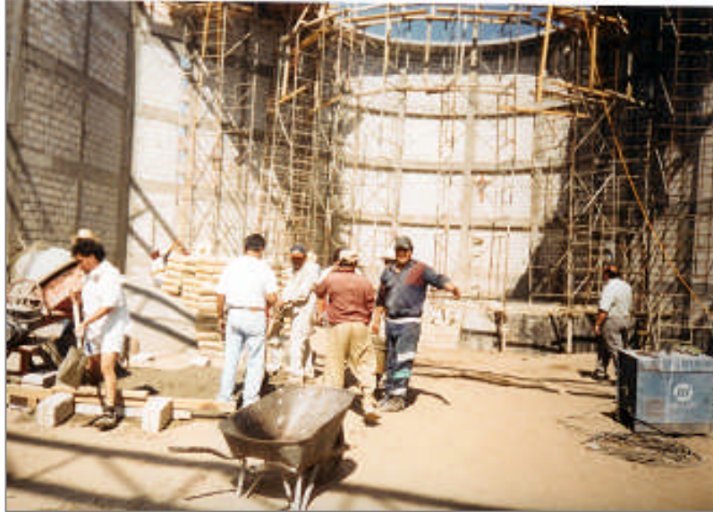
Grupo de albañiles Tlaxiaqueses trabajando en faenas para la primera etapa en el presbiterio del nuevo templo parroquial. 2002
