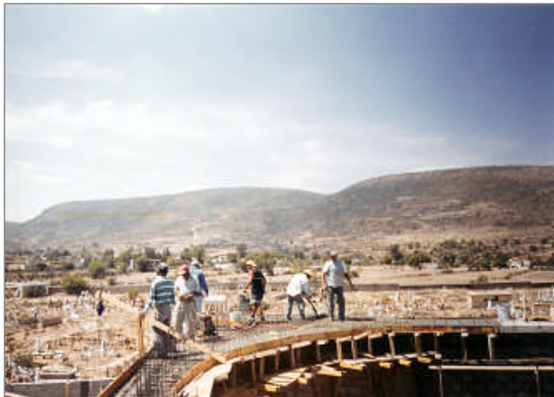
Grupo de albañiles Tlaxiaqueses trabajando en faenas para la primera etapa en el anillo del presbiterio del nuevo templo parroquial. 2002
