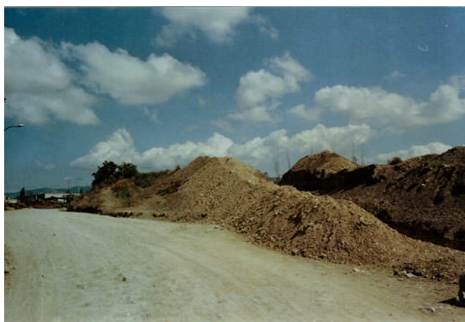
Movimiento de tierras para mejorar el terreno. Mayo del 2000.
