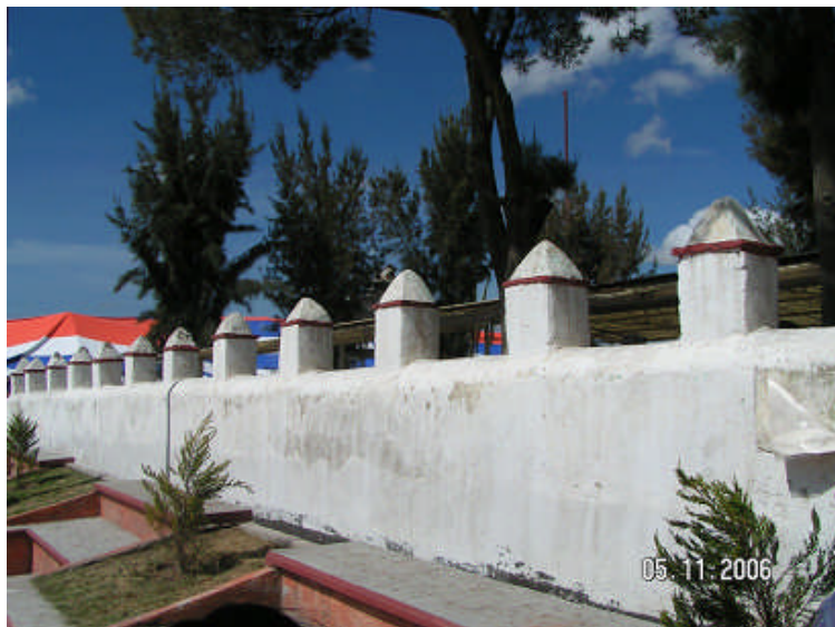
Muro perimetral de la parroquia de San Agustín Tlaxiaca, fachada sur-este.
