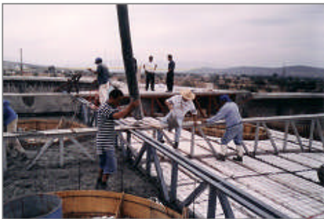
Tendido de concreto con bomba en la azotea.
