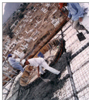
Tendido de concreto lado sur.
