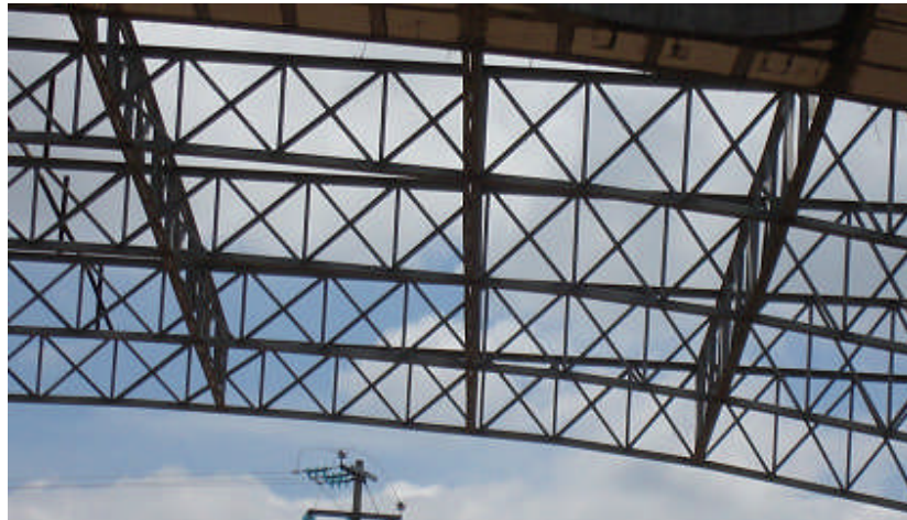
Vista frontal inferior de la estructura primaria y secundaria, en el templo parroquial
