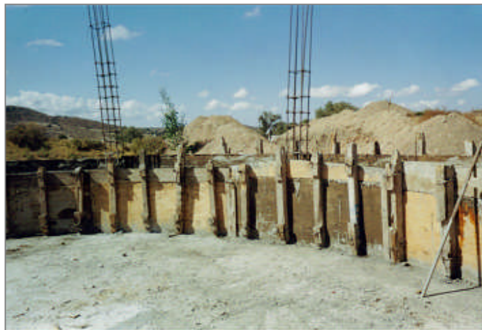
Construcción del muro en el presbiterio y losa del sótano
