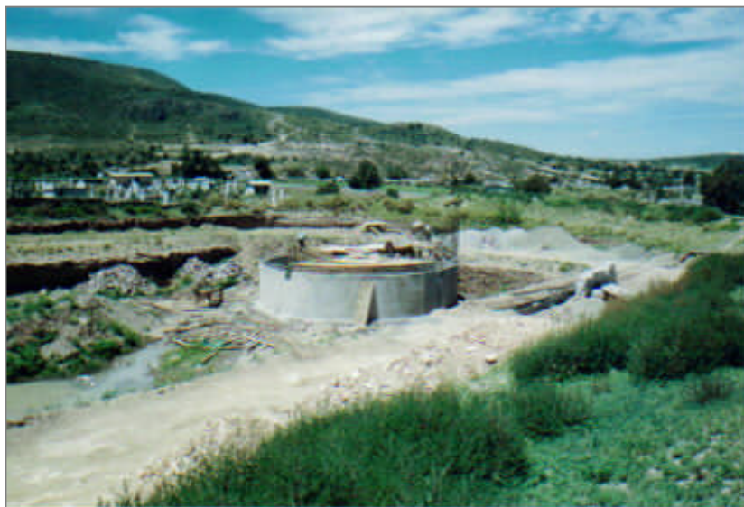
Primera etapa de construcción correspondiente al presbiterio, 2000.
