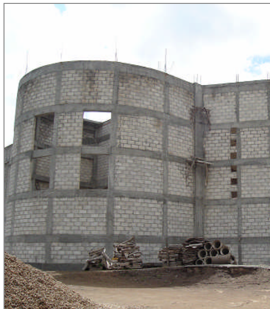
Muros de block, muro exterior del baptisterio, nuevo templo parroquial.
