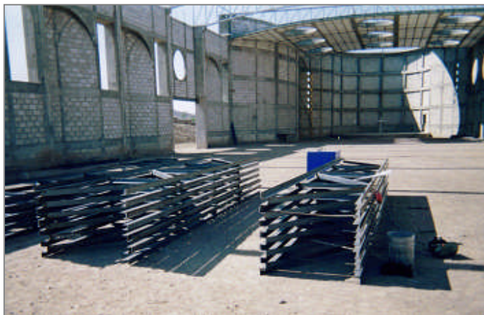
Secciones de armaduras metálicas, En el nuevo templo parroquial.
