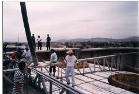
Colado con bomba en la segunda etapa del templo.
