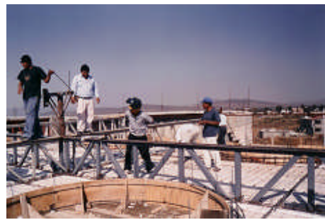
Soldadores trabajando en la soldadura de las armaduras.
