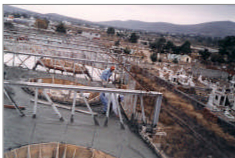
Enrase de concreto en segunda etapa.
