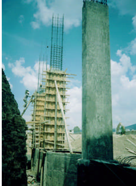
Cimentación del lado poniente, con columnas, Armado, cimbrado y colado, en el nuevo templo Parroquial San Agustín Tlaxiaca.
