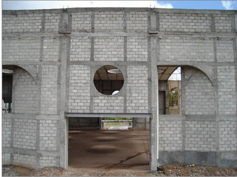
Muros de block, acceso sur, nuevo templo parroquial.
