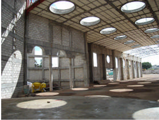
Vista interior en perspectiva de cúpulas terciarias y baptisterio, muro norte.
