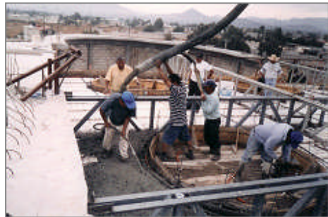
Tendido de concreto en azotea.
