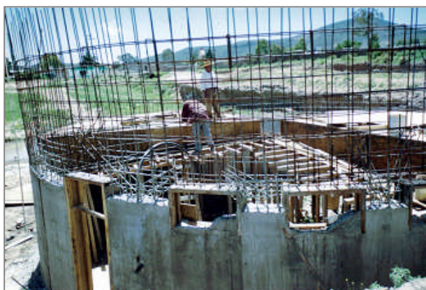
Construcción del sótano, criptas mortuorias. 2000.
