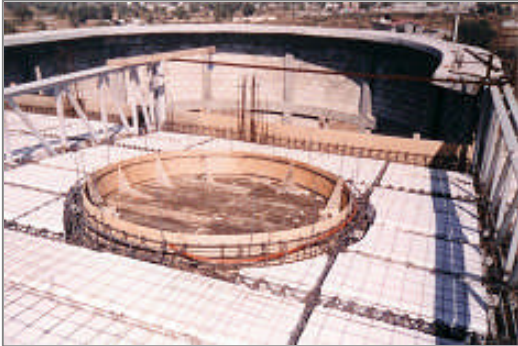
Anillo de cúpula terciaria en la segunda etapa.
