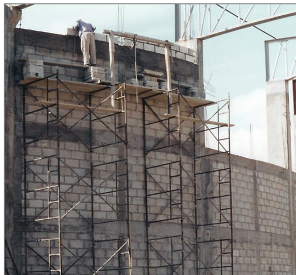
Construcción de muros del nuevo templo. Muro lateral sur.
