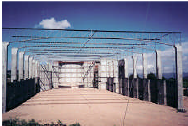
Construcción de muros por la mitad, del nuevo templo.
