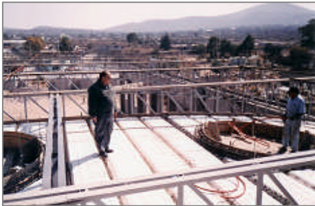
Tendido de vigueta y bovedilla, para colado, cúpulas terciarias.
