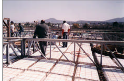
Combinación de dos sistemas constructivos, estructura metálica con viga y bovedilla.
