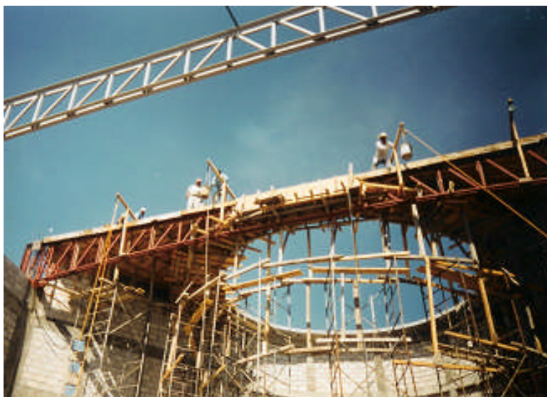
Grupo de albañiles Tlaxiaqueses subiendo concreto para el colado de la primera etapa en el anillo del presbiterio del nuevo templo parroquial. 2002
