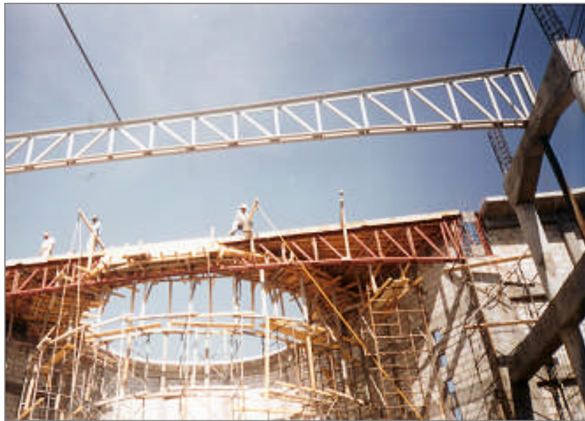
La primera etapa del colado fue en la cubierta del presbiterio. Nuevo templo parroquial S.A.T
