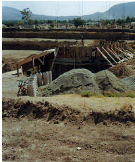
Construcción del muro en el presbiterio
