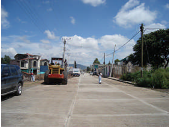
Calle Niños Héroes, acceso lateral izquierdo al nuevo Templo. Cemento y elementos arquitectónicos, calle pavimentada.
