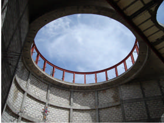
Ábside del presbiterio, cúpula mayor.
