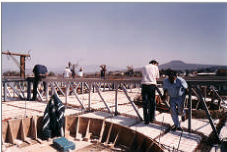
Cimbra de cúpulas terciarias.
