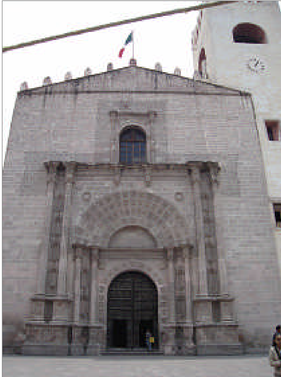
Fachada principal del Exconvento Agustino del siglo XV, en Actopan Hidalgo.
