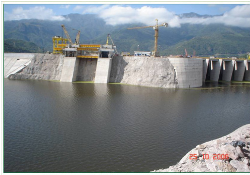
Figura 10. Proyecto Hidroeléctrico “El Cajón”
