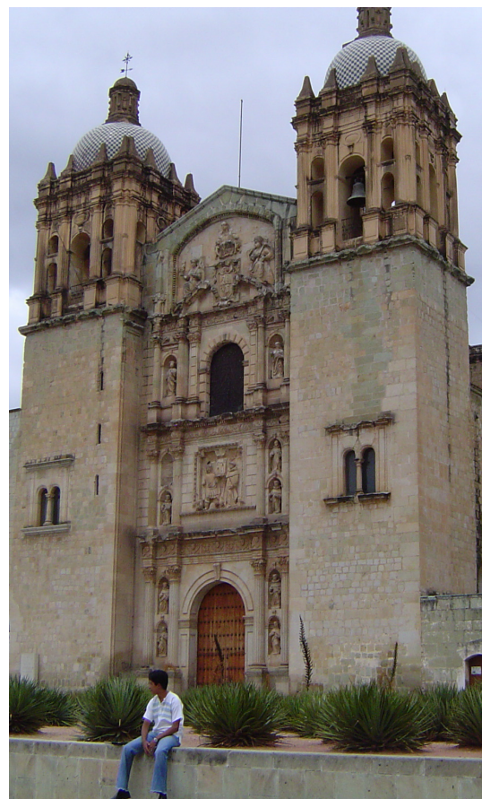
fig.2 Fachada del Templo de Santo Domingo Oaxaca
