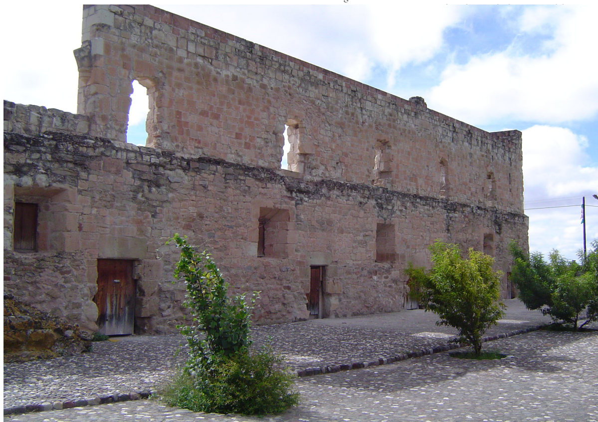
fig.23 Fachada oriente del convento de Yanhuitlán
