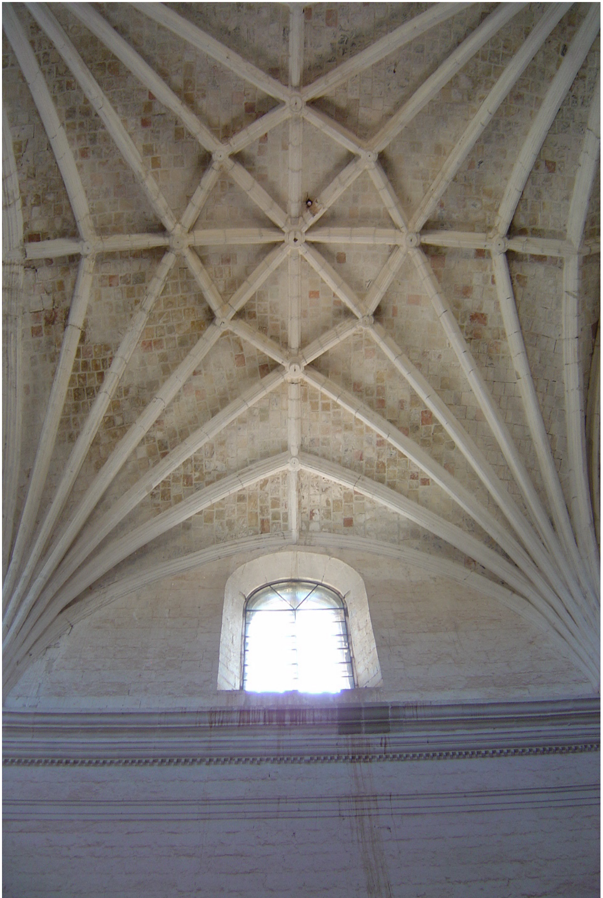
fig.3 Cruceria de la cubierta del templo de Santo Domingo Yanhuitlan
