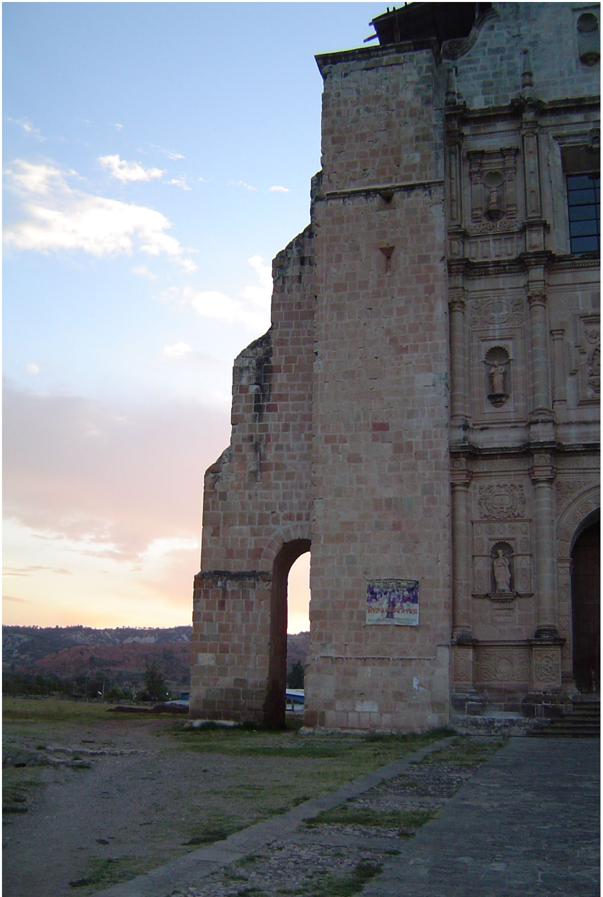
fig.30 Contrafuerte de la fachada principal Yanhuitlán
