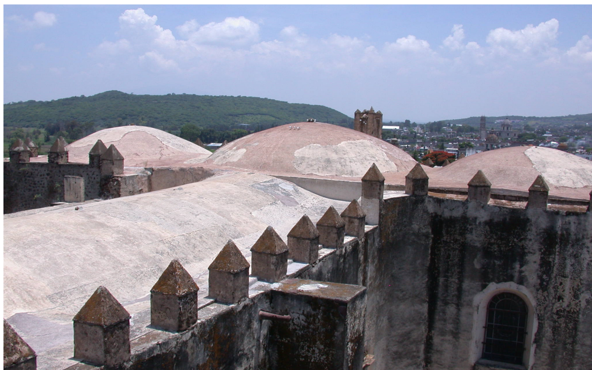
fig.14 abajo Techumbre de Boveda en Medio cañon corrido y Cúpulas del Templo rematadas con almenar, Yuririapundaro
