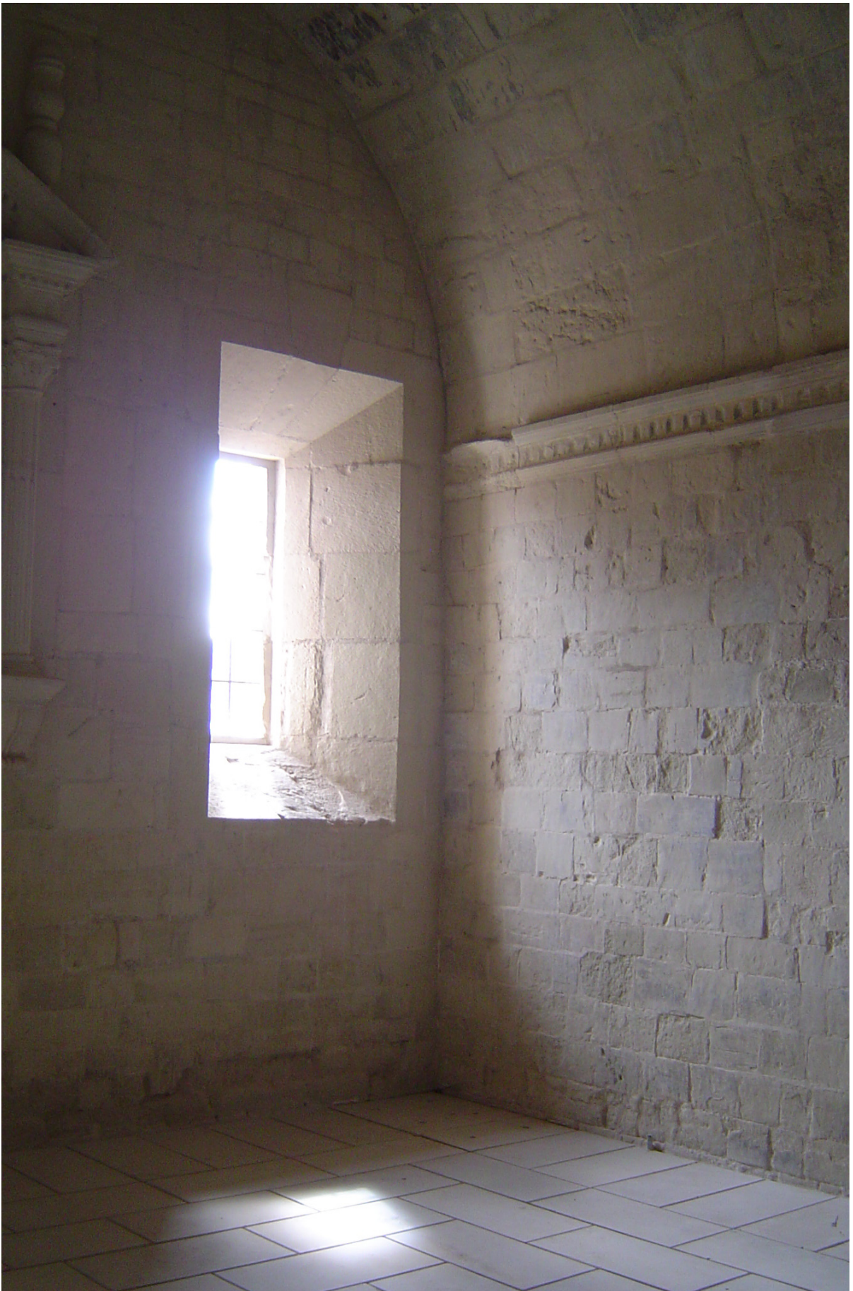
fig.43 Ventana con vano de doble vista al interior del refectorio del convento de Yanhuitlán
