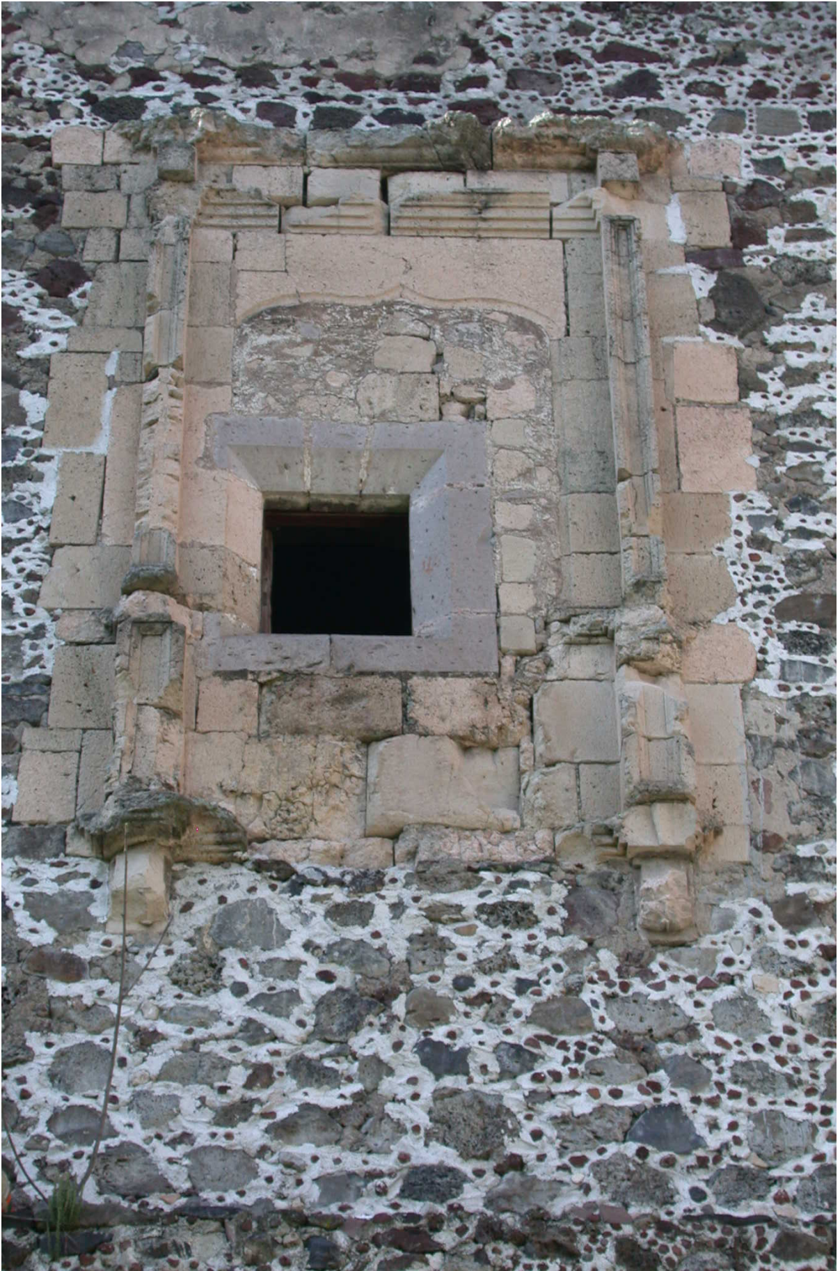
fig.33 Detalle de adosamineto de ventana en el convento de Yuriria
