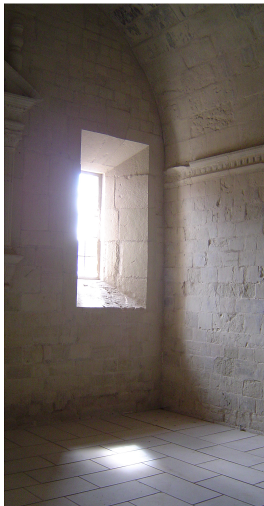
fig.29 Detalle de ventana en el Refectorio al interior del claustro de Yanhuitlan
