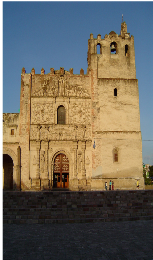
fig.19 Fachada del convento de Yurirapundaro
