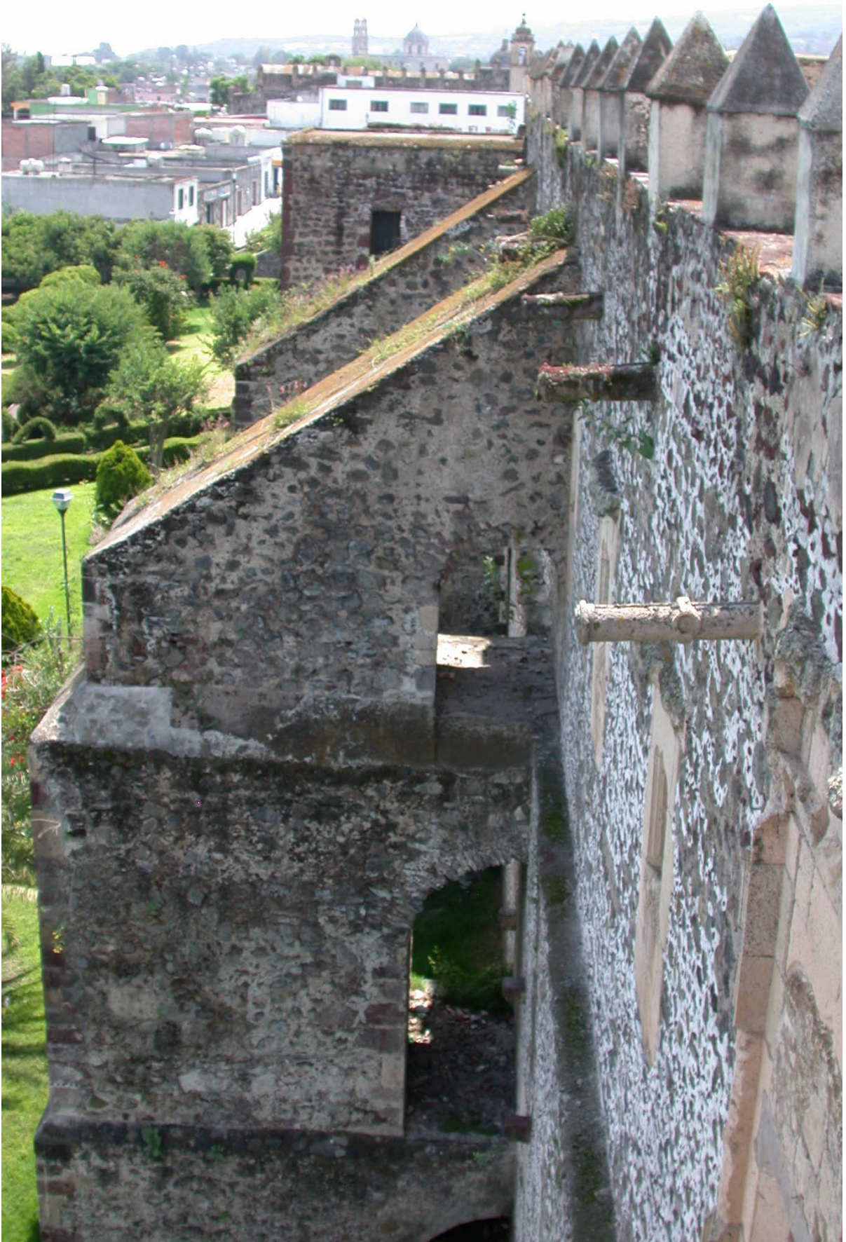
fig.32 Vista de los contrafuertes norte del convento de yuriria
