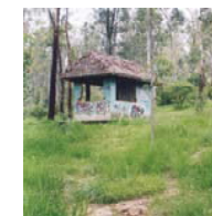
Fig. 21 Caseta de vigilancia en abandono
