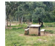
Fig. 20 Mesa bancos en malas condiciones
