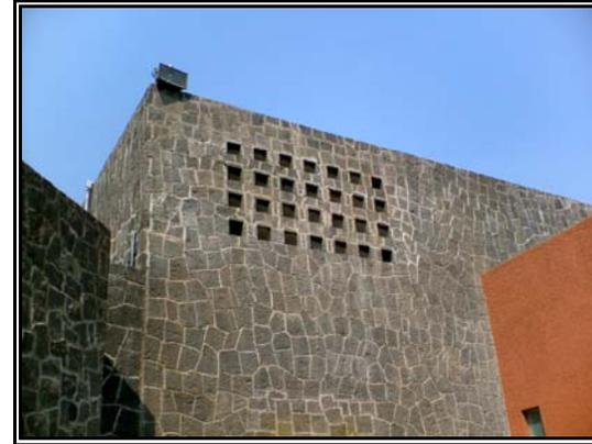
Ilustración 6. Muros aparentes de roca volcánica.
