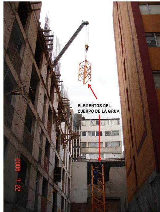
Imagen 4.26 Retiro de lastres de bancada Imagen 4.27 Desarmado del cuerpo de la grúa torre
