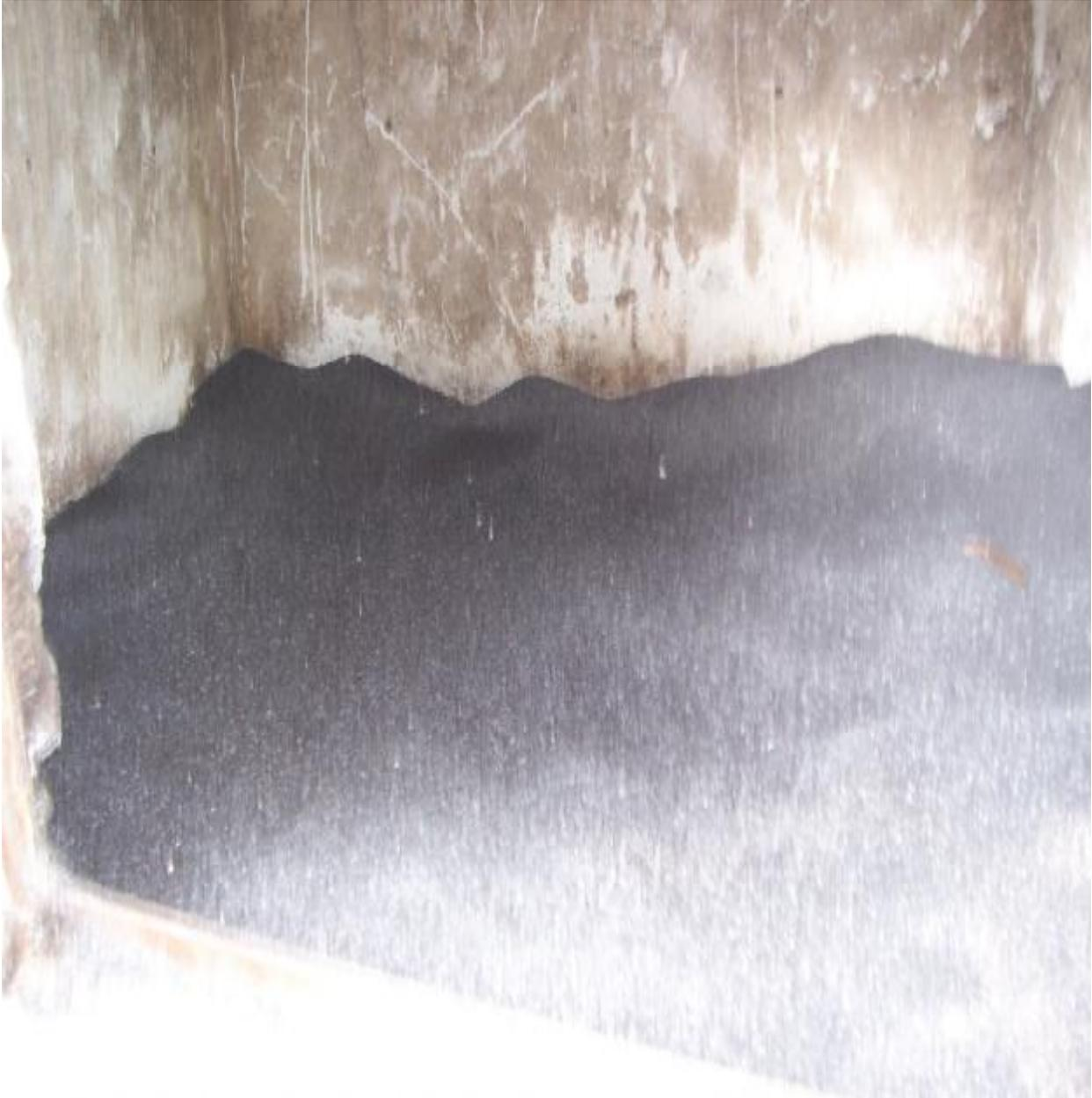
Por la ineficiencia de la chimenea para mitigar los malos olores, fue necesario cubrir la parte baja de la misma con carbón activado, las manchas blanquecinas son señal de la saturación que como ya se ha mencionado se alcanza rápidamente por las grandes cantidades de gases generados.
