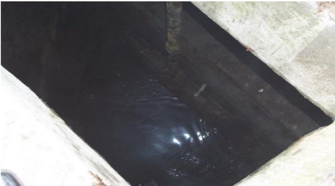
En el interior de la lumbrera se realizan actividades de mantenimiento, medición de flujos y alturas del caudal así como el retiro de sólidos que obstruyen la circulación de las aguas residuales y azolvan las compuertas.
