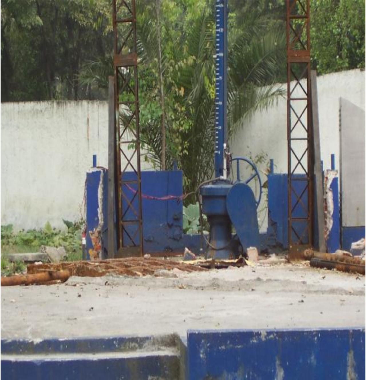
Parte superficial de una lumbrera, en donde se aprecian la estructura metálica conocida como “compuerta de control”, su función consiste en detener el paso del agua residual, cuando se requiere realizar actividades de mantenimiento.
