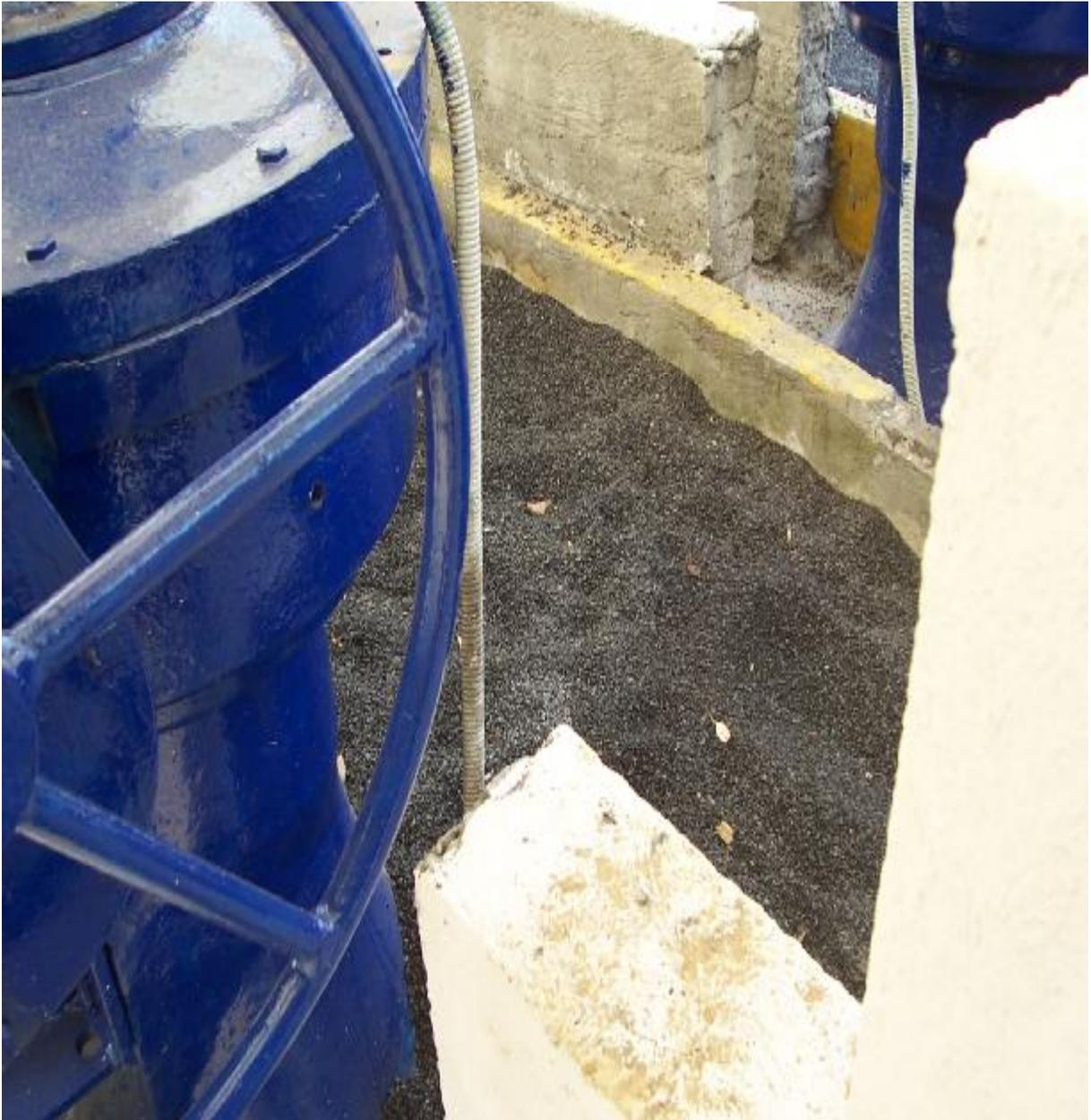
En la compuerta de control es necesario cubrir las rejillas existentes con una capa de carbón activado, para evitar que los gases generados en el interior de la lumbrera dañen por corrosión las estructuras metálicas y al mismo tiempo evitan que el mal olor se disperse en la superficie de la zona donde se encuentra ubicada, el espesor varía entre 15 y 30 cm.
