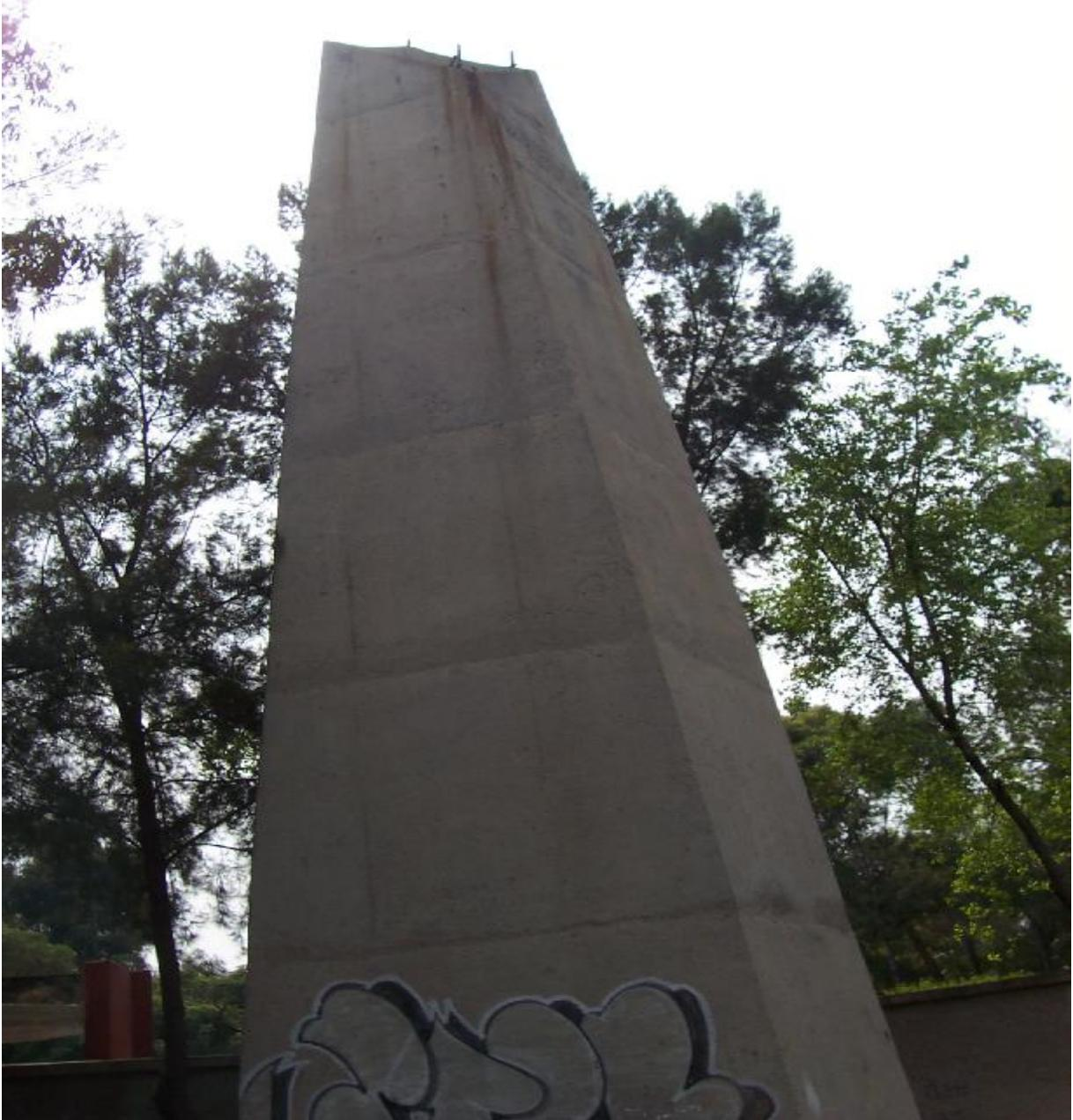
La estructura de concreto identificada como chimenea, tiene la función de conducir los gases generados en el interior de la lumbre hacia el exterior con la finalidad de diluir la concentración con el aire del ambiente, su altura es variable (de 8 m en adelante), depende generalmente de la altura de las casas habitación que se ubican en la zona.
