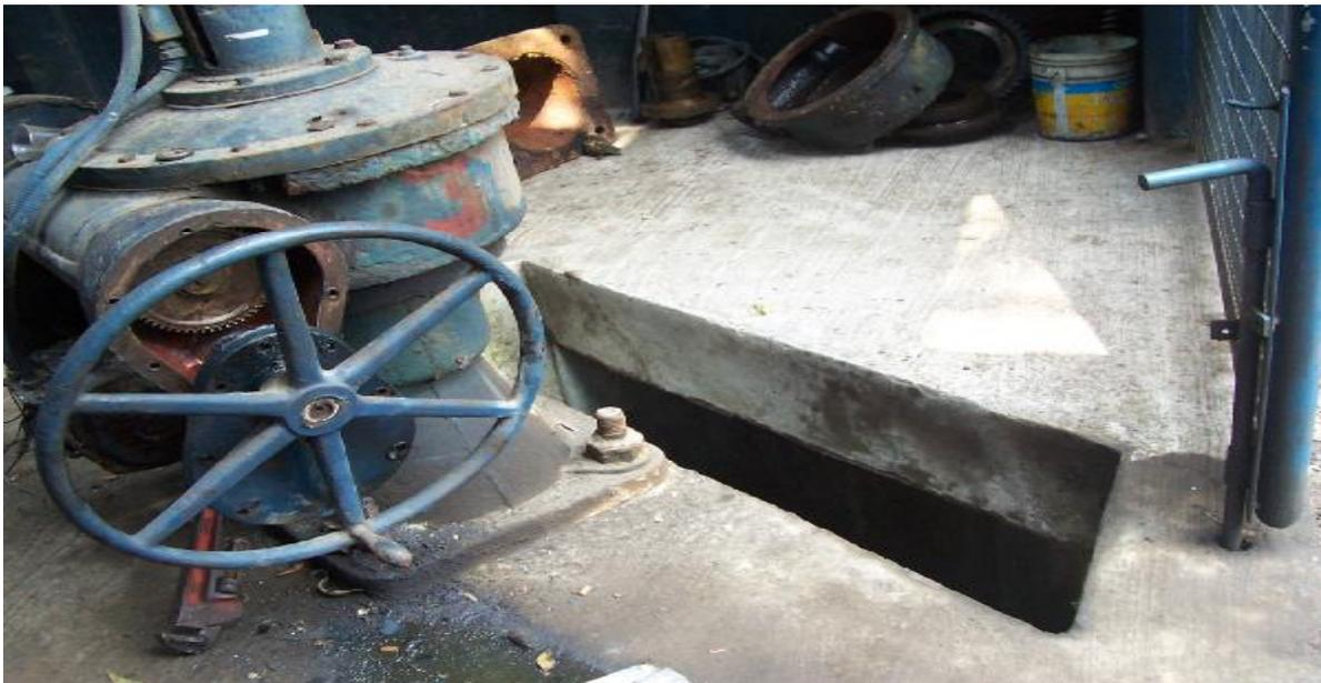
En algunas lumbreras es retirado el carbón activado para realizar actividades de mantenimiento, esto permite la salida del ácido sulfhídrico al ambiente de trabajo, ocasionando molestias de salud al personal operativo por las altas concentraciones.
