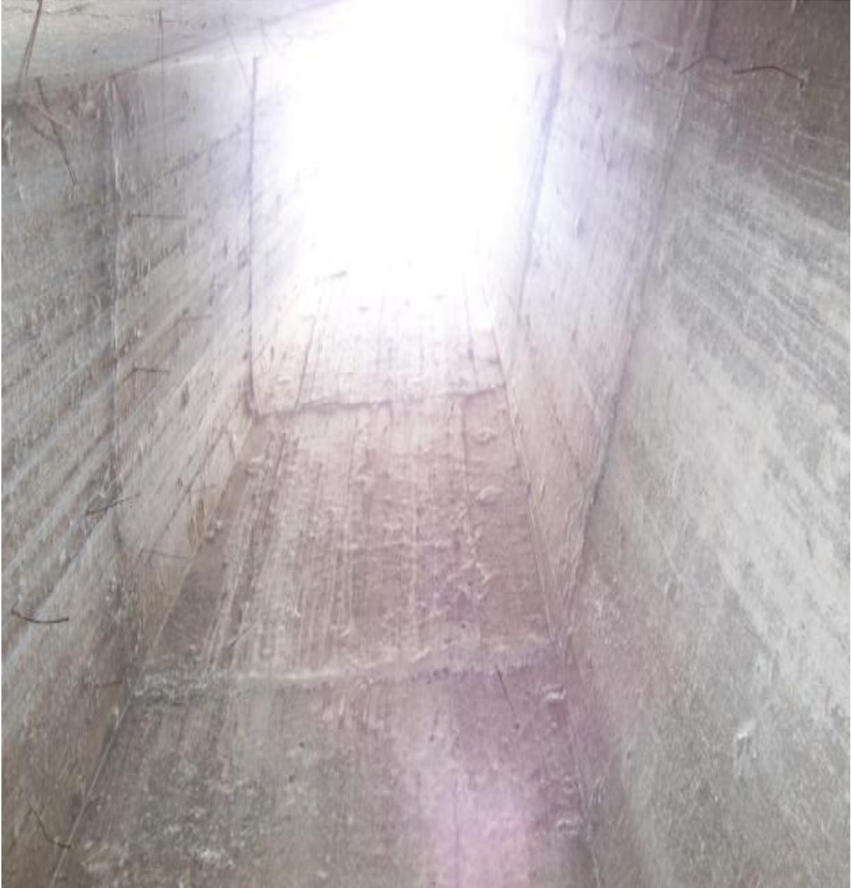
En el interior de la chimenea por el recorrido de los gases, se aprecia el desgaste en las paredes por corrosión, no existiendo ningún medio de protección.
