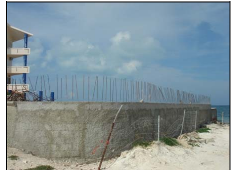
4.- Vista muro de contención.
