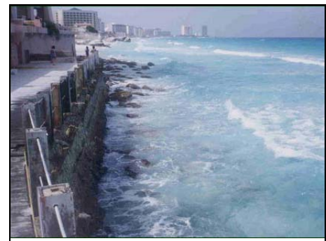
6.- Otra vista zona federal marítima.
