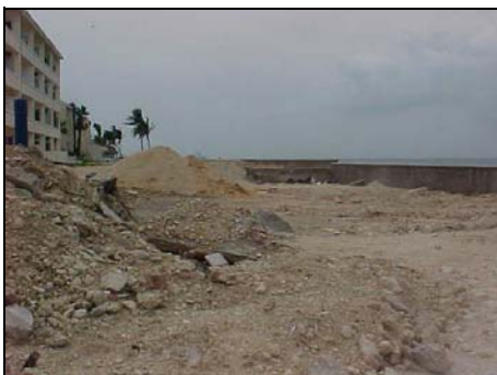
7.- Trabajos adecuación y reforzamiento.
