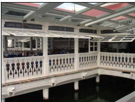
7.- Aspecto interior restaurante.
